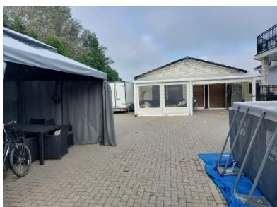
Figuur 2.9 Uitbreidingslocatie 3: Kijkrichting noordwesten.
