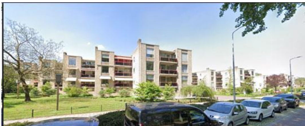
Aanzicht bestaande situatie
