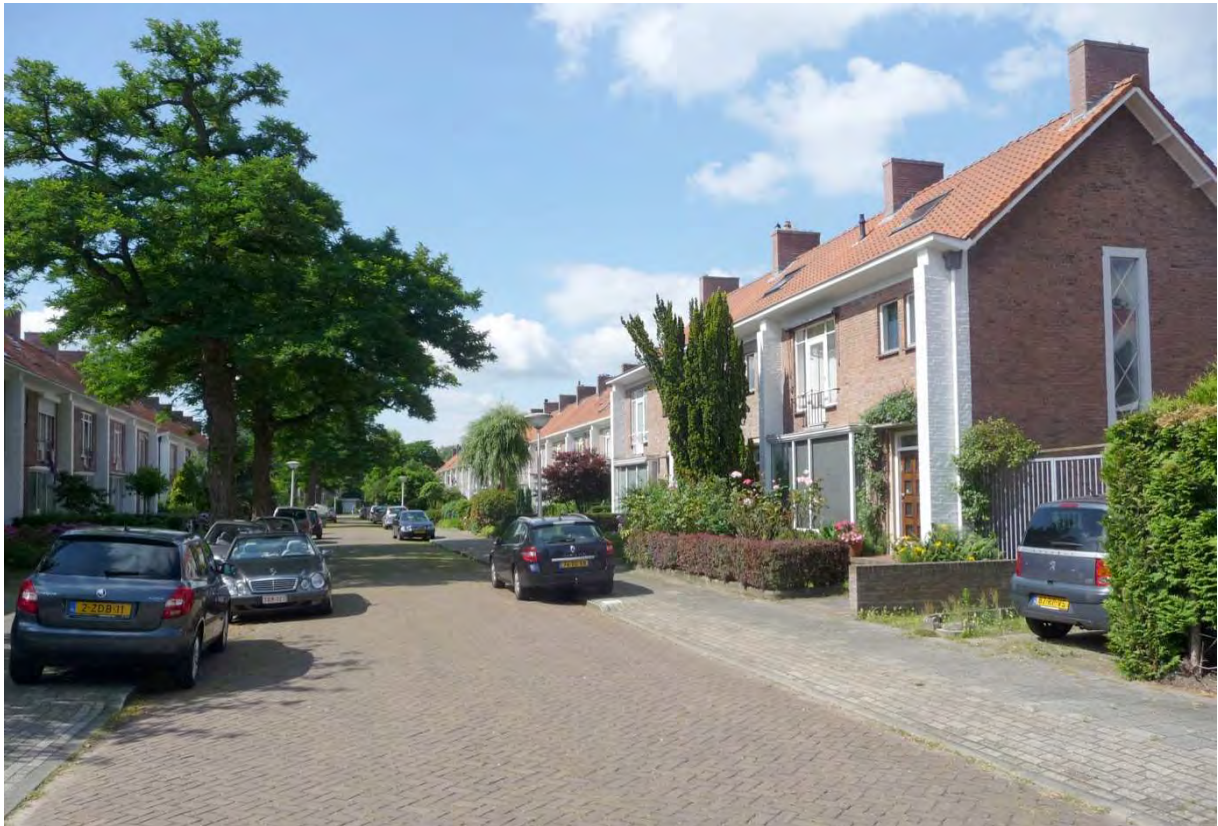
Complexonderdeel 2: zicht over de Rapelenburglaan.
