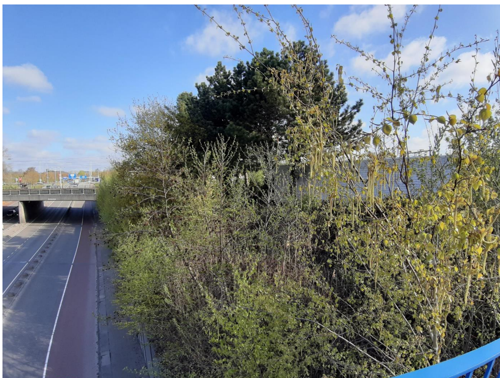
Foto 3: Opslag met o.a. boswilg op talud Insulindelaan.
