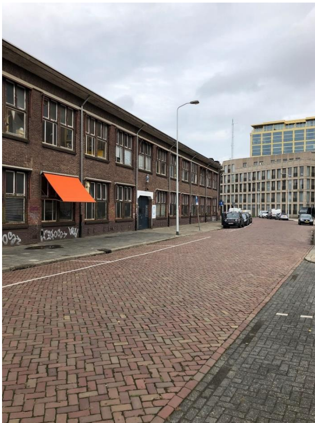
Afbeelding 14: huidige situatie Gagelstraat in het werkgebied Emmasingelkwadrant.
