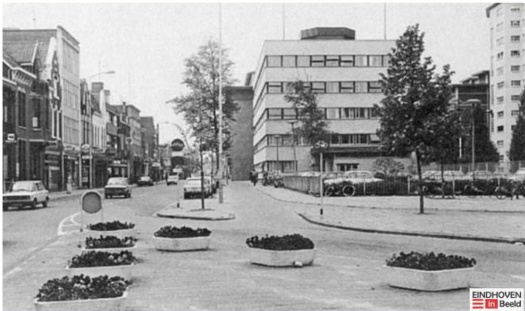
Afbeelding 43: situatie 1977 Het gedeelte van de Willemstraat tussen Emmasingel en Vonderweg werd omgebouwd. Het werk werd in 2 fasen uitgevoerd : het vervangen van het riool, aanleg van een asfaltrijbaan met aan één zijde een fietsstrook. Aan de andere zijde is over een groot gedeelte een vrijliggend fietspad aangelegd. (bron: www.eindhoveninbeeld.nl , fotonr. 30808, bijdrager Ton Brouwer)
