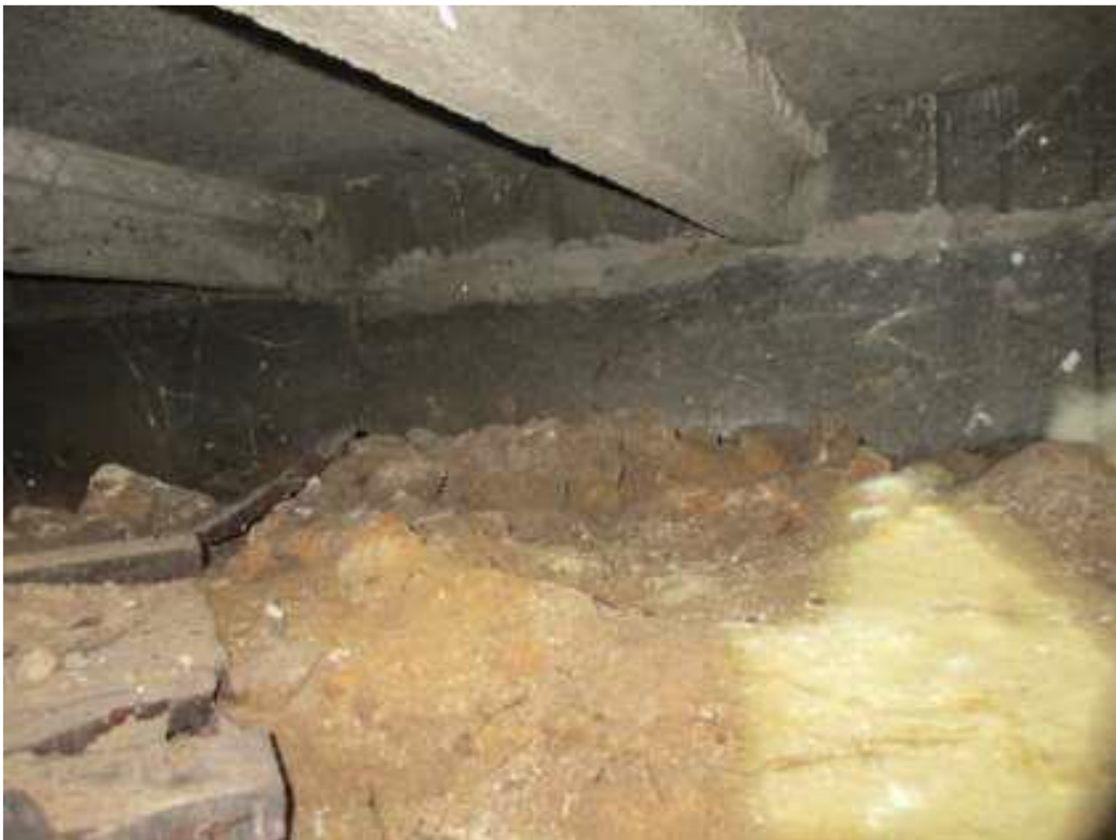
Foto van de kruipruimte met zicht op de opbouw van de begane grond vloer. Deze bestaat uit T-vormige betonnen balken waarop U-vormige platen liggen. Dit is gelijk aan de tekening uit 1946.
