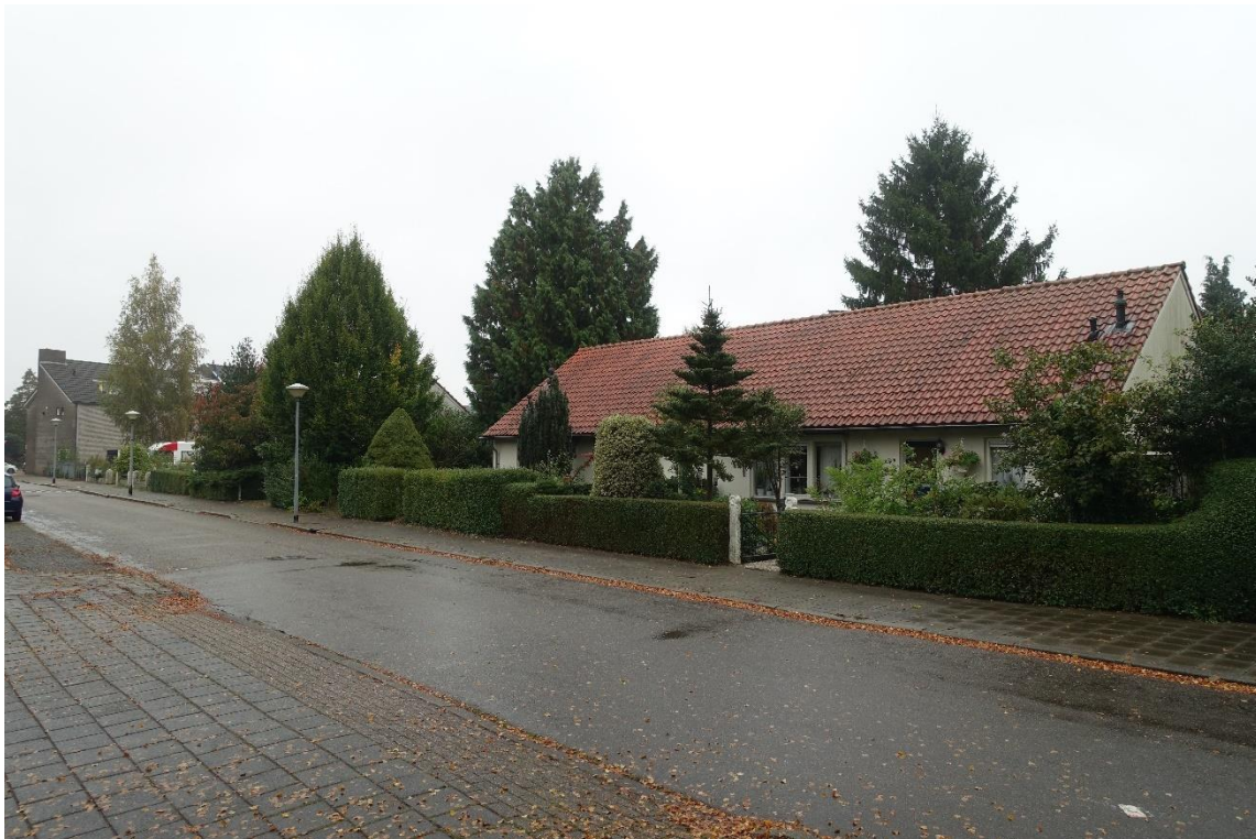
Het eerste blokje woningen aan de Veldmaarschalk Smutsstraat. Op de achtergrond de bebouwing aan de Tongelresestraat, het contrast met het vele groen om de bungalows is direct zichtbaar. De rechter woning heeft nog een oorspronkelijk hek, ook de groene afscheidingen naast de hekjes zijn oorspronkelijk.
