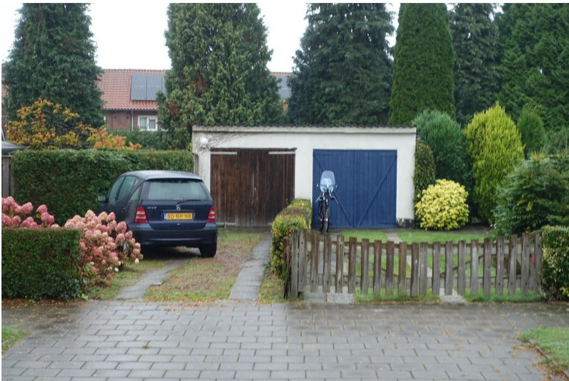
De schuren tussen nummer 36 en 38. Deze liggen nog geheel vrij en laten de oorspronkelijke opzet zien. De dubbele deuren zijn waarschijnlijk later ingebroken, toen het autobezit toenam. Een aantal schuren heeft nog alleen een loopdeur.
