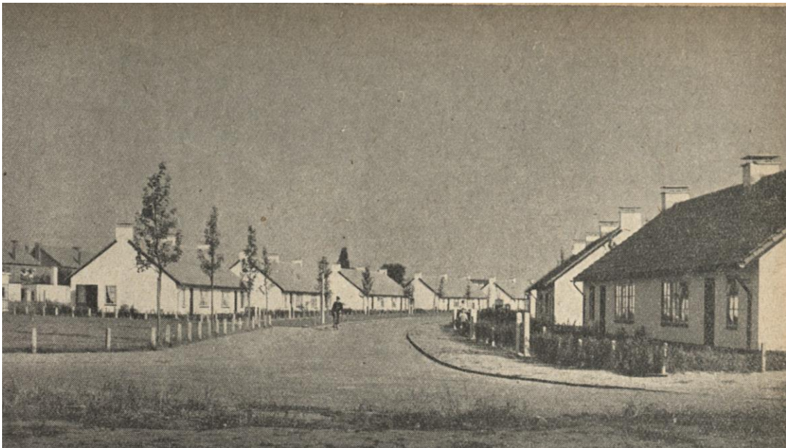
Foto van de Rustenburgstraat in het weekblad voor het Bouwwezen van 4 oktober 1947. In de gevel zijn de stalen vensters zichtbaar. De schoorstenen betreffende de keuken en de woonkamer.
