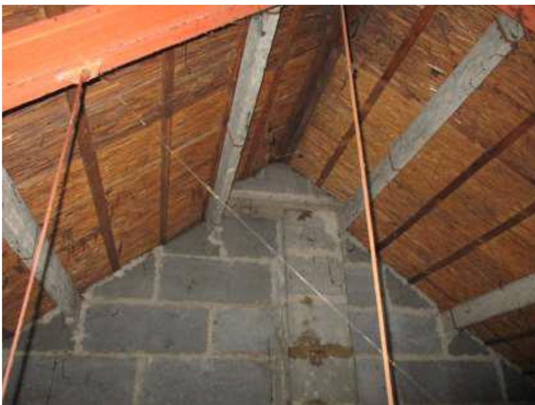
Foto van de binnenzijde van de kap met goed zichtbaar de betonblokken en de afgeknotte schoorsteen. Net zichtbaar een stuk van het stalen spant met hangers voor het plafond. Op de betonnen gordingen de rieten matten met daarop de tengels voor de panlatten.
