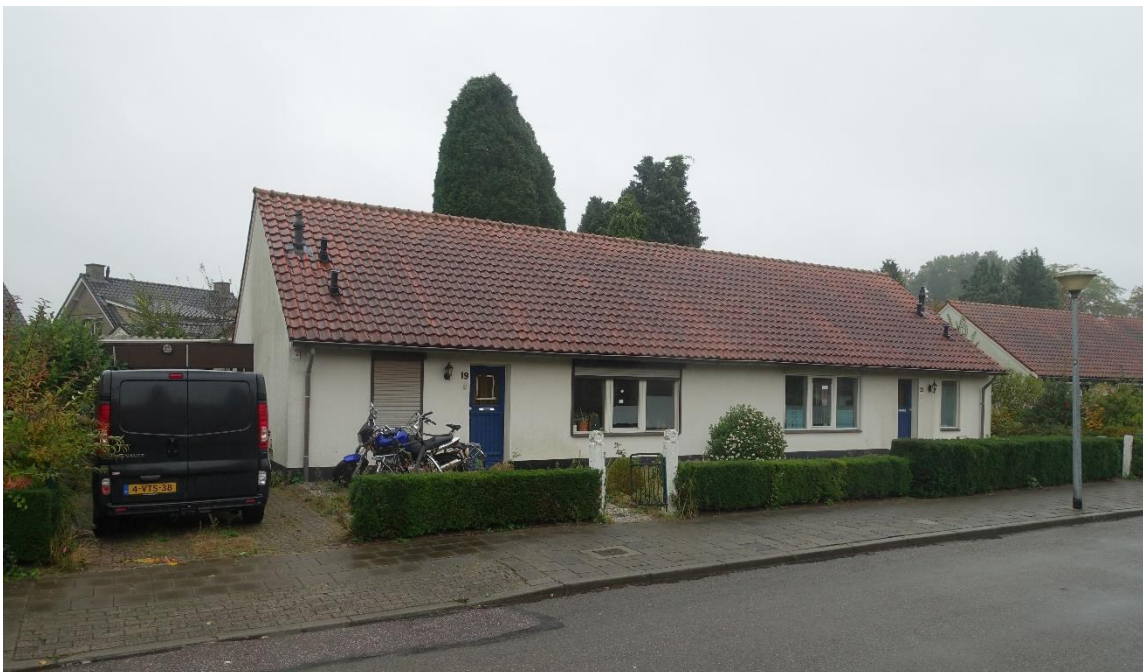
Nummer 19 en 21 aan de noordoostelijke zijde van de Rustenburgstraat. De opzet van de twee geschakelde bungalows is hier door het relatief beperkte groen goed zichtbaar. Nummer 19 heeft nog het oorspronkelijke hekje met betonnen palen. Per blokje zijn de voordeuren blauw en bruin geschilderd.
