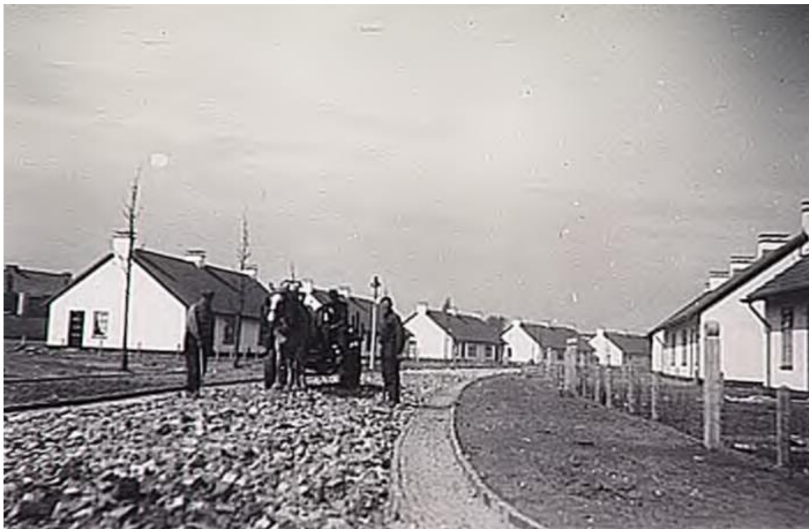
RHCE Beeldbank 19736. Foto van de net opleverde woningen aan de Rustenburgstraat. Het wegdek van de straat bestaat uit grof gebroken puin. De betonnen hekpalen zijn bij een aantal woningen nog aanwezig.
