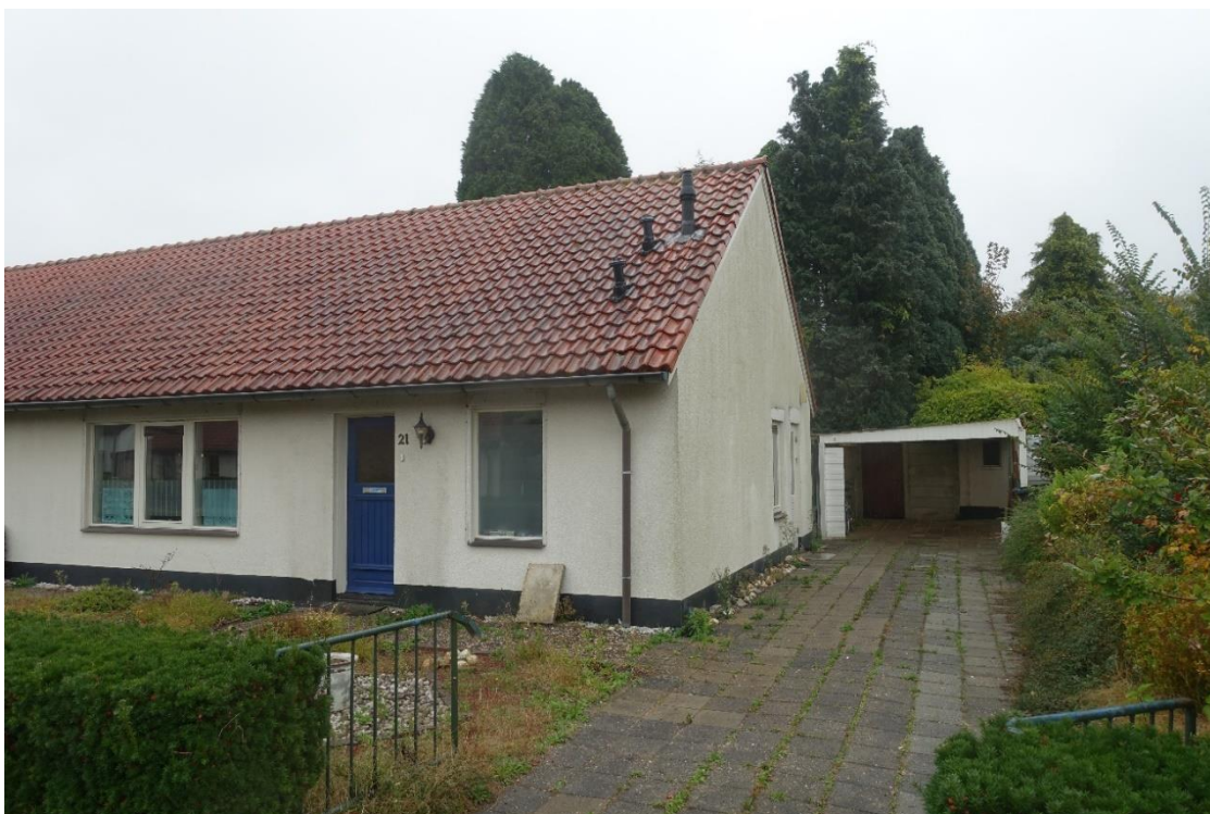
Nummer 21 met zicht op de zijgevel. Door de aan de buitenzijde aangebrachte isolatie is het overstek van de kap vrijwel geheel weggevallen. Ook het verwijderen van de schoorstenen heeft de architectuur aangetast.
