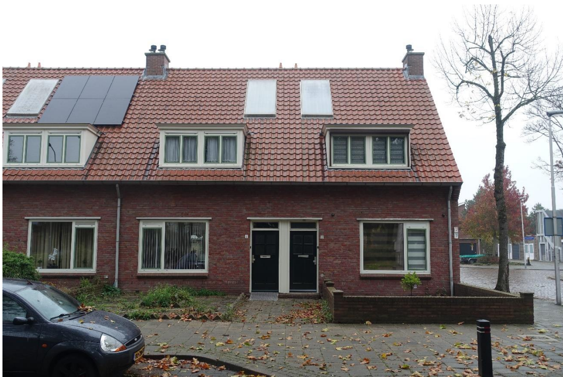
De woningen in Lievendaal met op het dak de aangebrachte zonneboilers. De dakkapellen zijn gelijk aan die in Tivoli, net als de entrees. De indeling van de vensters verschilt, maar dit kan ook een latere wijziging zijn.
