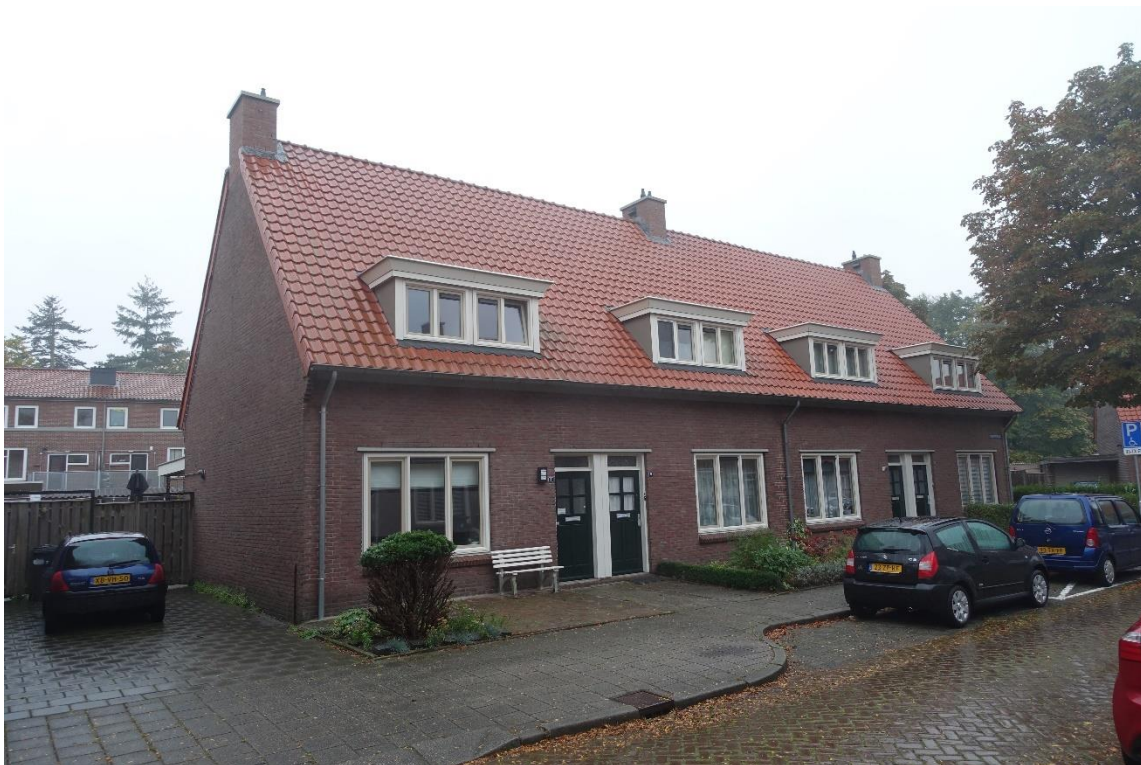
Eén van de kleine blokjes in Tivoli. Elke woning heeft een brede dakkapel. De entrees liggen twee-aan-twee met ernaast een drielicht. Dit geeft gelijk aan hoe de begane grond is ingedeeld.
