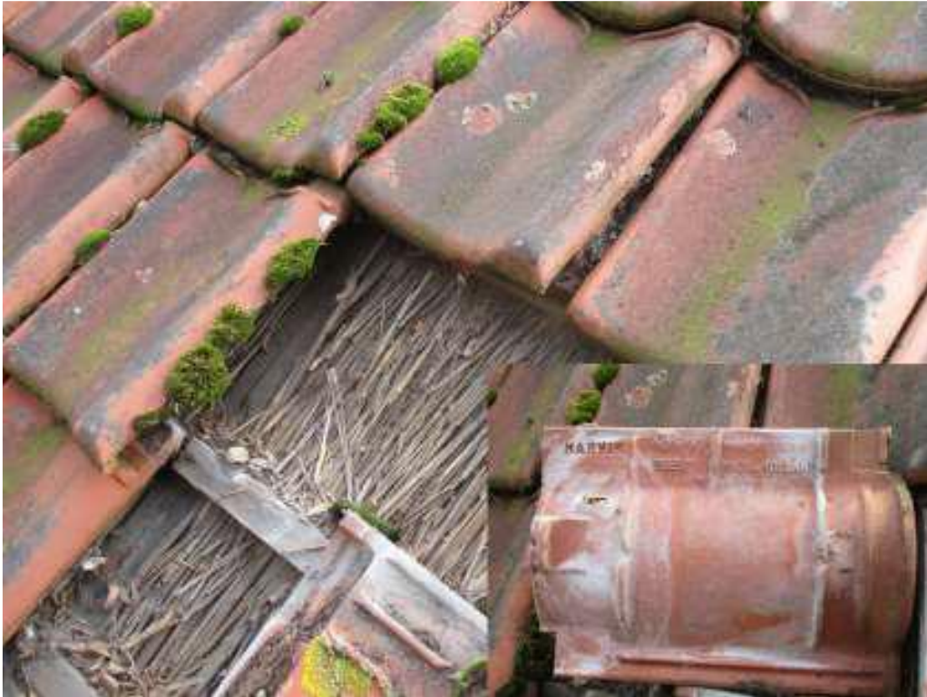
De Verbeterde Holle pannen op het dak met eronder de afwerking van riet. Gezien het strakke stempel op de achterzijde van de pan zijn deze waarschijnlijk inderdaad in 1981 aangebracht. De pannen worden sinds 1920 geproduceerd zodat het eveneens zou kunnen zijn dat dit de oorspronkelijke pan was.
