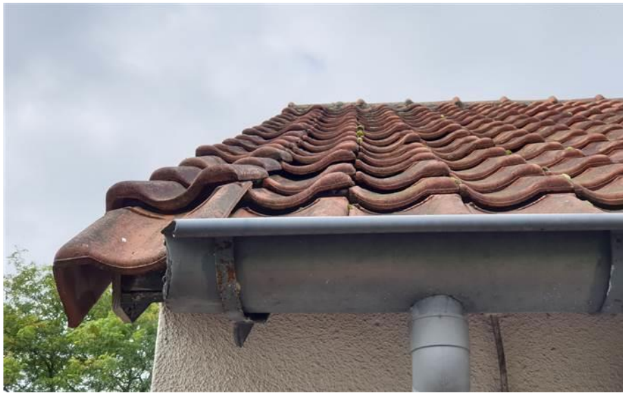
Afbeelding 2: overhangende dakpannen en kieren tussen dakpannen geschikt voor betreding door gierzwaluw en huismus
