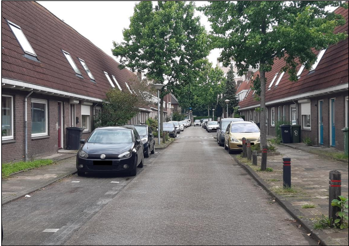
Afbeelding 22: Foto met zicht op de Wassenaarstraat.
