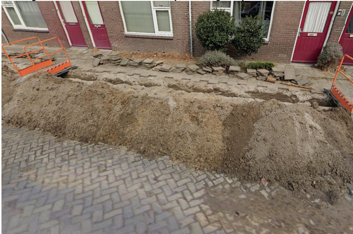
Foto 1: graafwerkzaamheden Bakkerstraat (bron: Google Maps – Street View)
