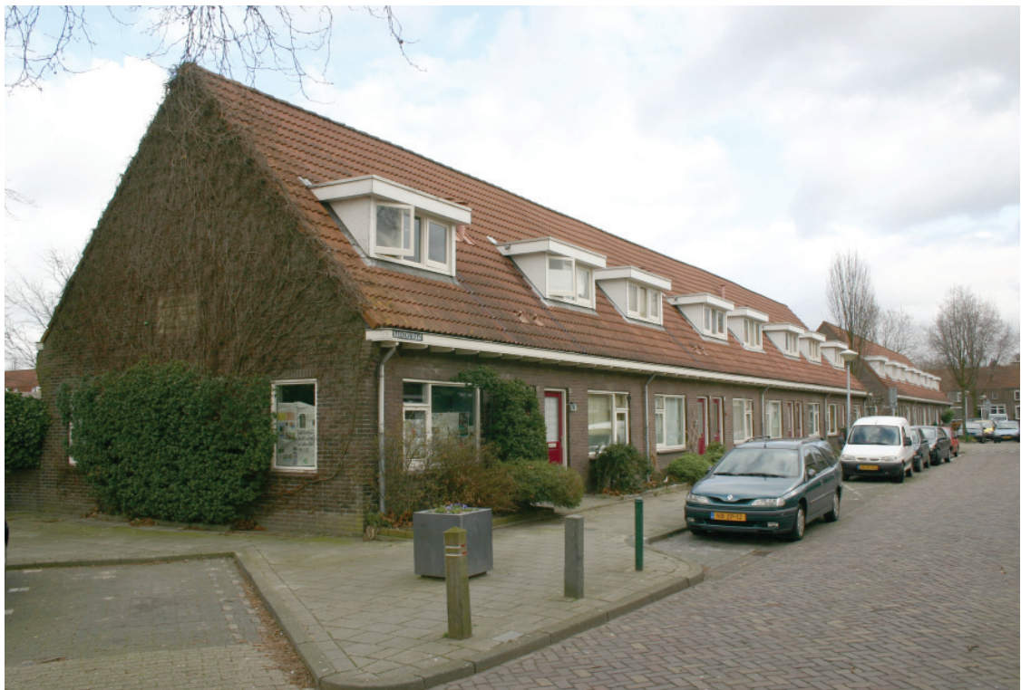
Afb. 16. Een opname van de Bakkerstraat in de richting 32 t/m 2 die een hoog opgaand zadeldak hebben.
