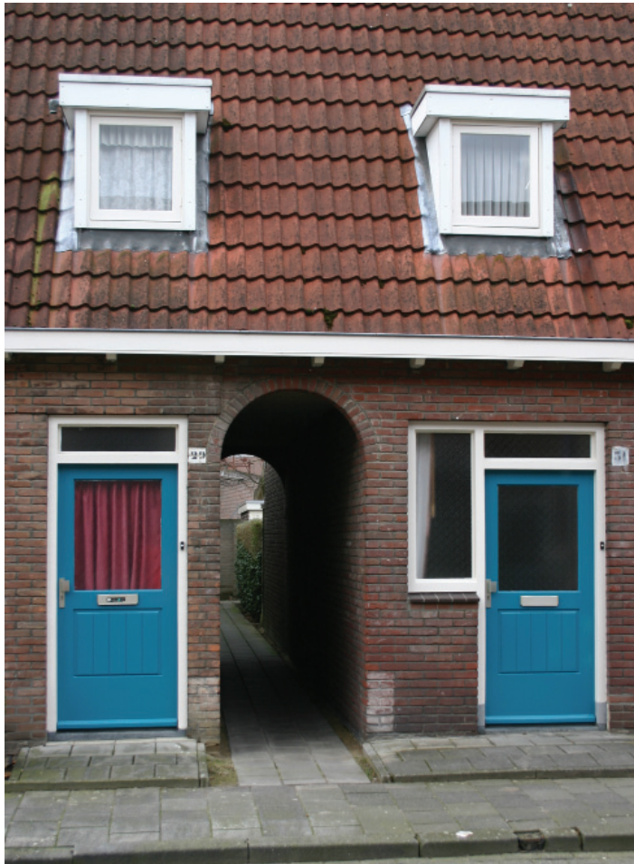
Afb. 9 . Eén van de poortjes die zich in de gevelwand van de Wassenaarstraat bevinden.
