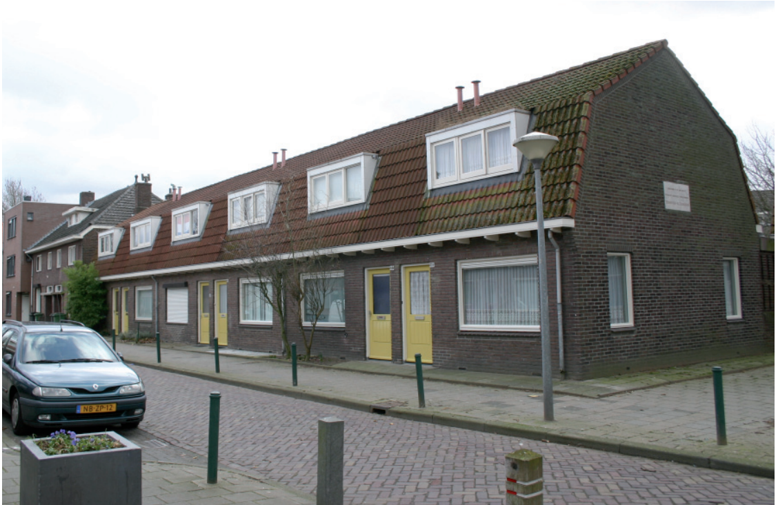
Afb. 17. De later gebouwde panden (op de foto de Bakkerstraat in de richting 31 t/m 21) zijn met een Mansardedak uitgevoerd.
