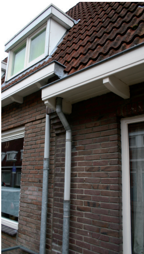
Afb. 19. Een detail opname van panden aan de Wassenaarstraat. Duidelijk zichtbaar is het halfsteens metselverband, de verspringende goothoogtes en, links op de foto, de geprofileerde gootklossen.
