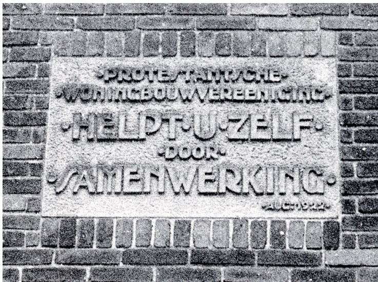
Afb. 7. Gevelsteen, aangebracht in de gevel van de hoekwoning Bakkerstraat - Wassenaarstraat.
