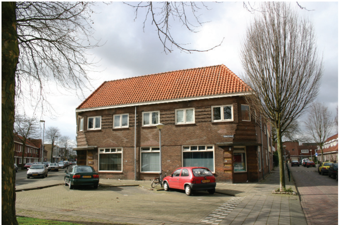
Afb. 24. De winkelwoningen op de hoek Verwerstraat / Bakkerstraat.
