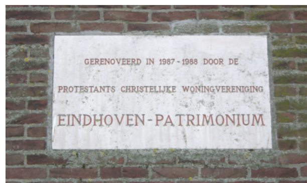
Afb. 21. De gevelsteen welke werd aangebracht na voltooiing van de renovatie.
