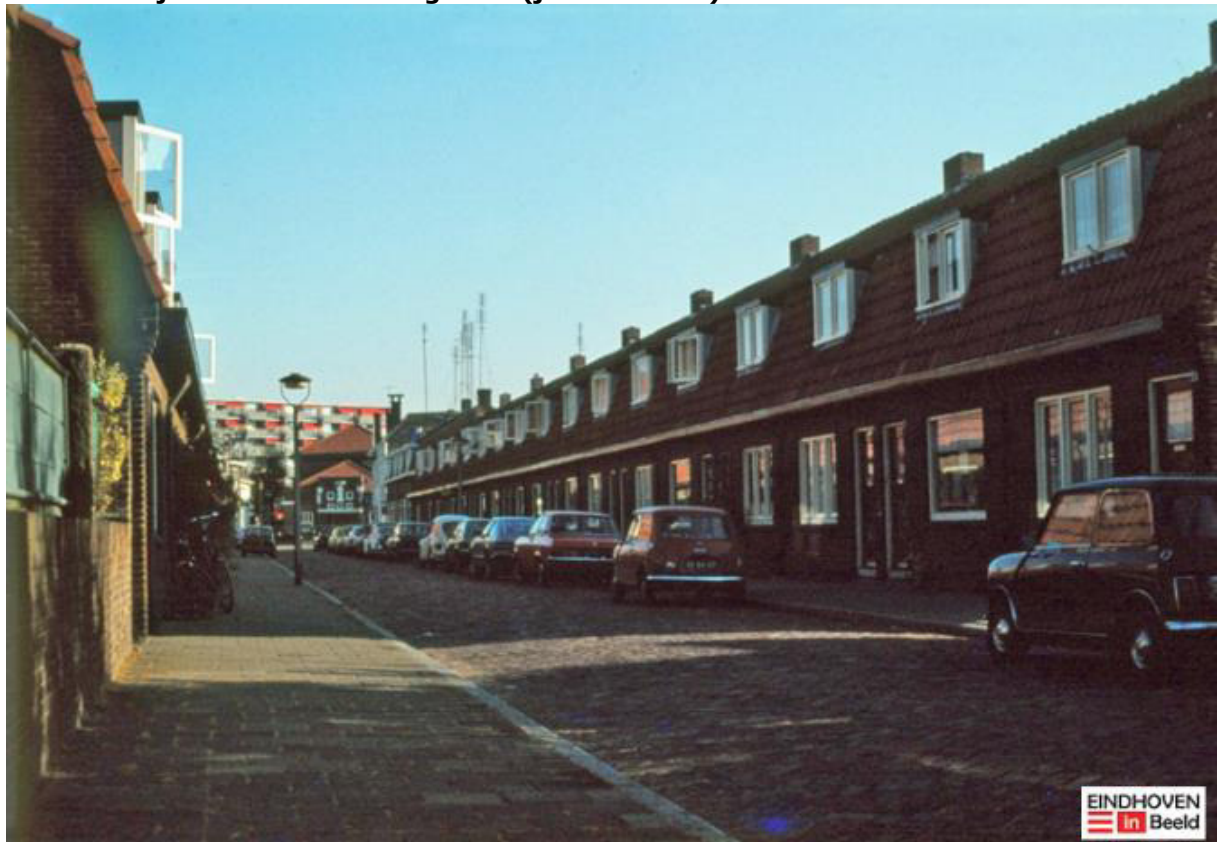
Afbeelding 5: De Slagerstraat vóór de renovatie van deze woningen met de oude dakpannen, de raamkozijnen met twee tussenstijlen en de oude bestrating – vermoedelijk vanaf het zuiden gezien (jaartal: 1984)
