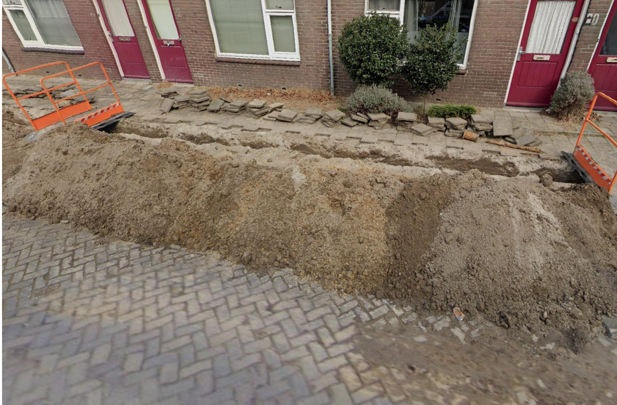
Foto 1: graafwerkzaamheden Bakkerstraat (bron: Google Maps – Street View)
