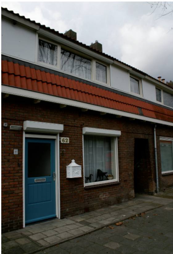
Afb. 18. Eén van de huizen in de gevelwand aan de Verwerstraat waarbij de dakkapellen over de gehele breedte doorlopen.
