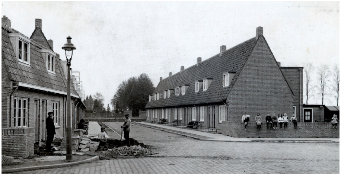
Afb. 6. De eerste voltooide arbeiderswoningen van de woningbouwvereniging "Help U zelf door samenwerking"
