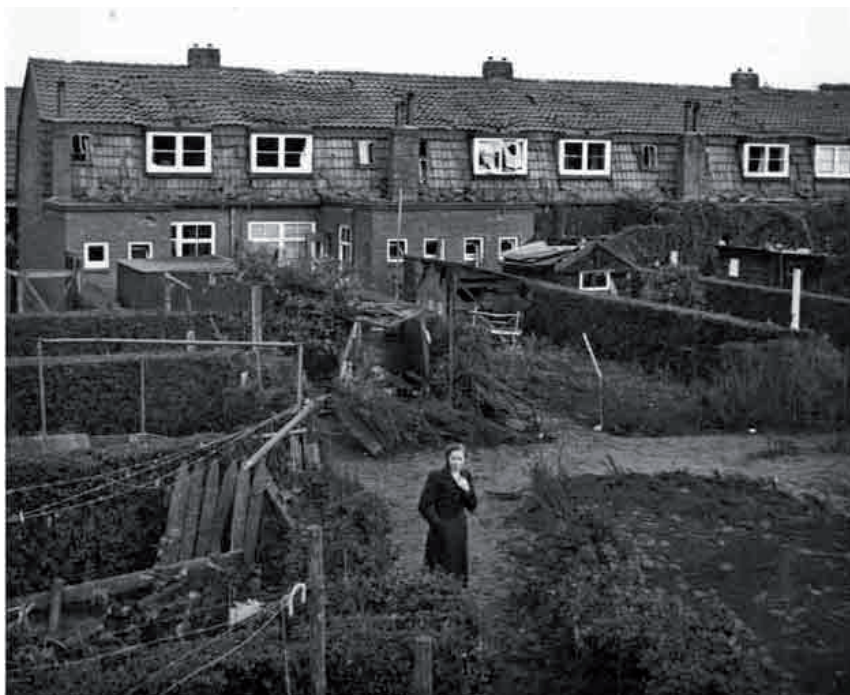
Afb. 15. Opname van aanzienlijke schade aan de Slagerstraat, genomen op de dag na het bombardement.
