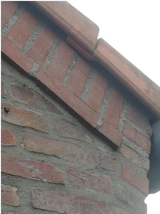
Figuur 4.4.1. Onder de overstekende gevelpannen is voldoende ruimte voor huismussen, gierzwaluwen en vleermuizen.
