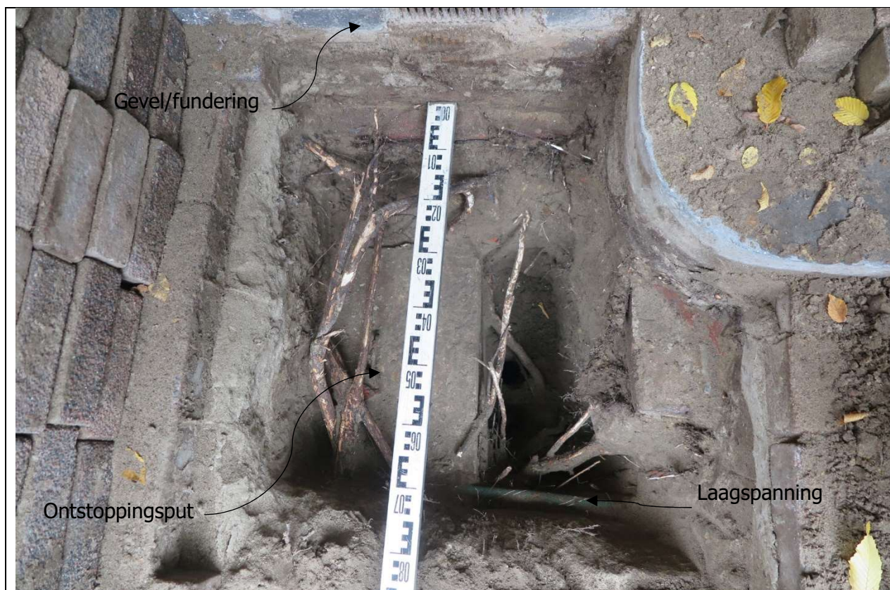
Beeld van de profielkuil met op ca. 70 cm uit de gevel laagspanning
