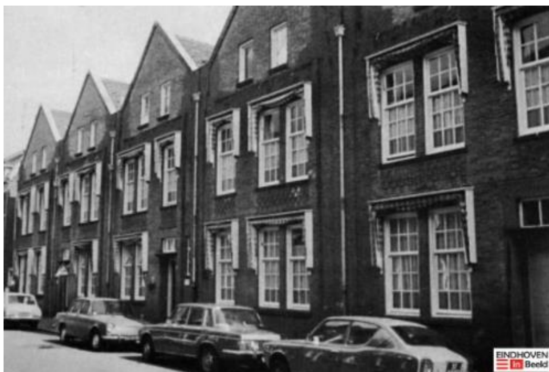
Foto uit 1974 die een goed beeld geeft van de architectuur van de voorgevel ( www.eindhoveninbeeld.com 51436). De markiezen zijn niet oorspronkelijk, de roedeverdeling van de ramen wel. De topgevels zijn vrij recent vernieuwd.
