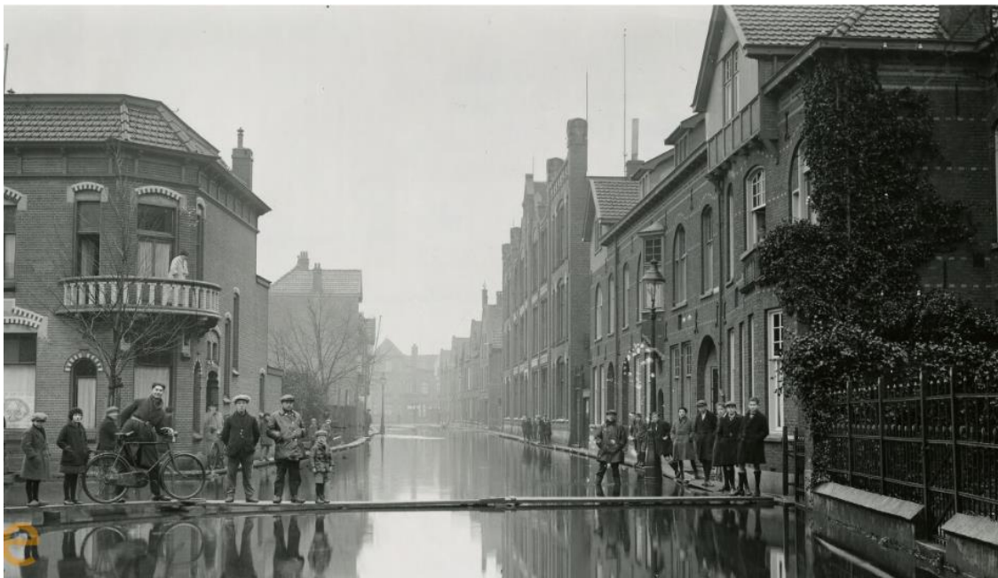
Foto van de met regelmaat terugkerende wateroverlast aan het Wilhelminaplein en de Sint Catherinastraat (RHCE beeldbank 20205).
