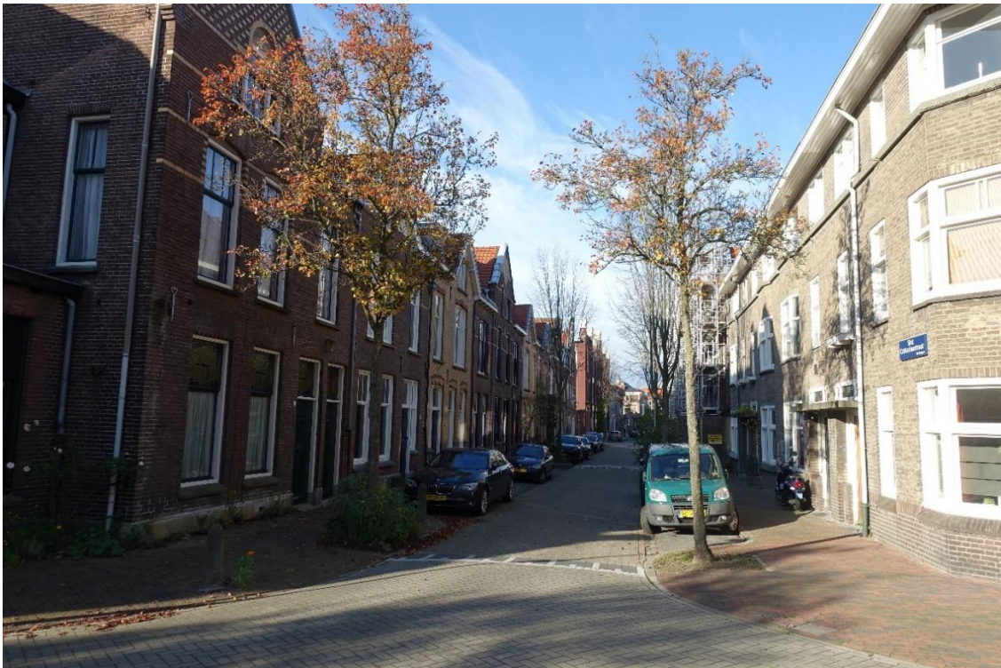
De oostelijke zijde van de Sint Catharinastraat voor de eerste bocht met rechts het blok van vier jaren '30 woningen met kenmerkende overkragende bakgoten. Daarachter de steigers voor nummer 13. Links de even genummerde zijde die hier bestaat uit tweebeukige voorgevels met Vlaamse gevels van verschillende breedte.
