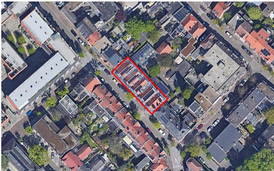
De Sint Catharinastraat op Google maps. Rood omlijnd nummer 13. Achter het pand de latere aanb- en uitbouwen waarbij er tegelijk nog een open binnenterrein met begroeiing aanwezig is.
