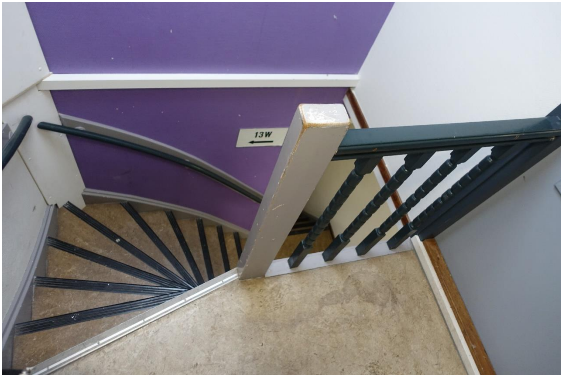
Op de overloop van de kapverdieping is in het tweede trappenhuis de oorspronkelijke balustrade aanwezig. De verdere trap is vernieuwd.
