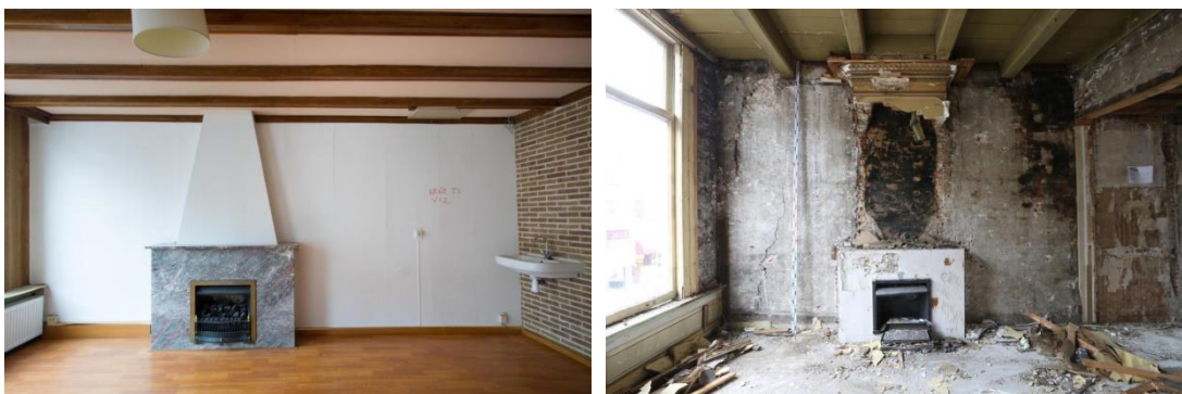
Vaak blijft bij een verkenning veel aan het oog van de bouwhistoricus verborgen. Links de situatie vóór ontmanteling, rechts na, met een achttiende-eeuwse balklaag, een negentiende-eeuwse schouw en een voormalige buitengevel (zestiende-eeuws) met daarin dichtgezette vensteropeningen. Voorbeeld: Breestraat 68 in Leiden.
