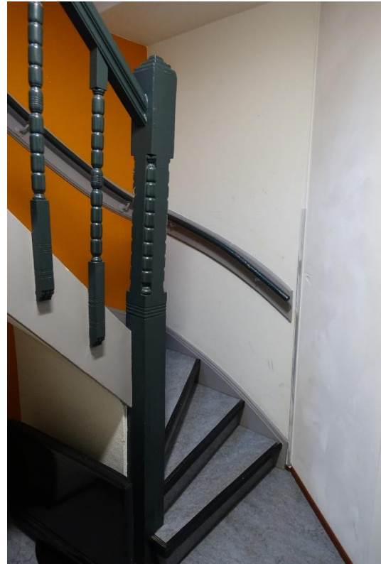
Van het derde trappenhuis is alleen op de verdieping oorspronkelijk materiaal aanwezig. Dit is op gelijke wijze vormgegeven als bij de andere trappenhuisen. Achter de beplating met gips is de oorspronkelijke aftimmering van het trapgat aanwezig.
