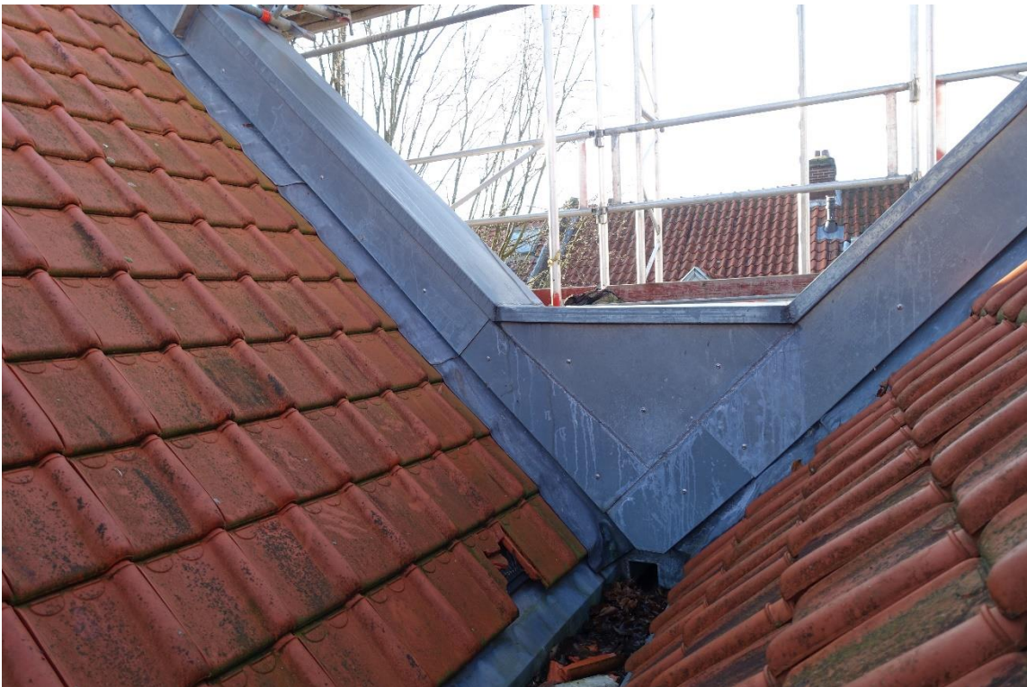
De zakgoot gezien naar de voorgevel. Pannen en zinkwerk zijn in 2010 vernieuwd.
