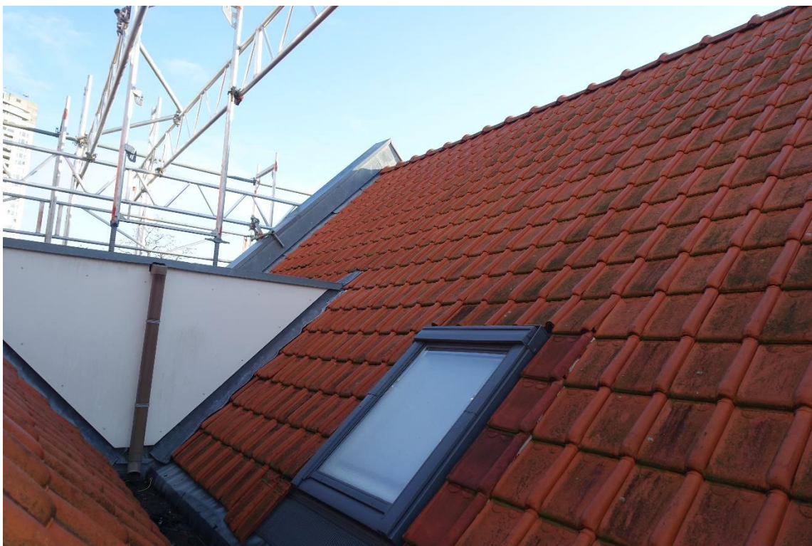
De zakgoot gezien naar de achtergevel. Op meerdere plaatsen zijn er verbindingen tussen de kapverdiepingen aangebracht. De kapvorm is oorspronkelijk.
