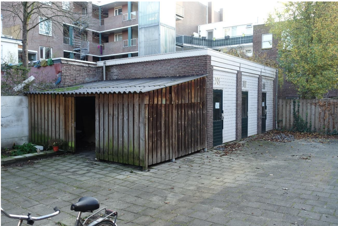
De garage uit 1931. De ruimte is inwendig verder niet ingericht. Metselwerk en plat dak zijn oorspronkelijk.
