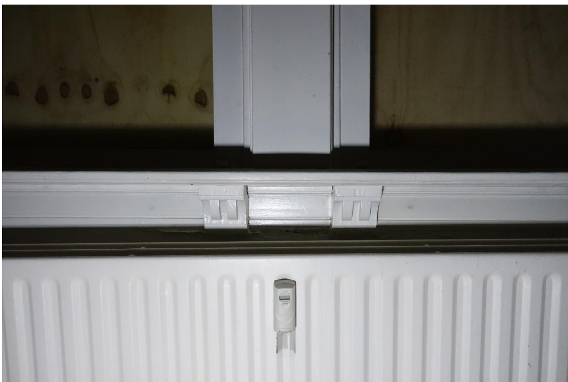
De consoles onder de vensterbank. De vormgeving is niet stijl gebonden. De consoles komen bij meerdere vensters voor en lijken overal aanwezig te zijn geweest.
