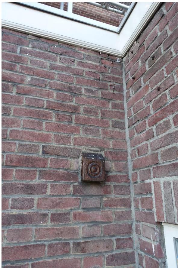
Keramische kap van een ventilatiekanaal in de achtergevel. Er zijn verder geen gelijksoortige elementen aangetroffen. Het element bevindt zich in de oorspronkelijke achtergevel, maar is wellicht later toegevoegd.
