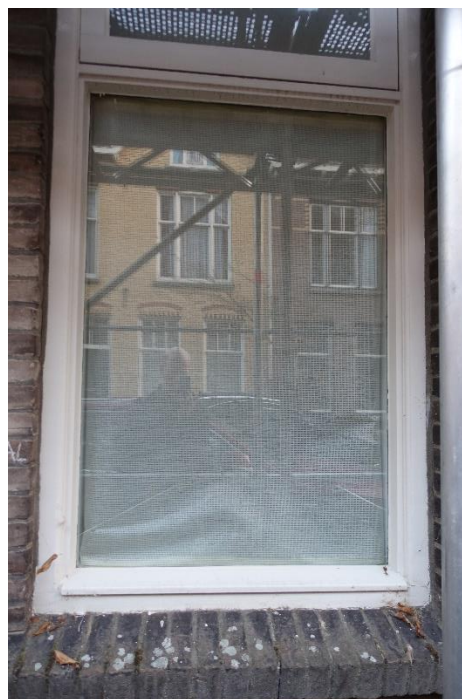
Links de voordeur aan de linkerzijde, het geheel is oorspronkelijk. Rechts één van de vensters. De kozijnen zijn oorspronkelijk. Het glas en de bovenlichten zijn nieuw.
