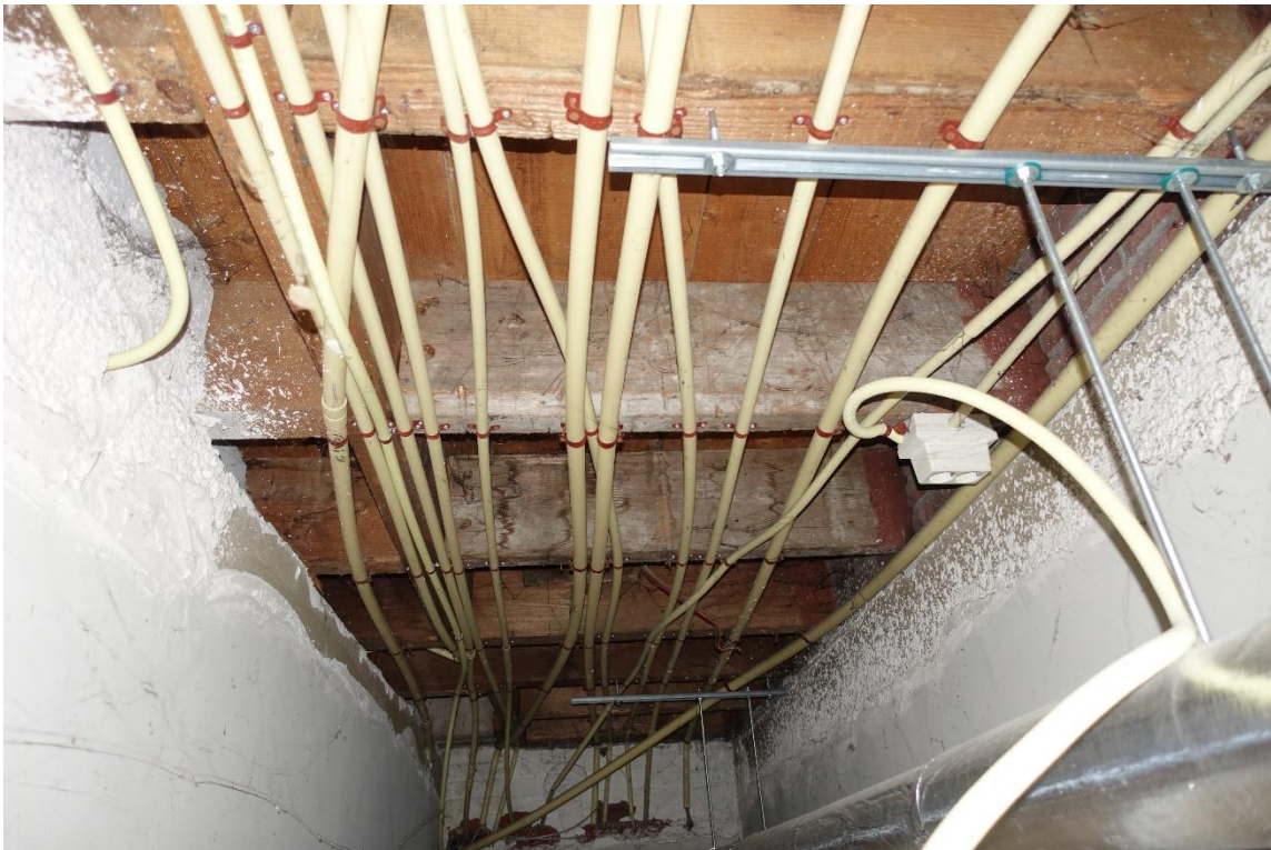
De balklaag boven het verlaagde plafond van de gang die door het losse bouwdeel loopt. In de balklaag ligt een raveelbalk die aangeeft dat er hier een trap stond. Dit zal de oorspronkelijke indeling van het bouwdeel zijn geweest, voordat het via de gang direct met de andere bouwdelen werd verbonden.
