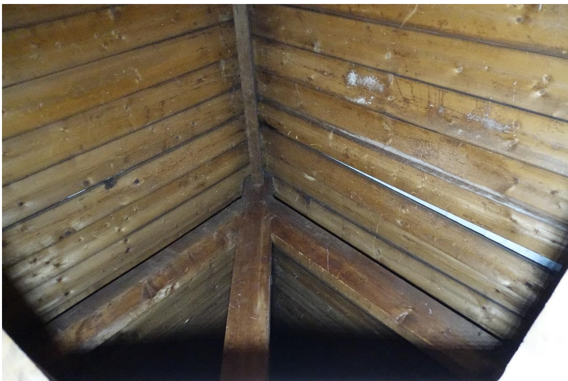
Boven de trekbalken ligt een verder niet afgewerkte vliering die zicht geeft op de top van het spant met de spantbenen die in de makelaar zijn ingelaten. Ook het staande beschoot is duidelijk zichtbaar.
