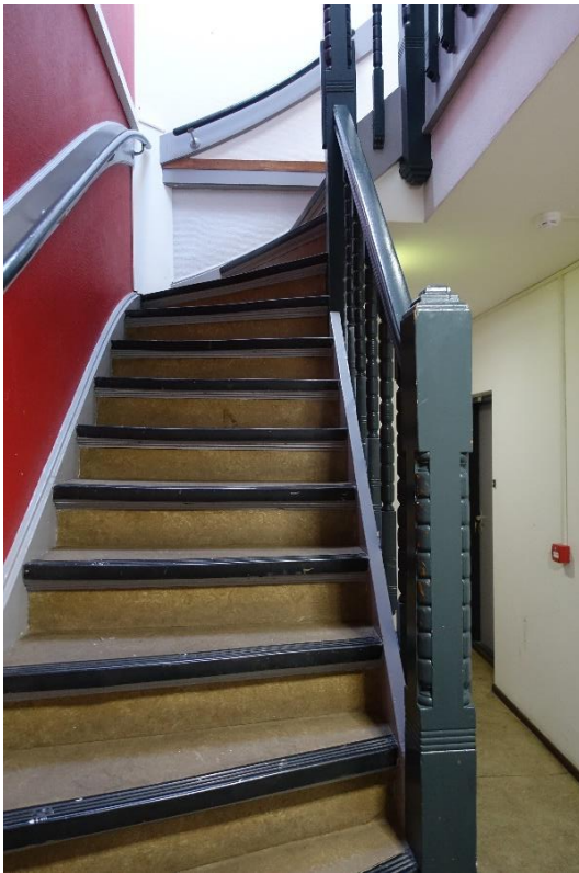
De trap naar de kapverdieping, er zijn hier twee kwarten. De beschadigingen aan de trappaal lijken een afwerking met blanke lak te laten zien.
