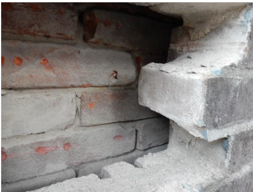
Eén van de gemaakte openingen in de voorgevel die de spouw met het binnenblad laat zien (afbeelding HERE Bouwadvies en Vianen Bouwadvies).
