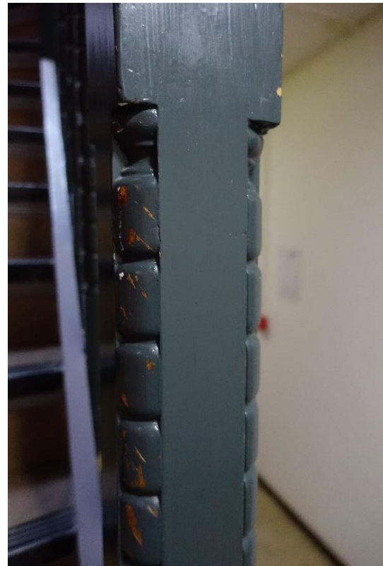
De trap naar de kapverdieping, er zijn hier twee kwarten. De beschadigingen aan de trappaal lijken een afwerking met blanke lak te laten zien.
