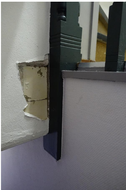
Van het derde trappenhuis is alleen op de verdieping oorspronkelijk materiaal aanwezig. Dit is op gelijke wijze vormgegeven als bij de andere trappenhuisen. Achter de beplating met gips is de oorspronkelijke aftimmering van het trapgat aanwezig.
