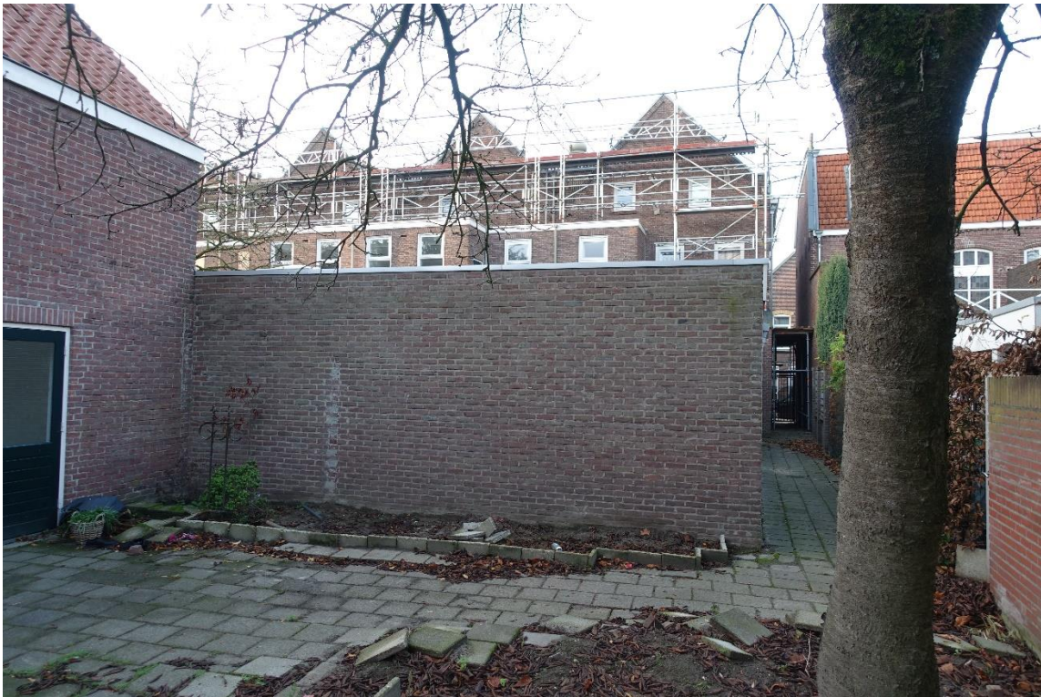
De achterzijde van de uitbouw uit 1964 met rechts de steeg naar de straat. Links het losse bouwdeel.
