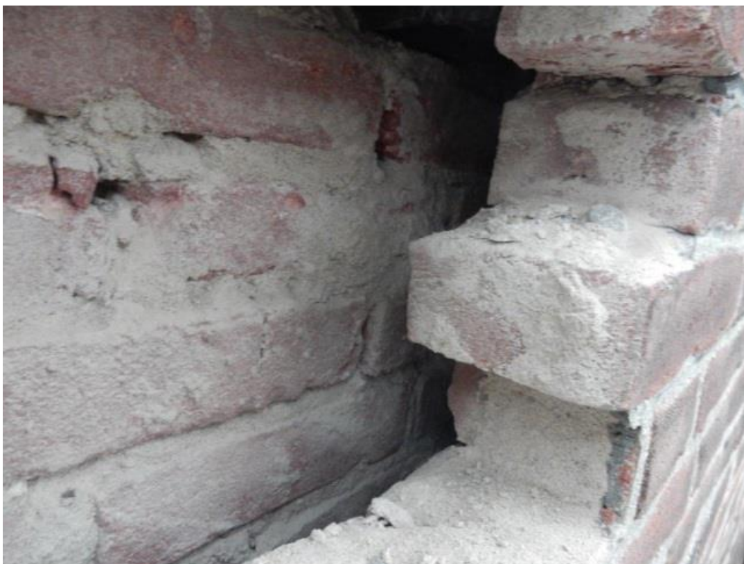
De opening in de achtergevel laat eenzelfde opbouw van het metselwerk zien (afbeelding HERE Bouwadvies en Vianen Bouwadvies).
