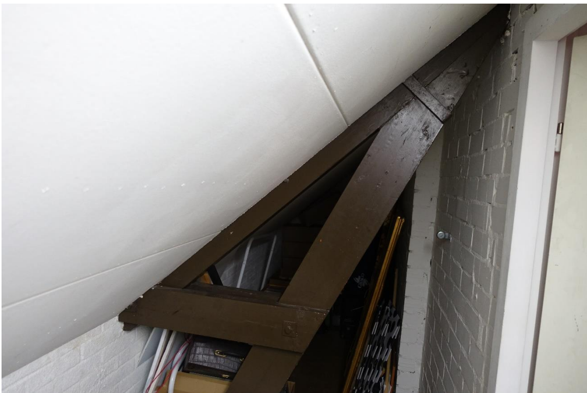
Het spantbeen van het losse bouwdeel boven de huidige gang. De verdere inrichting dateert van rond 2000 of later.
