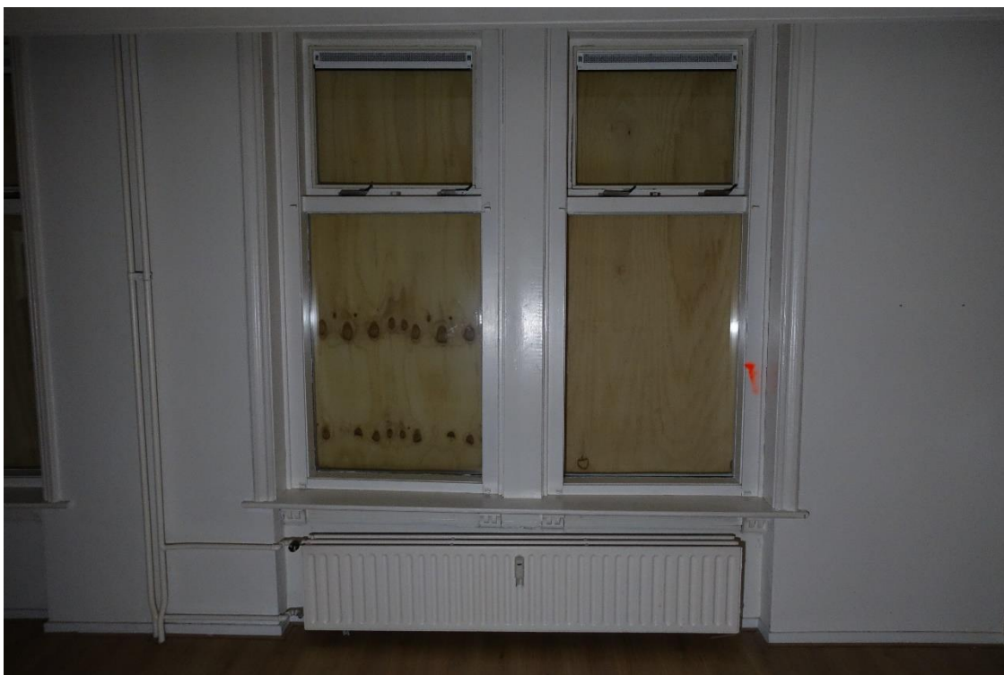
De twee vensters in de brede travee van het linker appartement op de verdieping. Onder de vensterbank de oorspronkelijke consoles. De vaste ruiten zijn met latten op het bestaande kozijn geklampt. Er lijken oorspronkelijk schuiframen aanwezig te zijn geweest.
