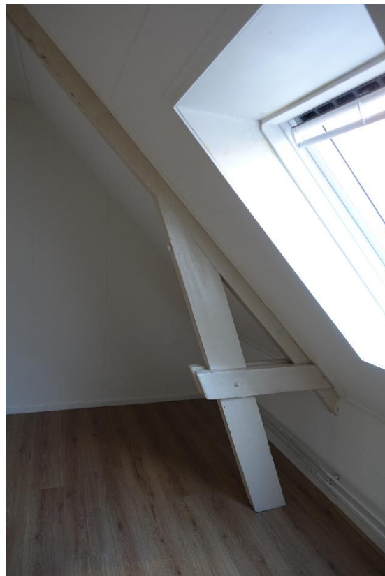
Links de kreupele stijl met blokkeels bij de muurplaat in de tweede kap. Rechts dezelfde constructie in de vijfde kap.
