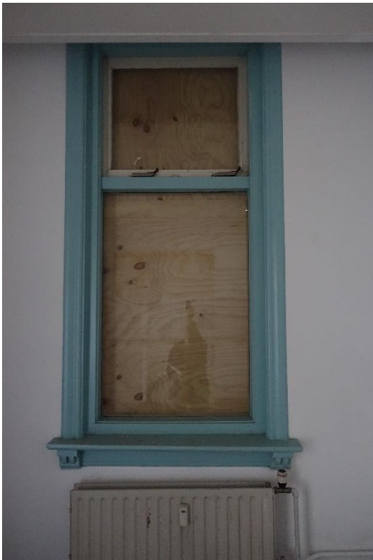
Tweemaal een venster in de smalle beuk. Links op de verdieping, rechts op de begane grond. De consoles zijn gelijk aan die in de dubbele beuk. De ruiten en bovenramen zijn op gelijke wijze aangepast.
