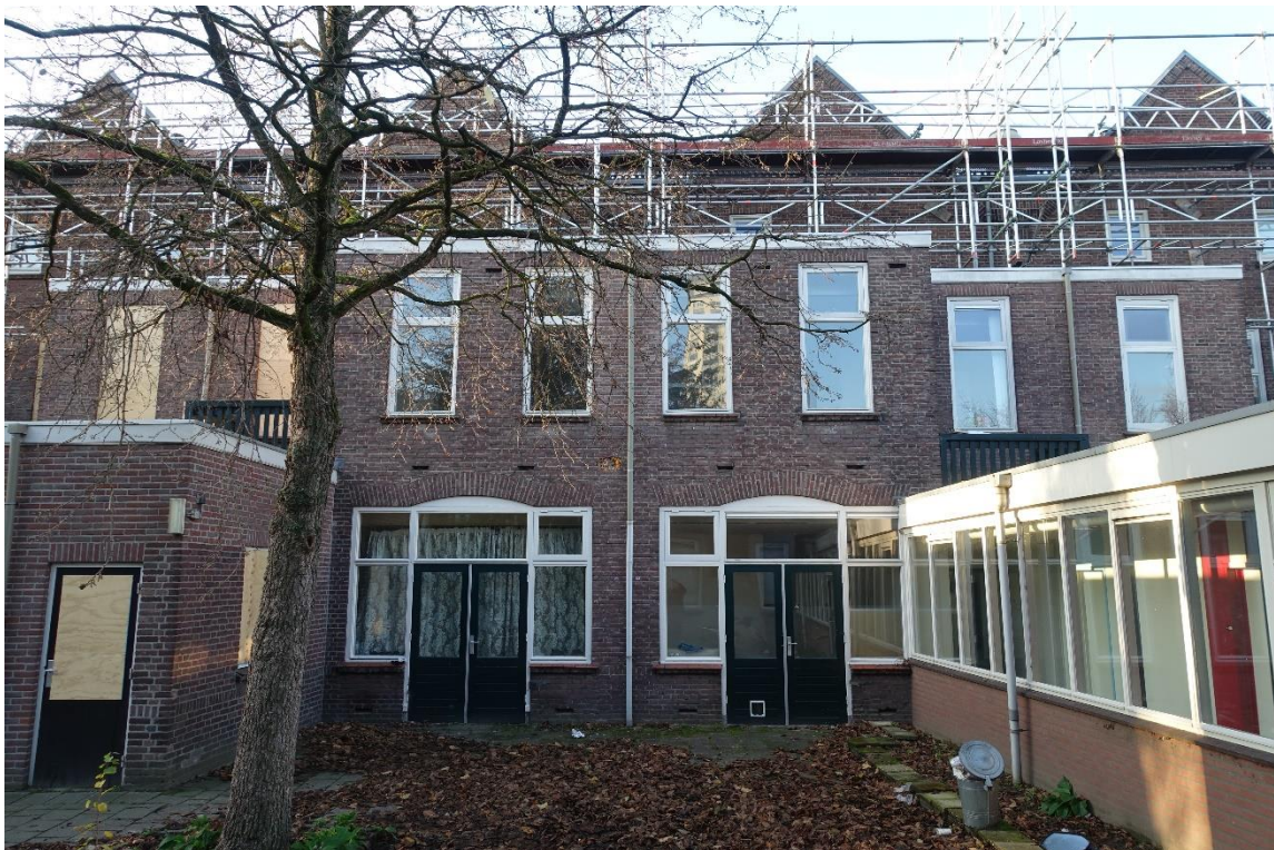
Het midden van de achtergevel met de tweelaags uitbouw. Rechts de uitbouw uit 1964. De gevel is opnieuw opgetrokken, de indeling is oorspronkelijk.
