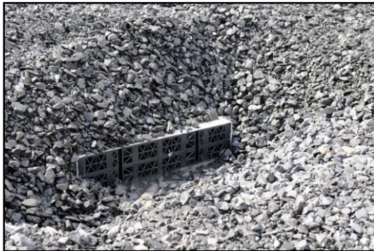
Permavoid aansluitstuk 70x35x15cm met mof \varnothing 110mm
