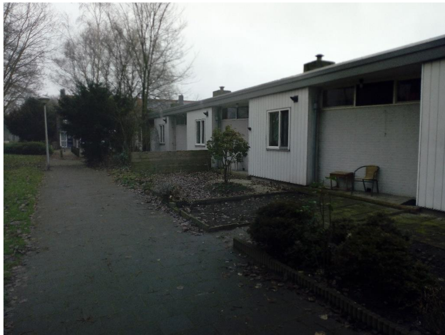
Voorgevel van plangebied. Voor- en achtergevel bestaan uit zelfde opbouw (gevelbeplating).
