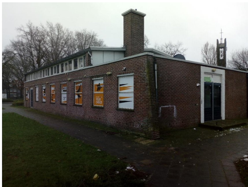
Foto van voorgevel, ingang, van het jongerencentrum. Bij schoorsteen zijn meerdere openingen geschikt voor vleermuizen en algemene broedvogels aanwezig.
