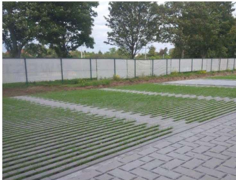
Parkeerplaatsen aan de rand van het park bestraten met waterdoorlatende bestrating - hydro lineo Struyk Verwo
