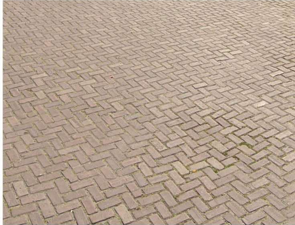
Voor de rijbanen van de parkeerplaats worden de bestaande gebakken klinkers uit de Mascagnistraat hergebruikt, aangevuld met nieuwe stenen.
