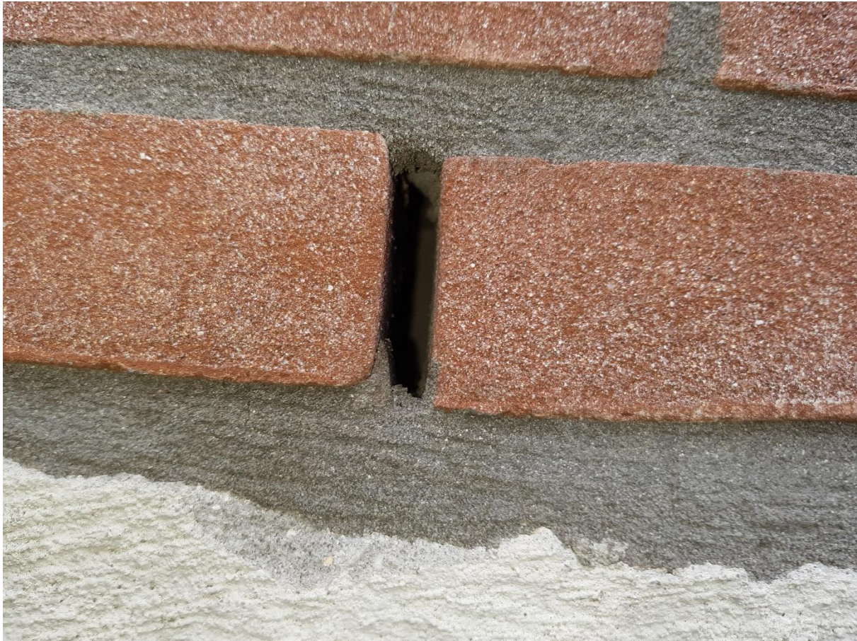
Figuur 2: Een van de openstootvoegen binnen het onderzoeksgebied. De meeste openstootvoegen in het plangebied zijn vrij van obstakels en breed genoeg voor vleermuizen om doorheen te kruipen.
