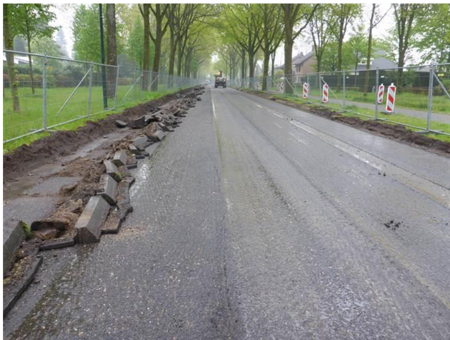
Afbeelding 9: voorbeeld van fysieke afscheiding van de onverharde delen van de groeiplaats, door de toepassing van bouwhekken
