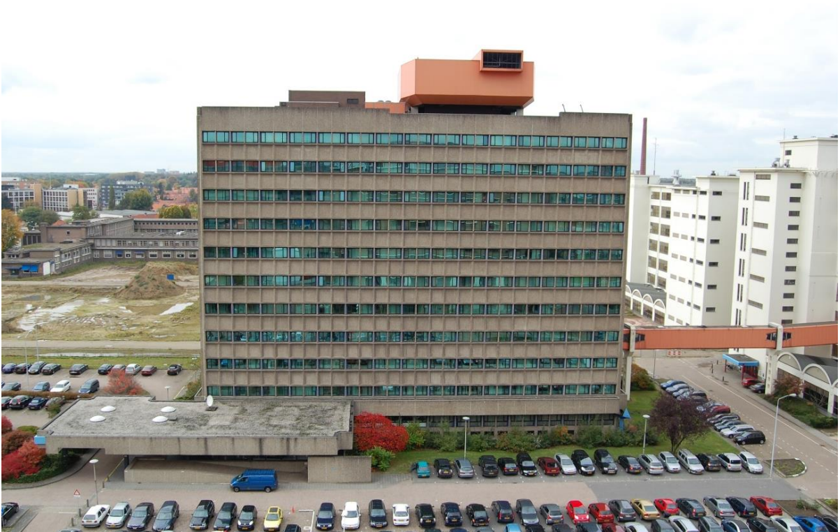
Overzicht van gebouw SFF, gezien vanaf het glasgebouw (foto april 2008).
