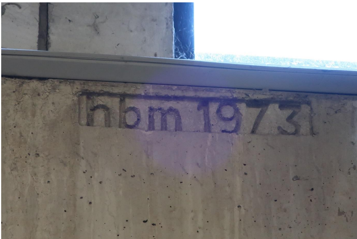
Ingestempelde tekst het beton van de kelder, vlak boven de entree van de hellingbaan. De tekst HBM 1973 verwijst naar de Hollandse Beton Maatschappij, de aannemer van de bouw van gebouw SFF.
