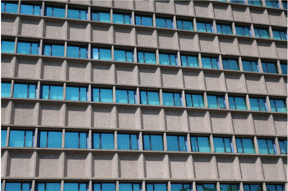
Overzicht van het rasterpatroon in de prefab-gevelplaten van uitgewassen grindbeton. Herkenbaar zijn de horizontale banden (bestaande uit dubbelpanelen) en vensterstroken met 'schaduwkolommen'.
