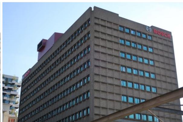
Rechts: overhoeks zicht van de zuid- en westgevel. De hoge dakrand heeft op de hoeken diepe insnijdingen, die aansluiten op de overhoekse elementen van de gevel.
