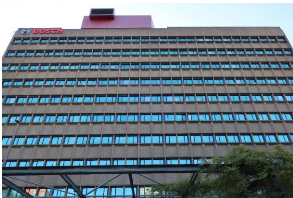
Links: overzicht van de westgevel.
