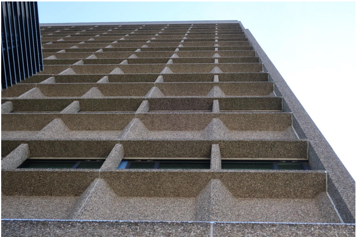
Overzicht van de gevel. Op deze foto valt goed te zien dat er sprake is van dubbelpanelen, hoekstukken en schaduwkolommen in de vensterstroken. Aan de rechterzijde zijn de verticale hoekelementen te zien, overhoekse panelen met ribben.
