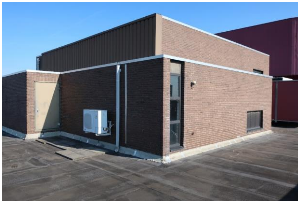
Links: de bakstenen dakopbouw voor de liftmachines.
