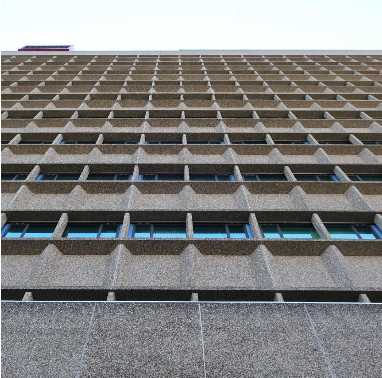
Overzicht van de westgevel. Het rasterpatroon in de gevelpanelen valt duidelijk te herkennen. Aan de onderzijde is de band van het basement herkenbaar.
