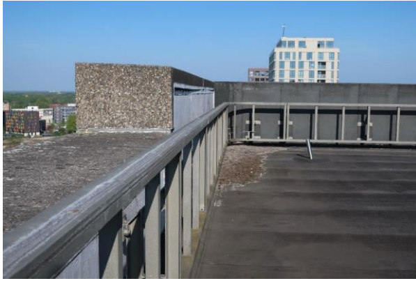
Links: de borstwering van het platte dak, waarachter een rail voor de glazenwasinstallatie.
