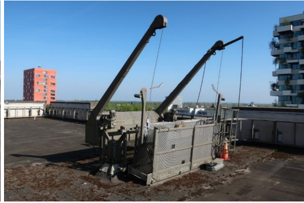
Links: de borstwering van het platte dak, waarachter een rail voor de glazenwasinstallatie.
