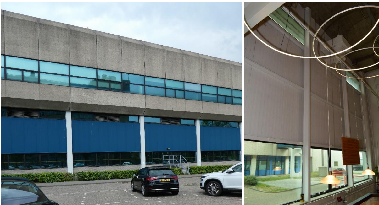
Links: deelloverzicht van de zuidgevel van de onderbouw. De gevel van de begane grond wordt geleed door de betonkolommen van de constructie. Daartussen bevinden zich betonstenen plinten en staalconstructies met puien, bestaande uit vensters en stalen damwandprofielen. Rechts: overzicht van de staalconstructie van een van de puien op de begane grond (middengedeelte van de noordgevel).
