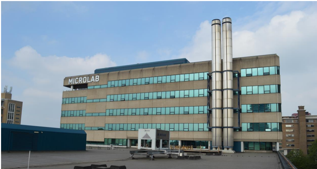
De oostgevel van de hoogbouw. De trappenhuizen zijn herkenbaar aan de afwijkende vensterstroken. De twee schoorstenen aan de rechterzijde verhullen overigens één van deze trappenhuizen.
