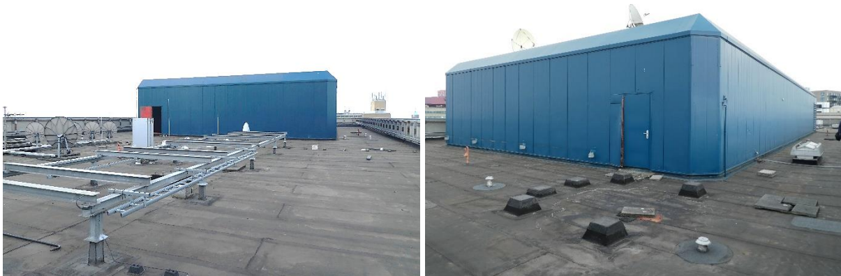
De installatieruimte op het dak van de hoogbouw, waarvan de gevels bestaan uit geïsoleerde damwandplaten.
