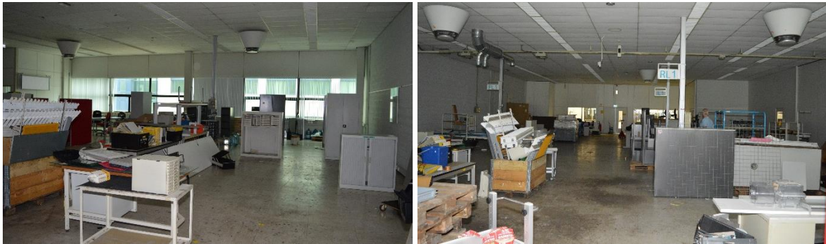
Kantoor- en laboratoriumruimten in het westelijk deel van de eerste verdieping, voorzien van voorzetwanden en systeemplafonds uit circa 2000. De staalconstructie met vakwerkspanten viel nergens te herkennen, afgezien van de (omklede) staalkolommen op een stramien van 15,60 x 15,60 meter.
