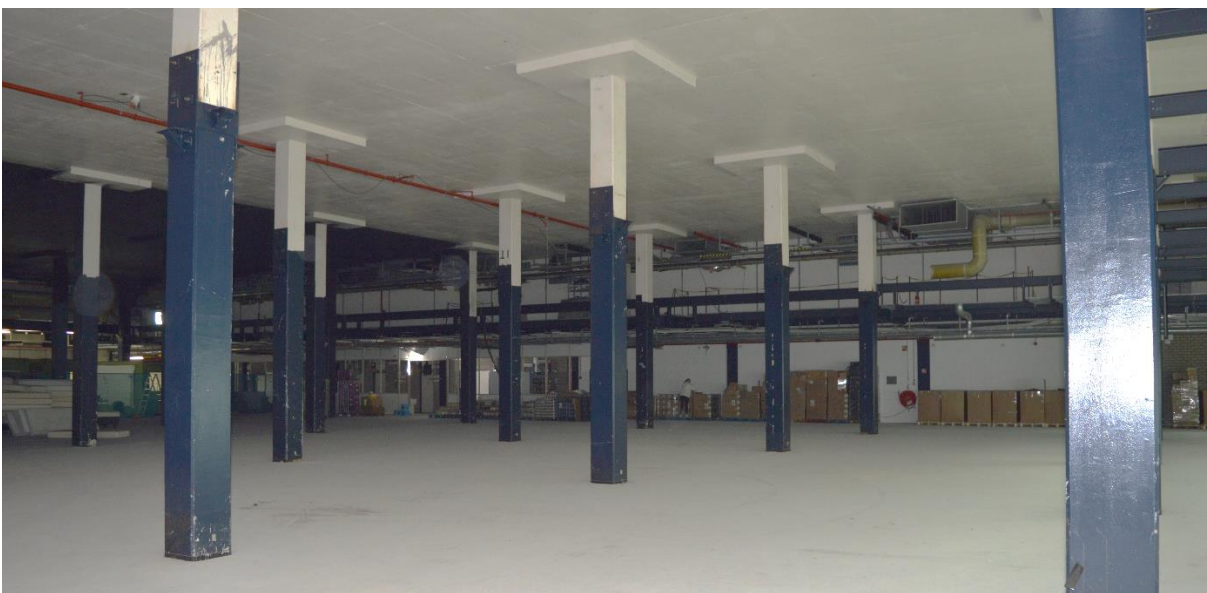
Overzicht van de begane grond van de oostvleugel. Er is sprake van een gewapend betonnen 'paddestoelvloer' met vlakke kolomplaten. De betonvloer is onlangs vernieuwd.
