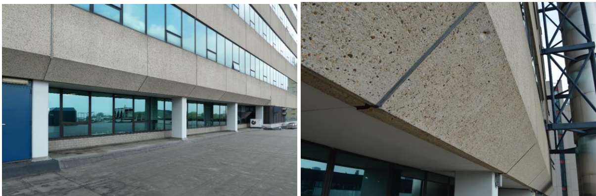
Links: de terugliggende pui op de tweede verdieping van de hoogbouw.
