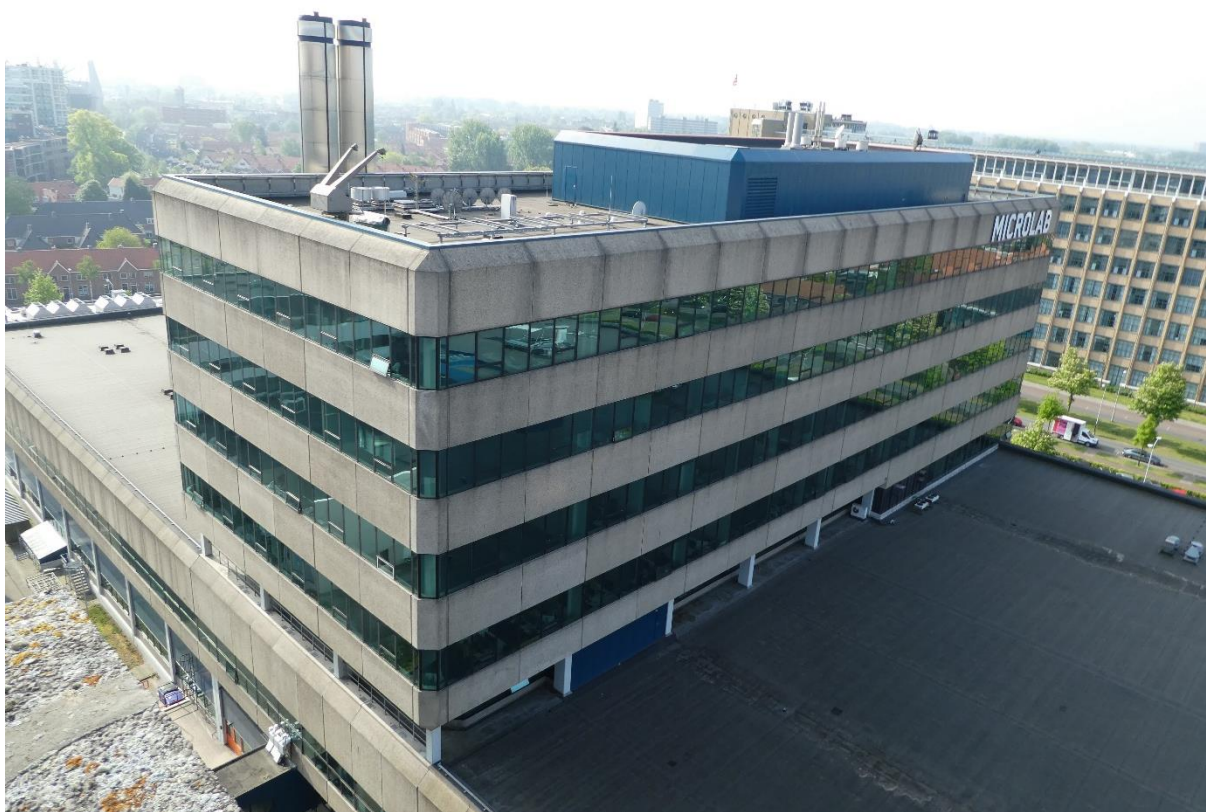
Overzicht van de hoogbouw van gebouw SFH, gezien vanaf het dak van het Videolab (gebouw SFJ).
