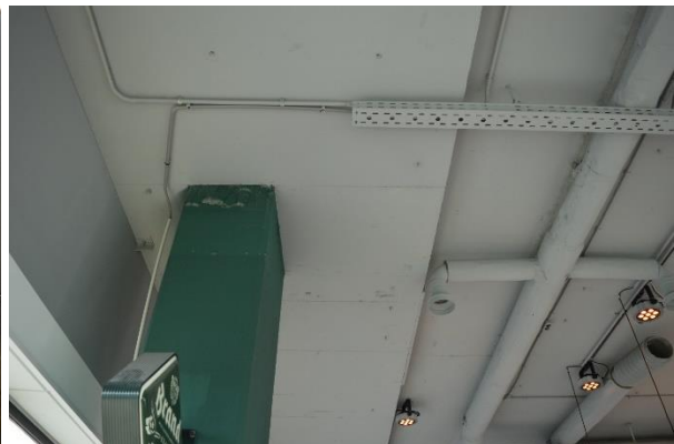
Rechts: aansluiting van een wandkolom op de verzwaarde rand van het vloerveld ter plaatse van de zuidelijke kopgevel, gezien in de kantine op de zesde verdieping.
