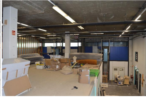
Insteeke verdiepingen op de begane grond van de westvleugel, voorzien van ijzeren buisleuning. Bij de insteeke verdieping aan de rechterzijde is de buisleuning verwijderd.
