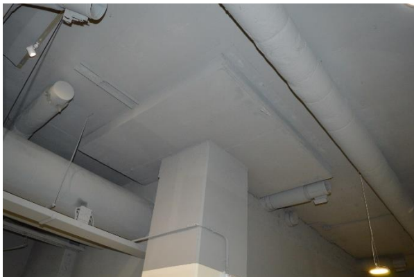
Links: één van de paddestoelvloeren op de zesde verdieping.
