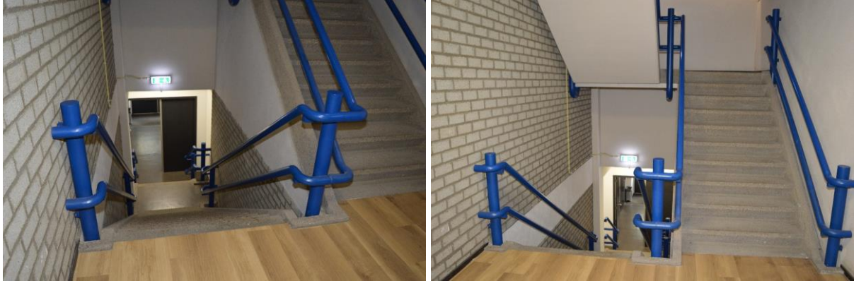
Eén van de noordelijke trappenhuizen in het midden van de begane grond met zicht op de nooduitgang in de noordgevel. Er is sprake van geprefabriceerde betontrappen met stalen buisleidingen.
