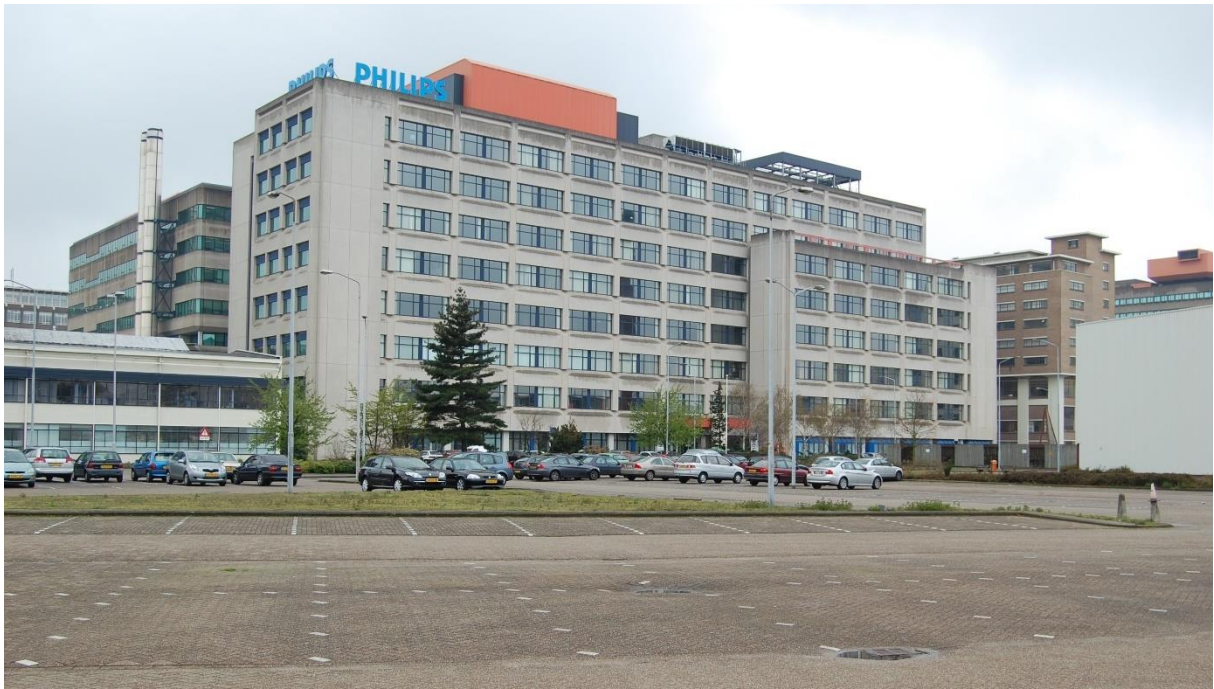
Overzicht van gebouw SFJ vanaf het parkeerterrein aan de noordzijde (na sloop van gebouw SL), foto april 2008.
