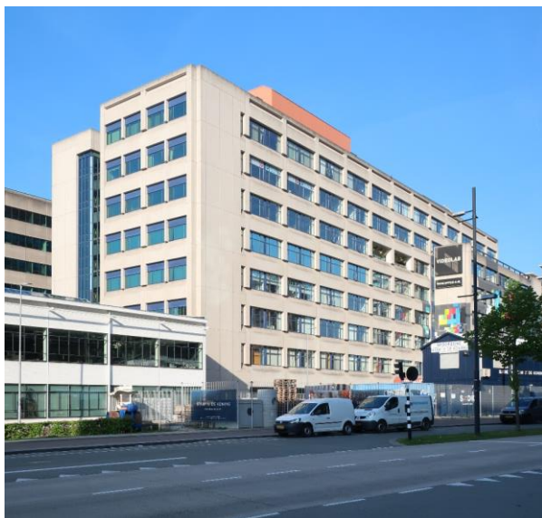
Links: het gebouw SFJ vanuit het noordoosten.
