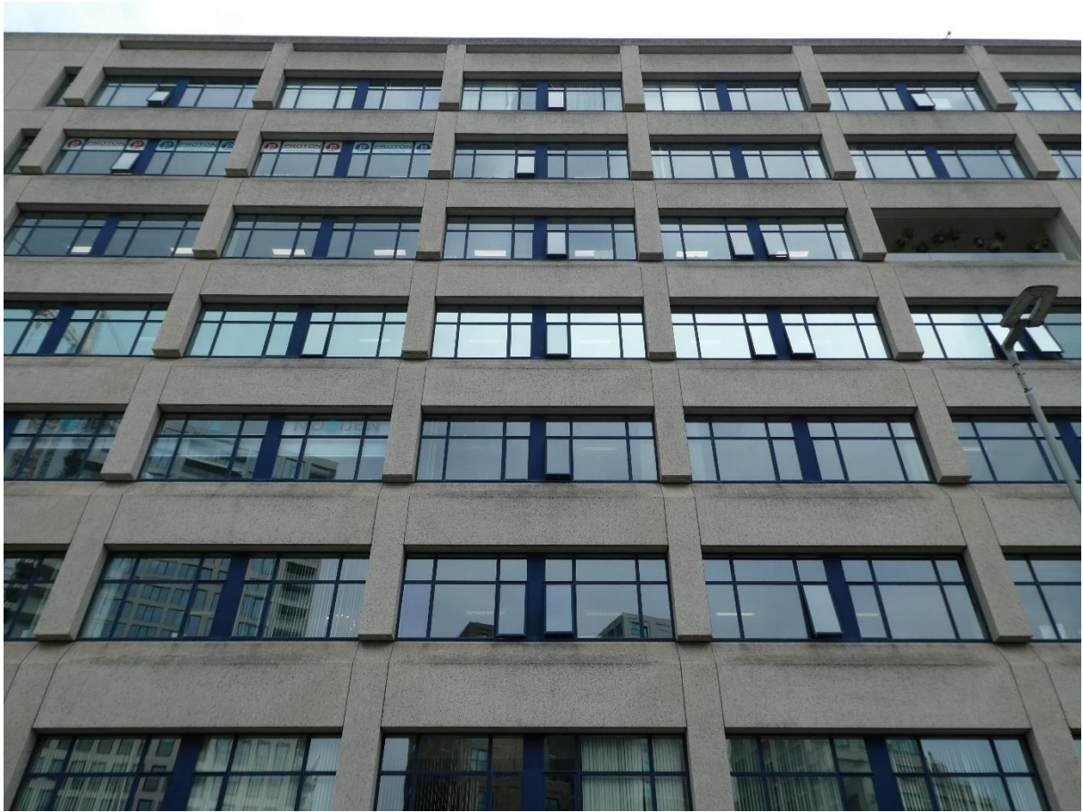
Detail van de noordgevel. De gevel is bekleed met brede borstweringsplaten en verdiepingshoge verticale platen. De platen verhullen de kolommen van de betonconstructie.
