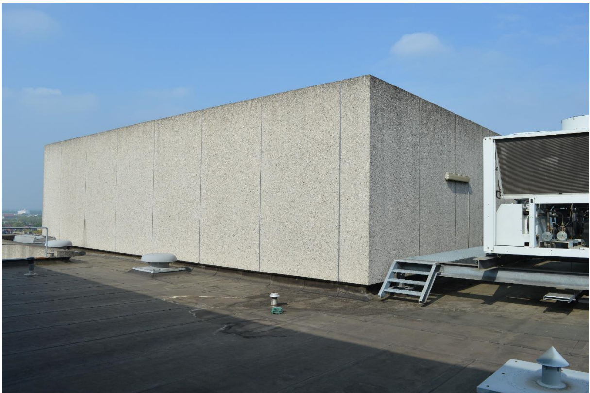
Dakopbouw van trappenhuis en liftmachinekamer, bestaande uit een betonconstructie en prefab gevelplaten.
