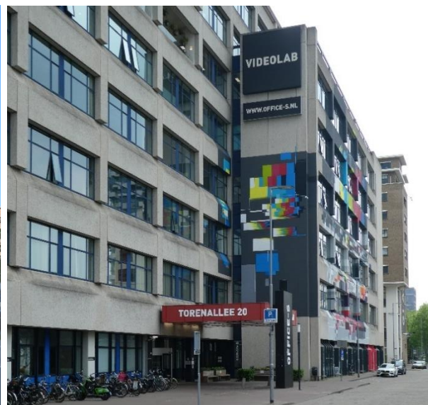
Rechts: de sprong in de noordgevel. De zeslaags voorbouw is door middel van een terugliggende verticale vensterstrook van de achttlaags hoofdbouwmassa los gehouden.
