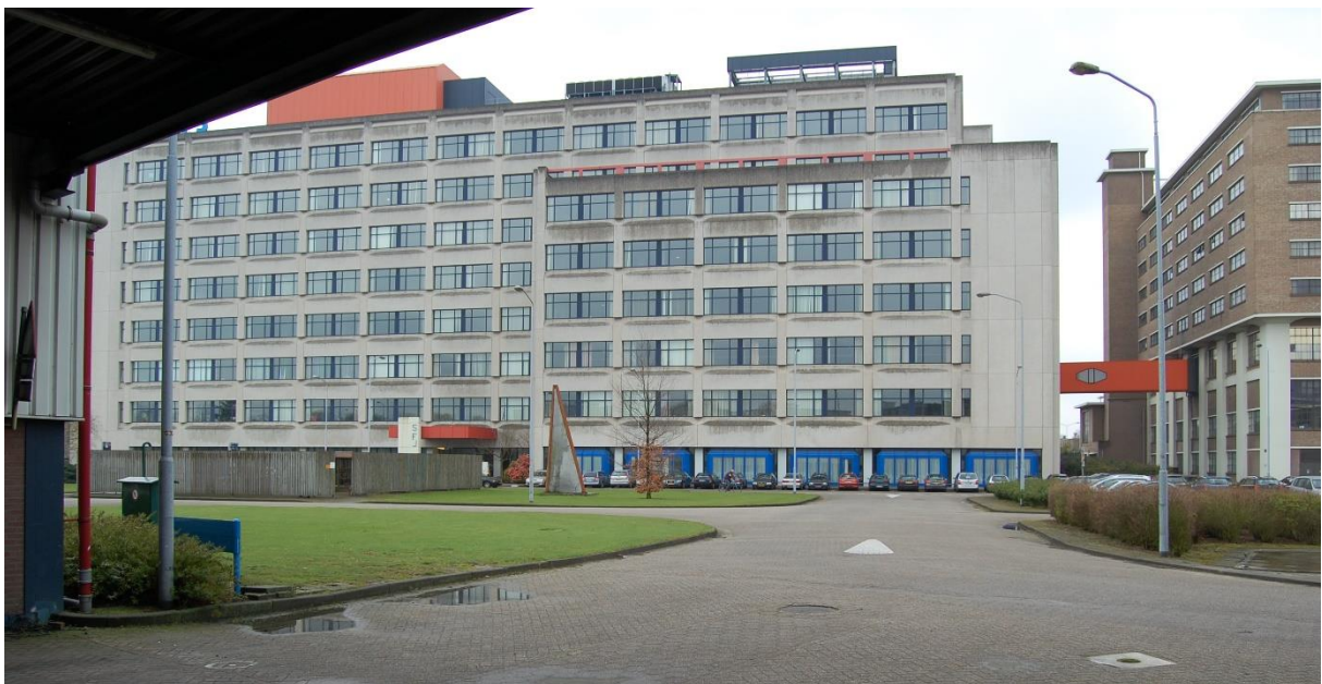
Overzicht van gebouw SFJ, foto april 2008.
