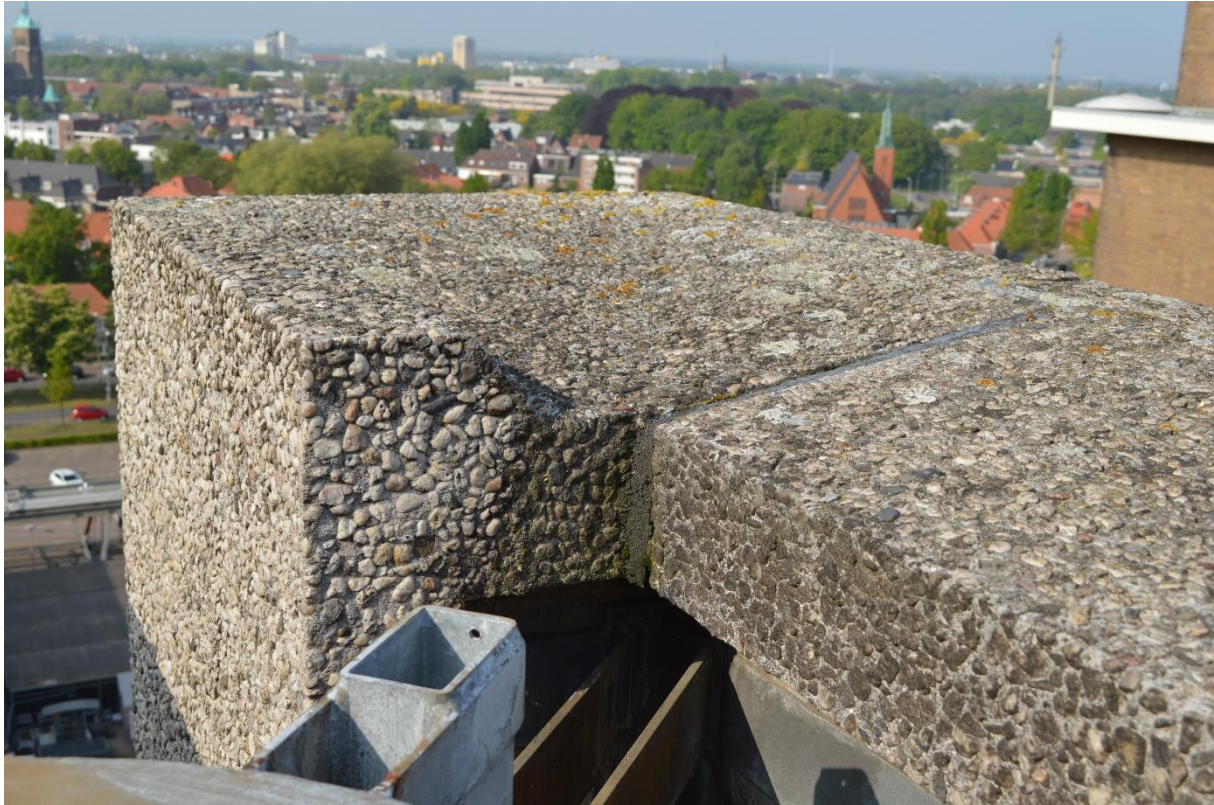
De bovenrand van de betonnen gevelplaten. Deze platen wateren af naar de binnenzijde.
