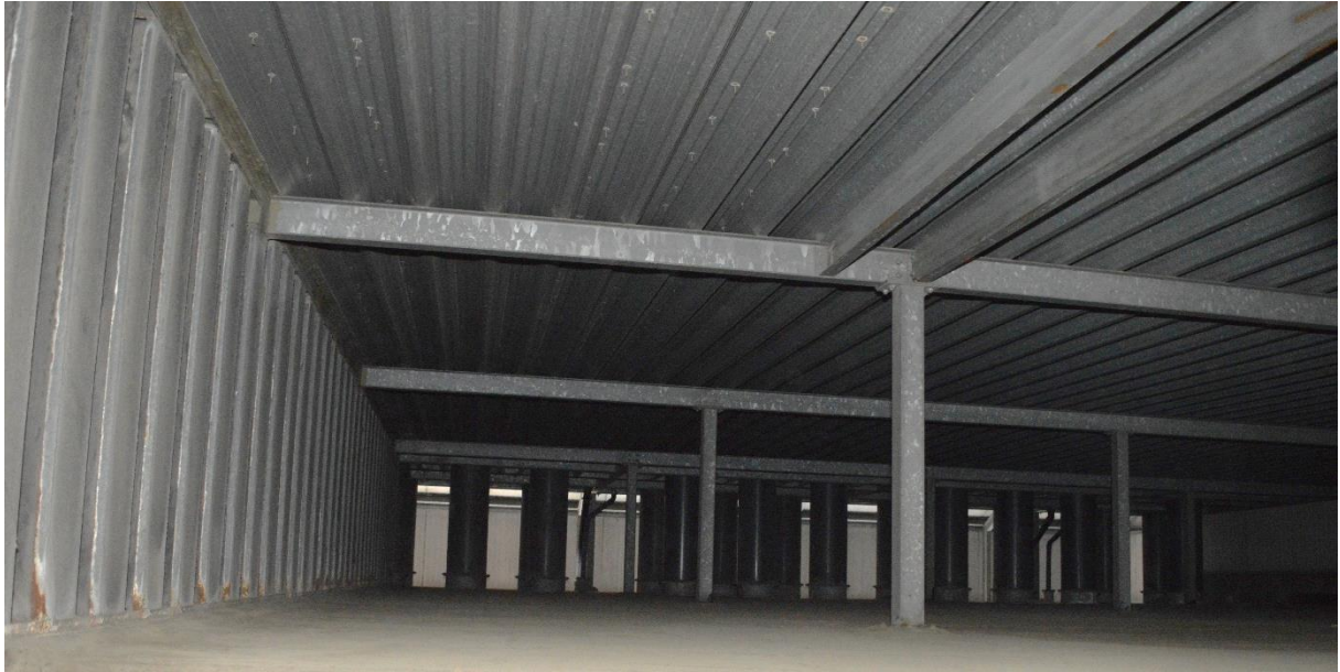
De stalen bovenbouw van de overkragende luchtinlaat van de ventilatie-opbouw, bestaande uit een staalskelet met een buitenbekleding van damwandprofielen.
