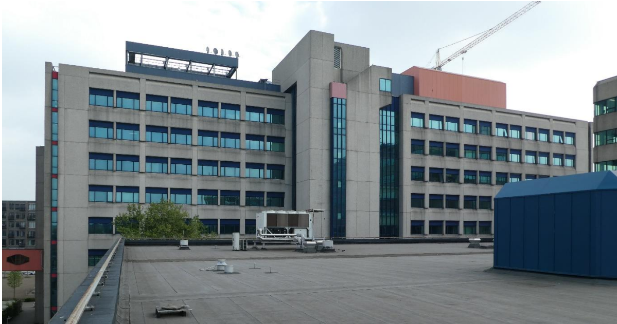
Overzicht van de zuidgevel van gebouw SFJ, gezien vanaf het platte dak van het westelijke deel van de onderbouw van gebouw SFH. De onderste drie verdieping gaan schuil achter dit gebouw.
