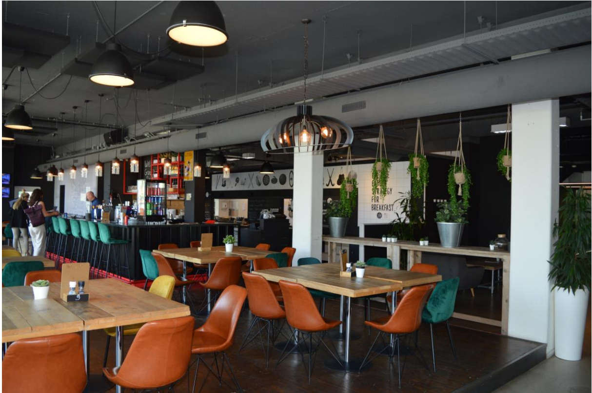
Overzicht van de begane grond van het kantoorgebouw, heringericht als café. Herkenbaar zijn de kolommen van het spant in de langsrichting van het gebouw. Het verlaagde plafond is verwijderd, zodat de betonvloer en installaties in het zicht zijn.
