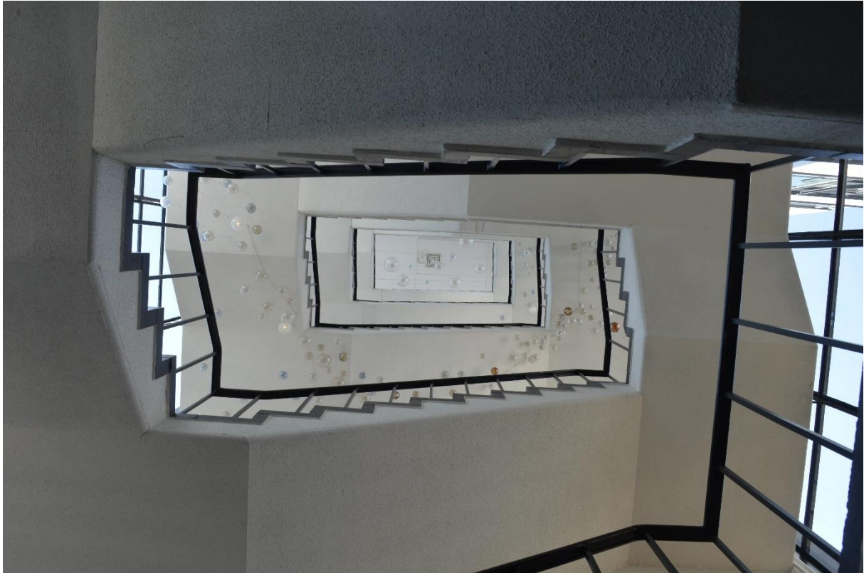
Het schalmgat van het zuidelijke trappenhuis van het kantoorgebouw, gezien naar boven.
