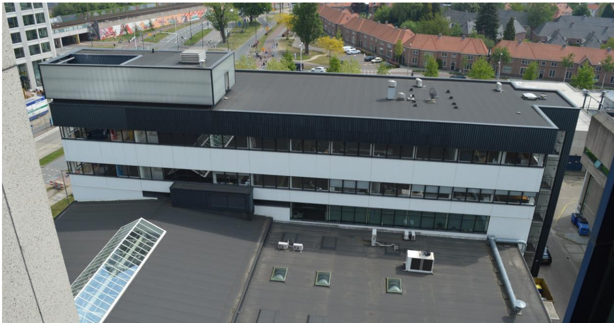
De west- of achtergevel van het kantoorgebouw, gezien vanuit het Videogebouw. Links op de voorgrond is het flauwe zadeldak van het tussengebouw herkenbaar, rechts daarvan de aanbouw.
