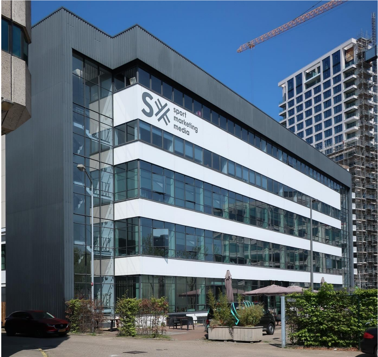
Overhoeks aanzicht van de voorgevel van gebouw SX.
