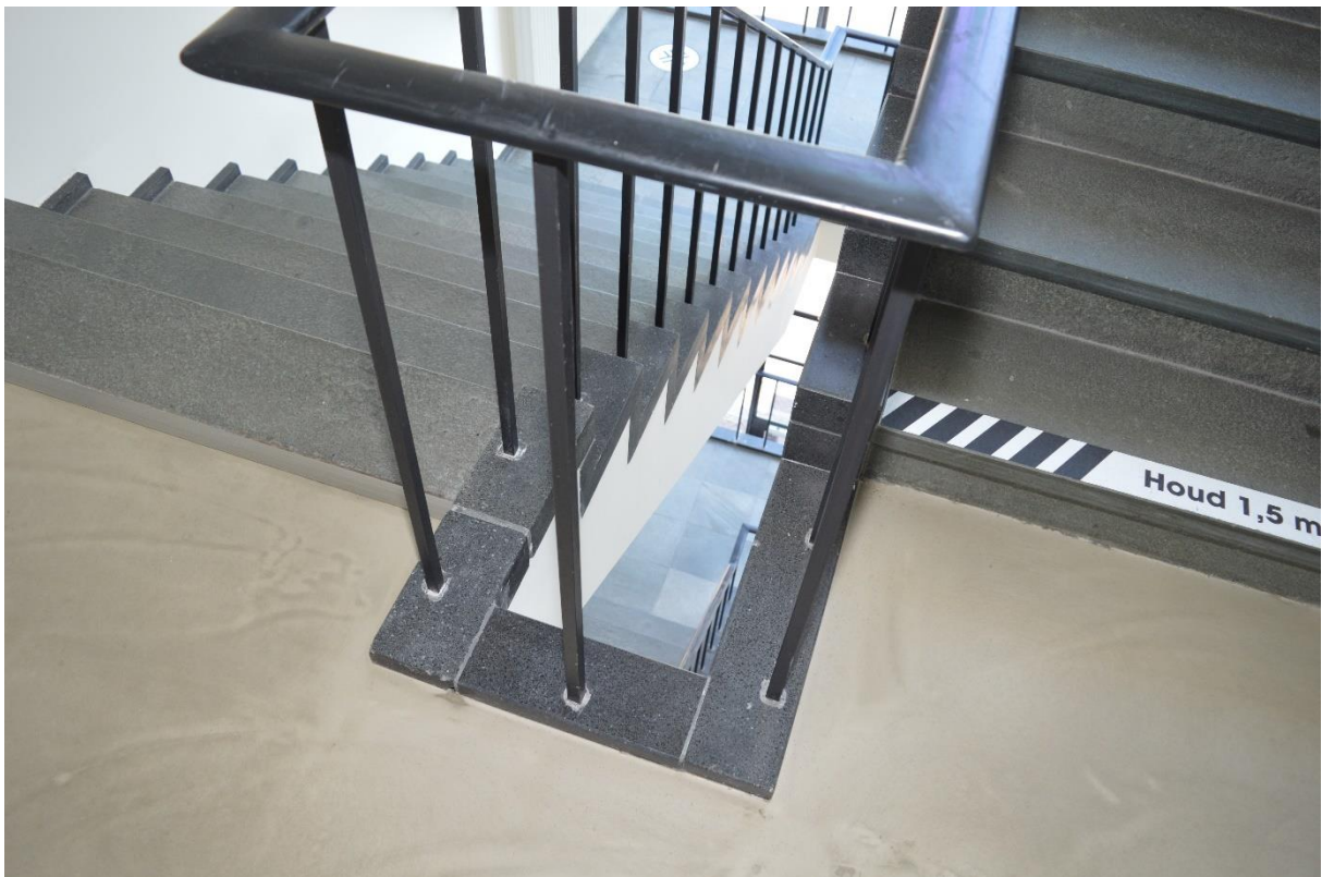
Deeloverzicht van het noordelijke trappenhuis in het kantoorgebouw. Op deze foto vallen de treden en stootborden van (grijs) kwartsiet en de randbekleding van grijze kunststeen goed te herkennen.
