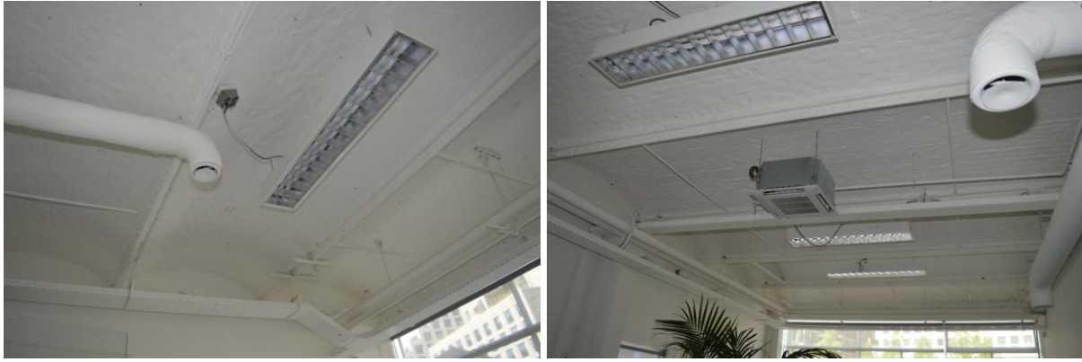
Op de begane grond is de constructie van de verdiepingsvloer zichtbaar, bestaande uit samengestelde stalen balken en bakstenen troggewelfjes.
