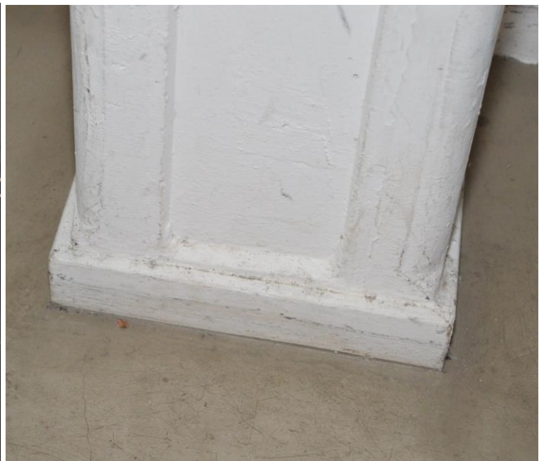
Links: de wandkolommen in de voorgevel, aansluitend op een brede randbalk. De kolommen hebben kwartronde hoekprofielen. Aan de binnenzijde zijn brede sleuven uitgespaard om dwarswanden op te kunnen aansluiten.
