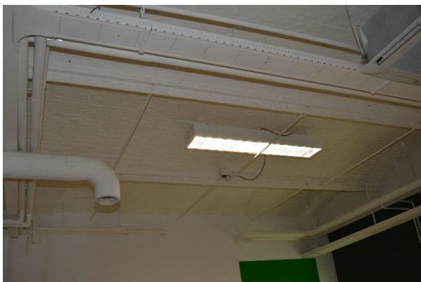
Langs de westgevel bevindt zich een smalle zone met stalen balken en bakstenen troggewelfjes, een restant van een originele tweelaags aanbouw tegen het tussengebouw (1917-'18). Deze constructie is gelijk aan die van de begane grond van het tussengebouw.
