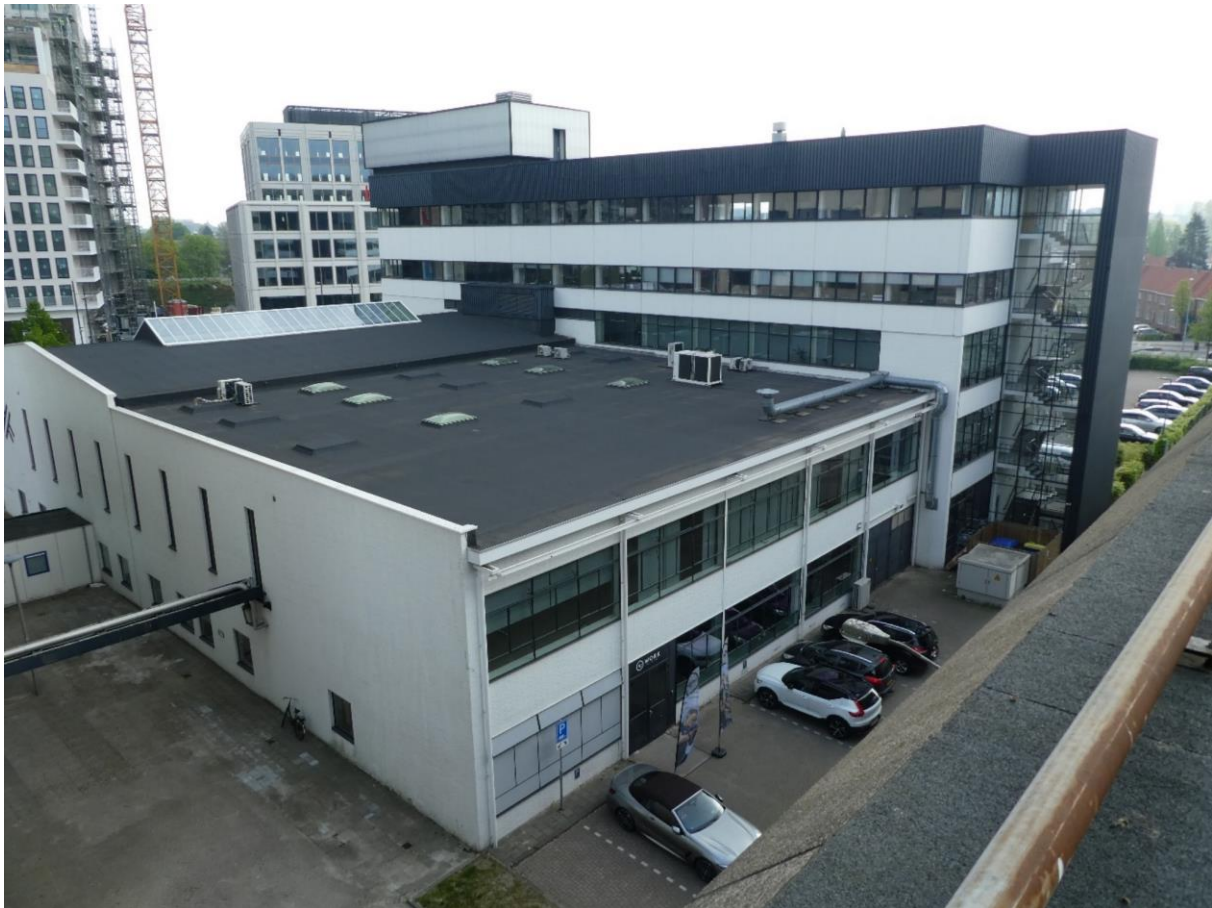
Overzicht van gebouw SX/ SWB, gezien vanaf het dak van het videolab. Op deze foto is de opbouw uit drie delen goed herkenbaar. Op de voorgrond de aanbouw tegen het tussengebouw, rechts het kantoorgebouw.
