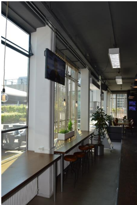
Links: de wandkolommen in de voorgevel, aansluitend op een brede randbalk. De kolommen hebben kwartronde hoekprofielen. Aan de binnenzijde zijn brede sleuven uitgespaard om dwarswanden op te kunnen aansluiten.
