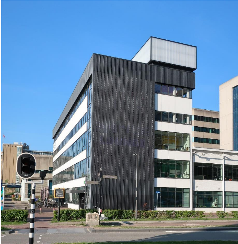
De noordelijke kopgevel van het kantoorgebouw (1964/ 1987). Op het dak staat een opbouw voor installaties. De bekleding met damwandprofielen dateert uit 1987, de video-wand uit 2014.
