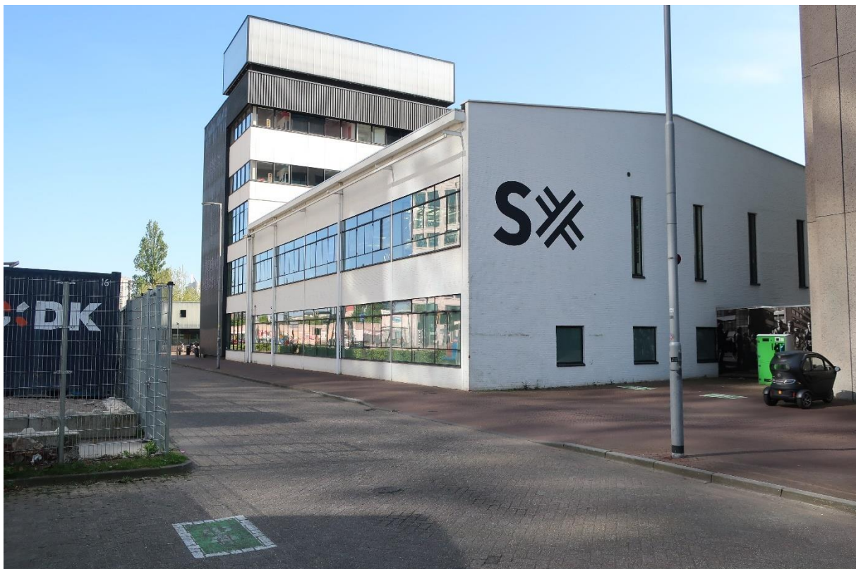
Na sloop van de fabriekshal van het glasgebouw kreeg het resterende gebouw een nieuwe kopwand met slechts enkele vensters. De naam SX staat op de kopgevel van gebouw SWB.
