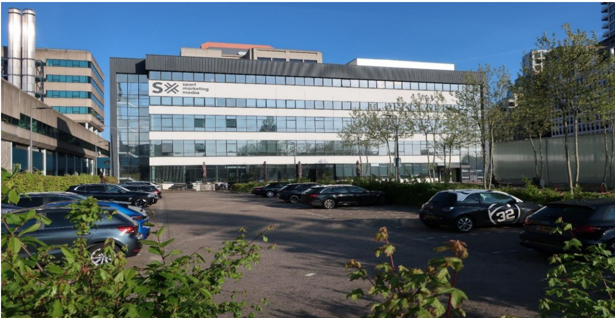
De voorgevel van het kantoorgebouw (1964/1987).
