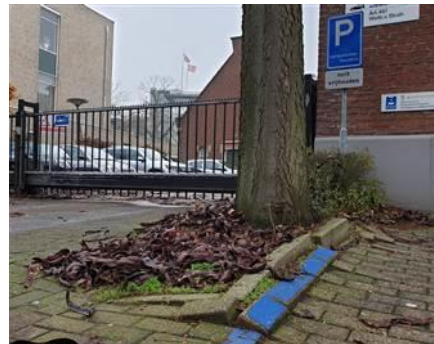
Afbeelding 7: ernstige wortelopdruk in de verharding (foto ter plaatse van boom 1)
