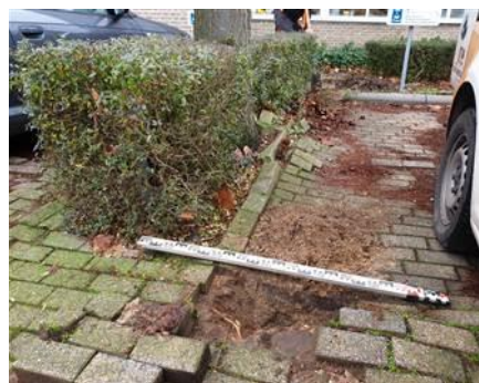
Afbeelding 17: massieve mat van stabiliteitswortels, afgewisseld met fijne opnamebeworteling
