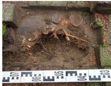
Afbeelding 13: zeer grove beworteling, direct onder de verharding (2)
