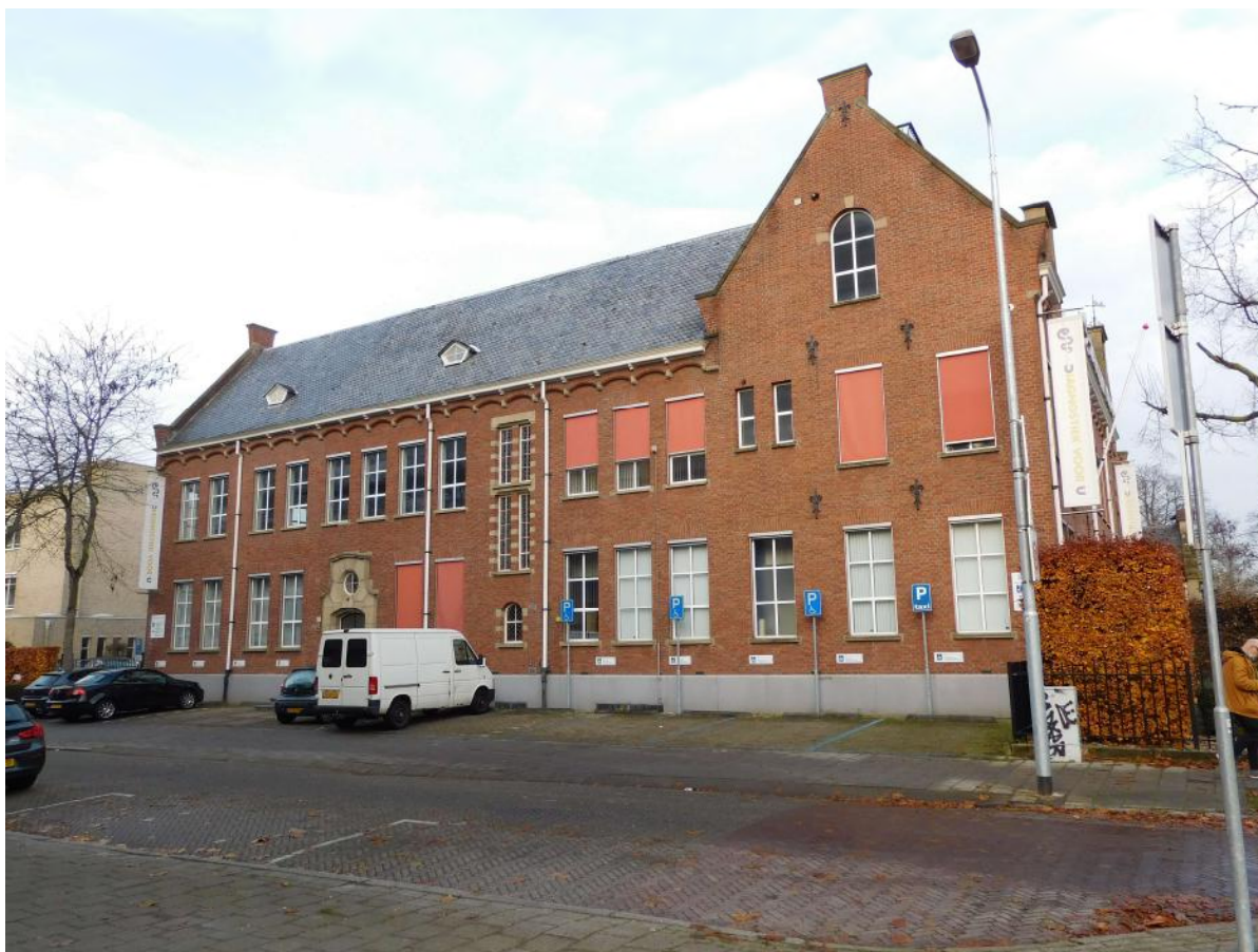
Figuur 26 - De linker zijgevel van het gebouw van de Raad van Arbeid, eveneens rijk gedecoreerd.
