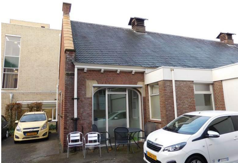
Figuur 15 - Bijgebouwen Stratumsewijk 28a: centraal een deel van de voormalige garage; rechts de tussenbouw.
