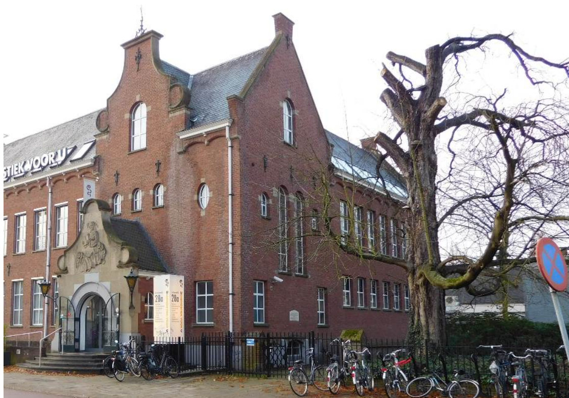
Figuur 10 - De rechter zijgevel van het monumentale gebouw van de Raad van Arbeid in 2020.
