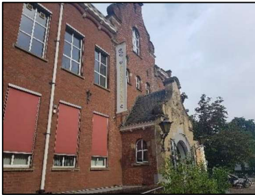
Figuur 3. Voorgevel monumentaal pand, Stratumsedijk 28A
