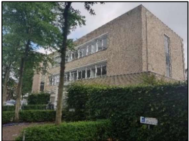
Figuur 9. Voorgevel te slopen gebouw, Bomanshof nr. 6
