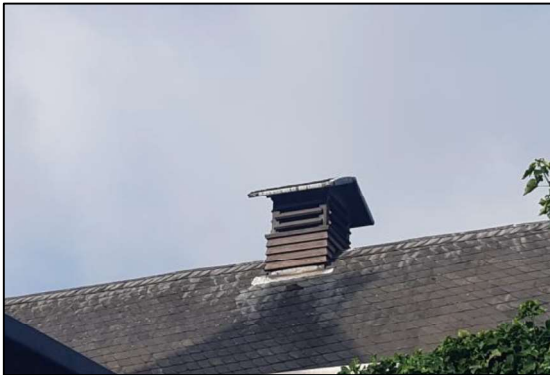
Figuur 12. Zolder van koetshuis (toegankelijk via schoorsteen)
