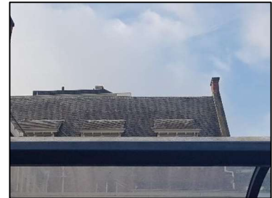
Figuur 11. Dak van deel monumentale pand
