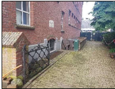
Figuur 4. Zijgevel monumentaal pand en ingang fietsenstalling, Stratumsedijk 28A
