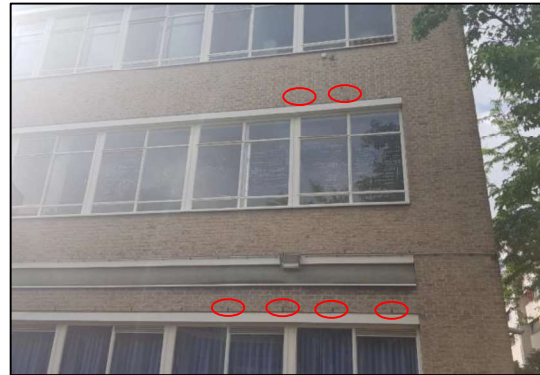
Figuur 13. Open stootvoegen
