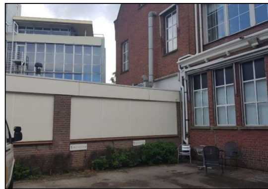
Figuur 15. Aluminium daklijst en betimmering
