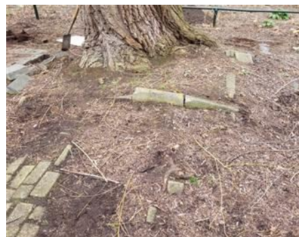
Afbeelding 4: opsluitbanden worden uit het verband gedrukt en overgroeid met wortels bij boom 7
