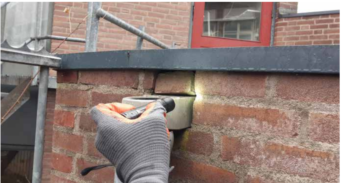
Foto 3: Opening boven een hwa.
