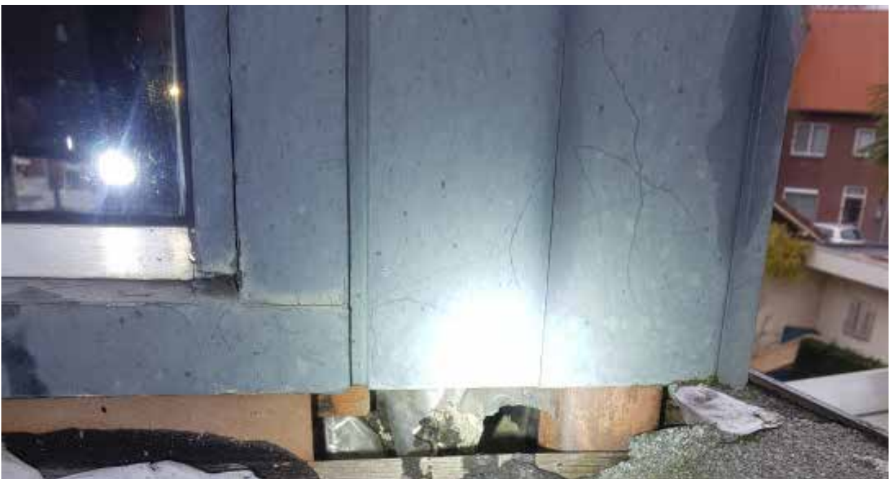
Foto 5: Kleine opening in aansluiting.
