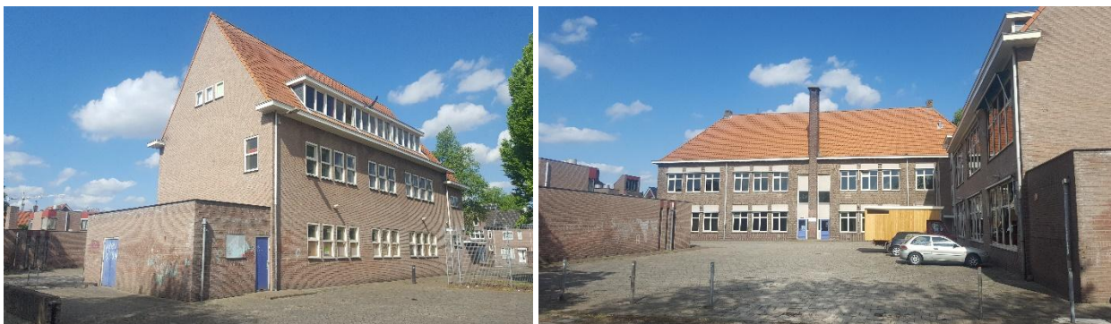
Figuur 2: Links: Tongelresestraat 150 vanuit het oosten, rechts: Tongelresestraat 148 vanuit het zuidoosten
