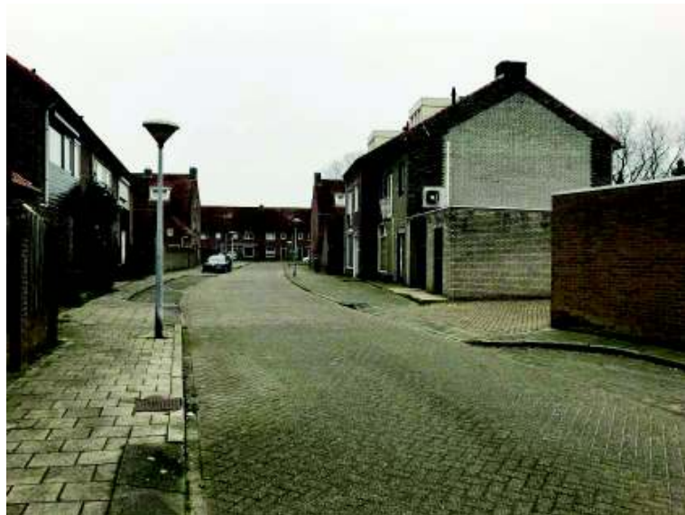
BESTAANDE SITUATIE Kneppelhoutstraat met rechts de 2 te slopen woningen en links overburen
