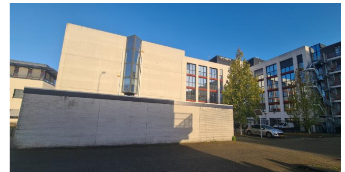
Figuur 9: Plangebied gezien vanuit het zuiden
