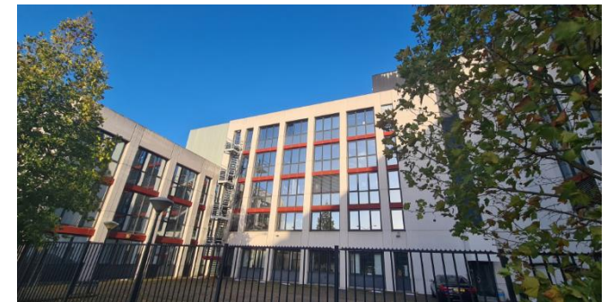
Figuur 6: Plangebied gezien vanuit het zuiden
