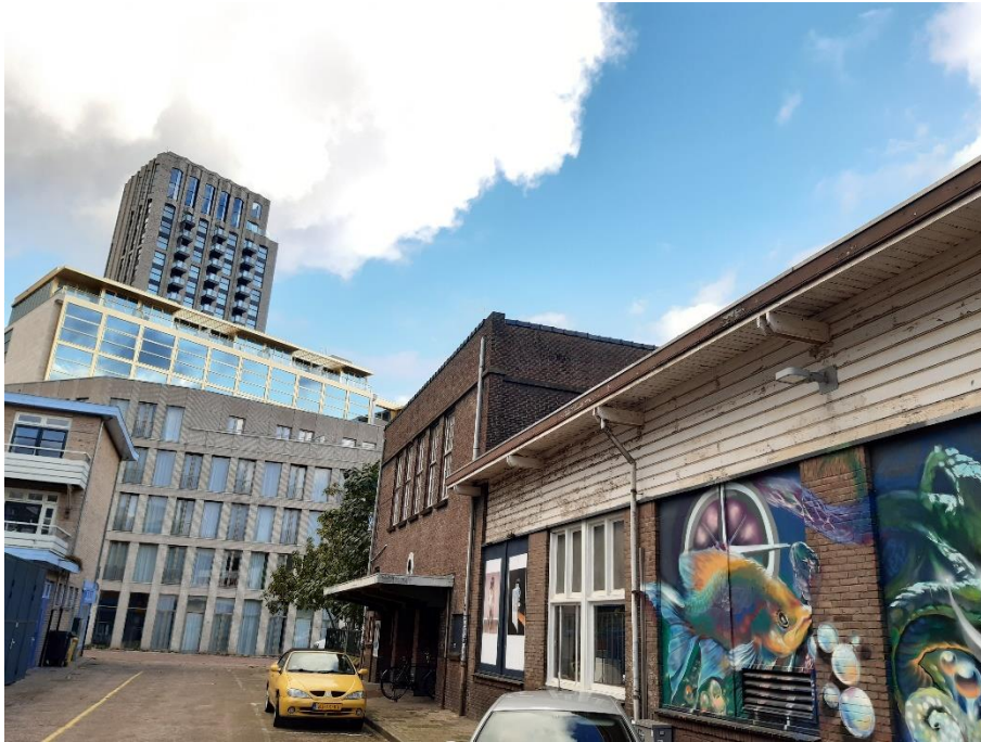
Figuur 3: Het TAC gebouw met overhangende dakpannen.
