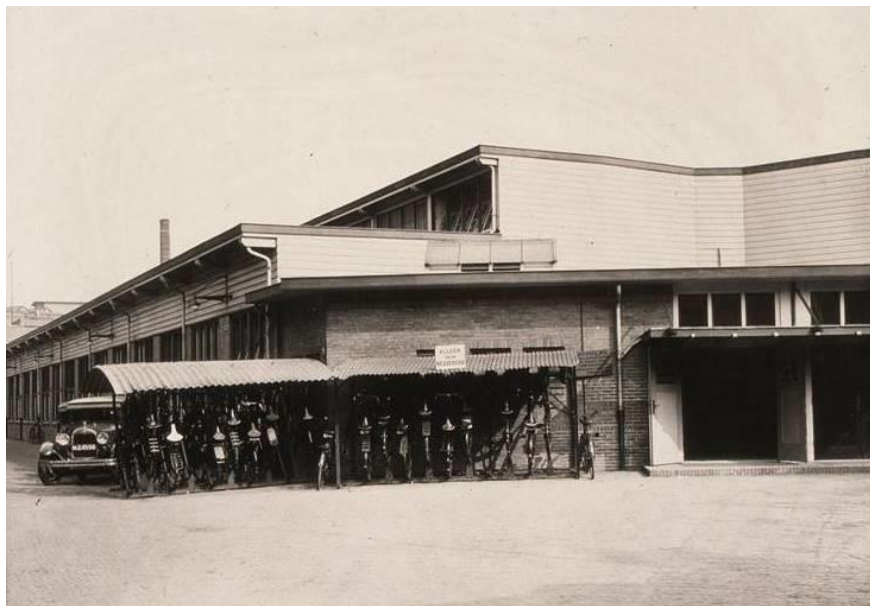
Deze ongedateerde foto toont nog de zeer sobere oorspronkelijke uitvoering van de 'nooduitgang' op de hoek van de Ventoselaan en de Elisabethlaan. Bron: EIB, nr. 19676
