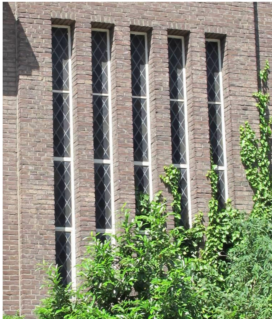
Stalen ramen met glas-in-lood in het hoofdtrappenhuis aan de oostzijde van het tweelaags bouwdeel
