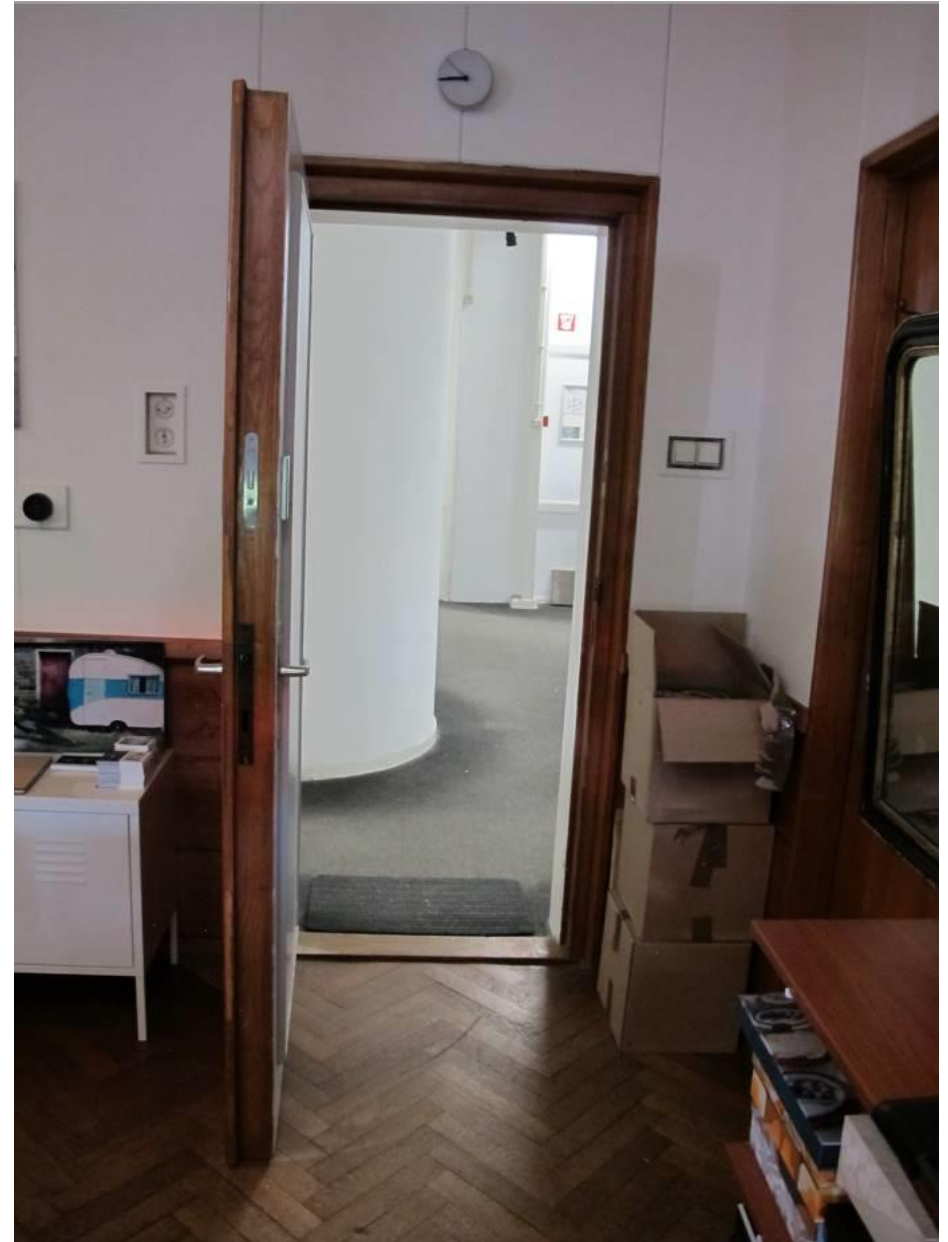
Strokenparketvloer en zeer dik uitgevoerde toegangsdeur
