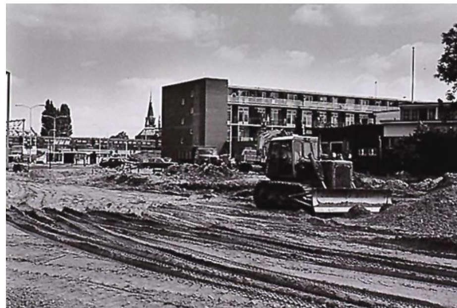
De aanleg van de Vonderweg in 1971. Het westelijke deel van de Ventoseflat is dan al gesloopt. Bron: EIB, nr. 27623
