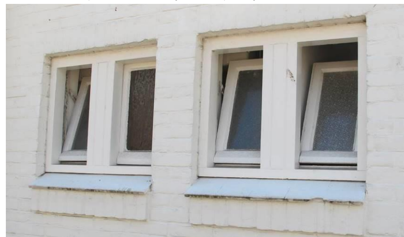
Oorspronkelijke toiletvensters naast de entree op de noordwesthoek. Hetzelfde venstertype is ook bij de toiletten naast de binnenplaats aanwezig
