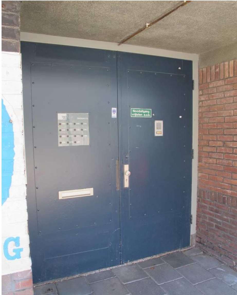
Detail van de dubbele, met plaatstaal beklede toegangsdeuren
