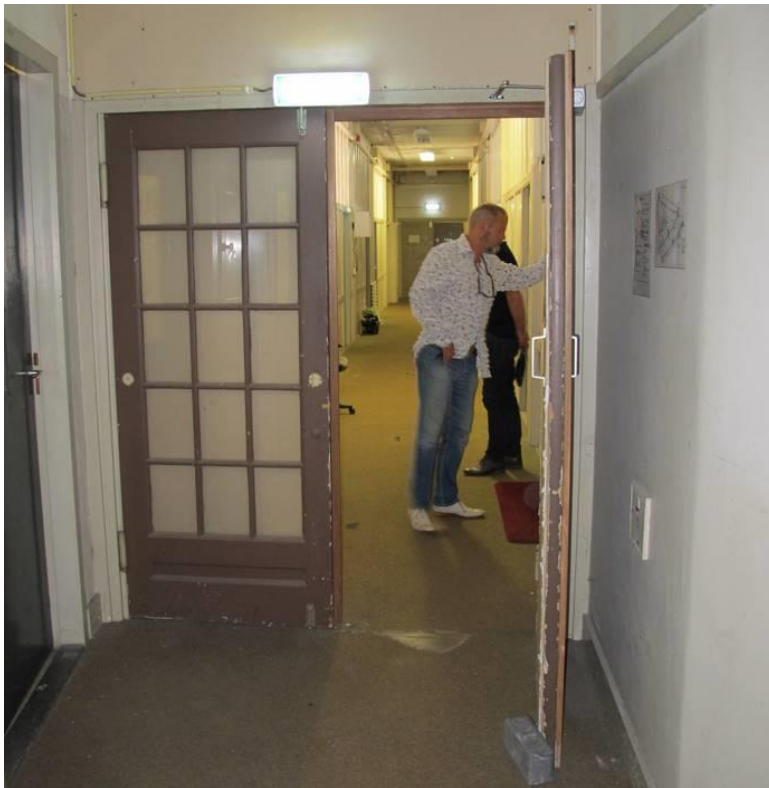
Oorspronkelijke tussendeuren met roedenverdeling
