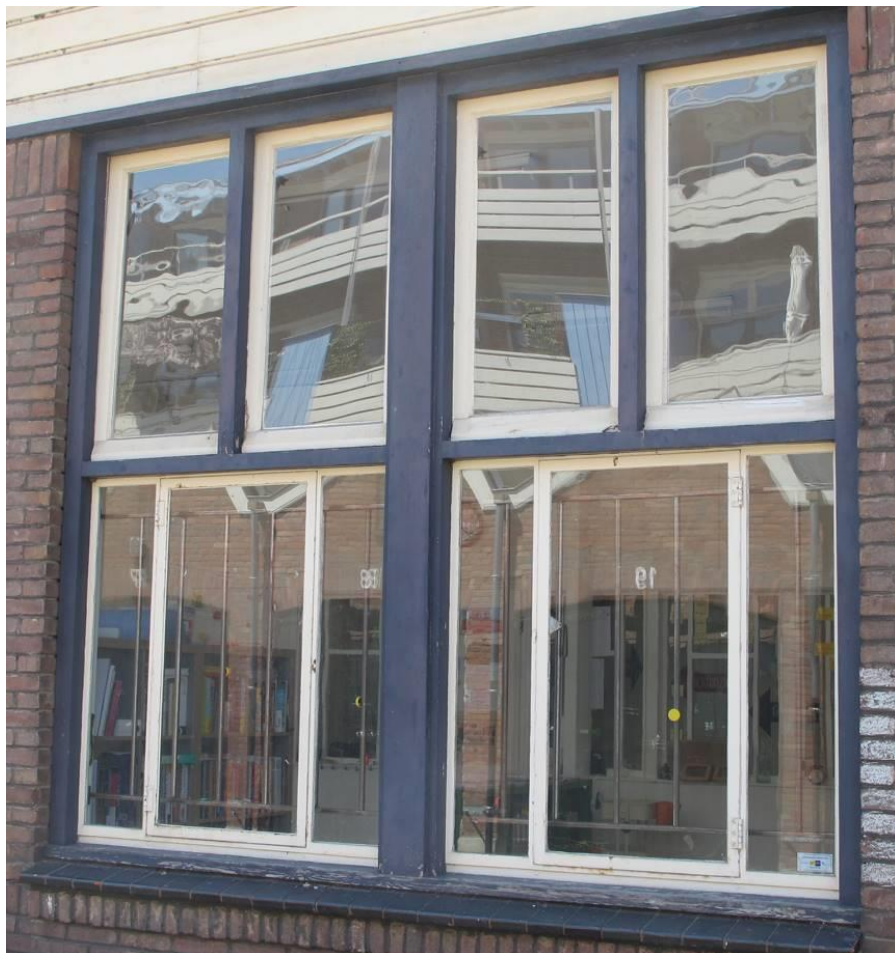
Detail van één van de vensters in de gevel aan de Ventoselaan. Bij dit venster zijn twee stalen ramen ingevoegd. Bij beide buitenste bovenlichten is goed het 'getrokken' glas herkenbaar
