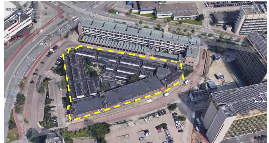
Detail vogelvluchtbeeld van het kantoorgebouw met op de voorgrond de Gagelstraat, aan de bovenzijde de Mathildelaan en links de Vonderweg. De Ventoselaan ligt parallel aan de Mathildelaan tussen het kantoorgebouw en de aan de Mathildelaan gebouwde Ventoseflat. Bron: Google Maps
