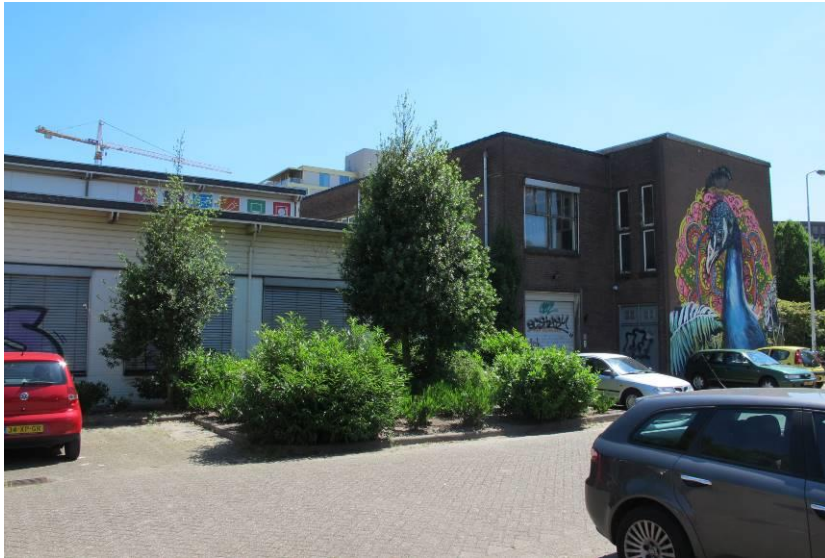
Westelijke kopgevel van het tweelaags bouwdeel, met links aansluitend de gevel van het bouwdeel langs de Vonderweg
