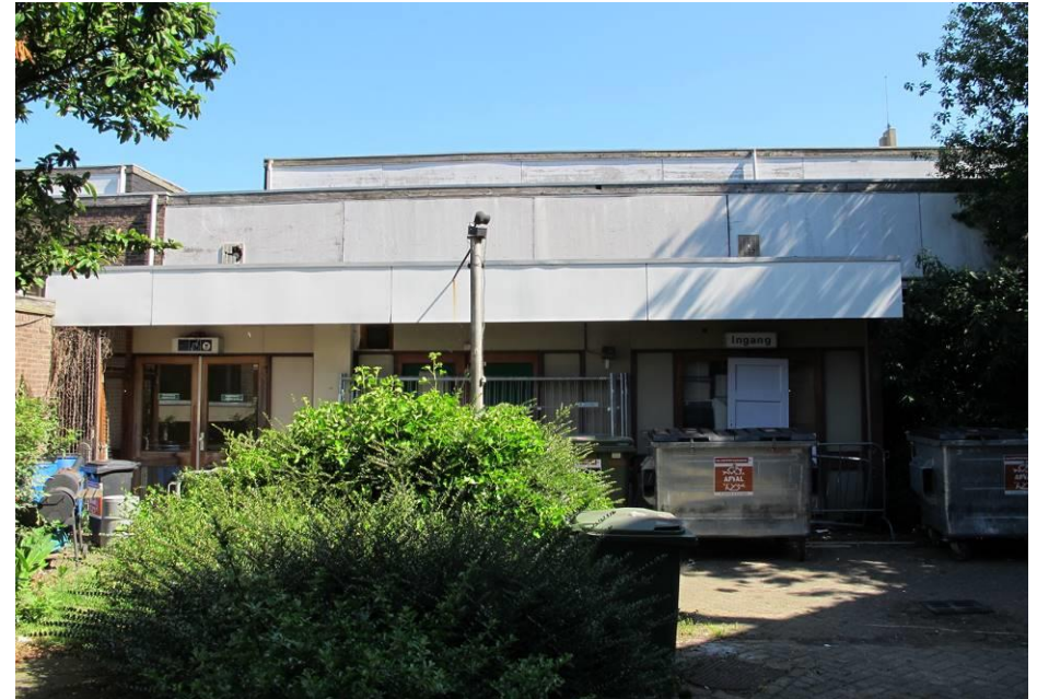
Huidige situatie waarbij de vroegere toegang tot de personeelswinkel tot een berging is omgebouwd en grotendeels is afgeplaat
