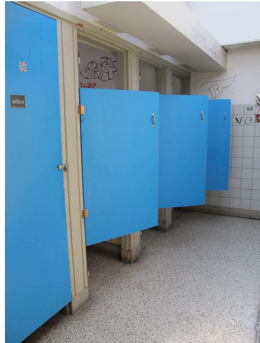
Interieur toiletgroepen met deel oorspronkelijke opzet
