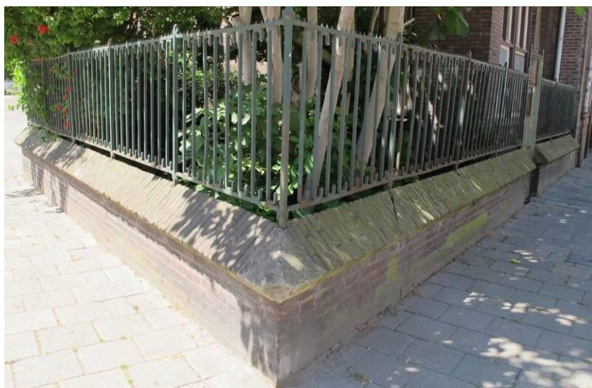
Detail hekwerk op de hoek van de Ventoselaan en de Gagelstraat
