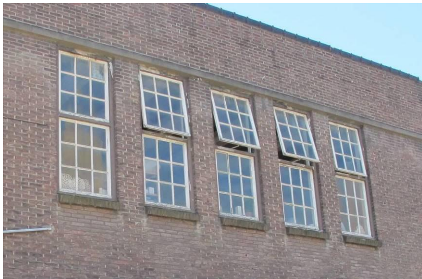
Ramen met een roedenverdeling boven de entree aan de Ventoselaan
