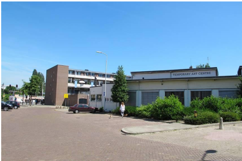
Zicht over de parallelweg langs de Vonderweg in noordelijke richting, met op de achtergrond de Ventoseflat
