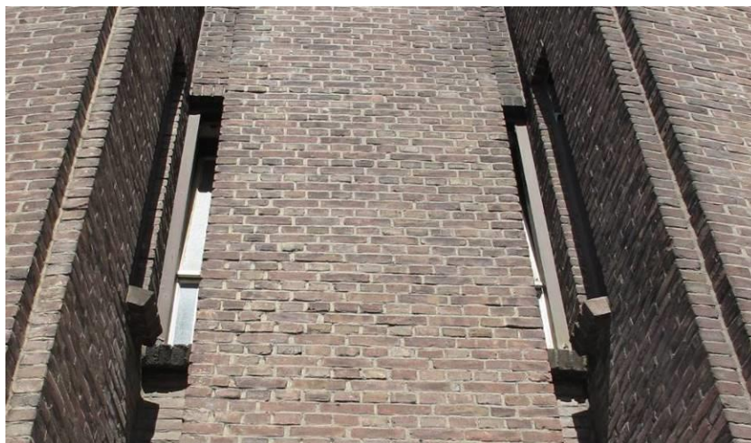
Smalle vensters in de gevel van één van de trappenhuizen
