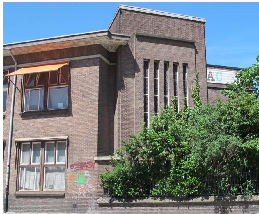
Het oostelijke (hoofd)trappenhuis op de hoek van de Gagelstraat met de Ventoselaan is duidelijk benadrukt in de afgeschuine hoek van het gebouw
