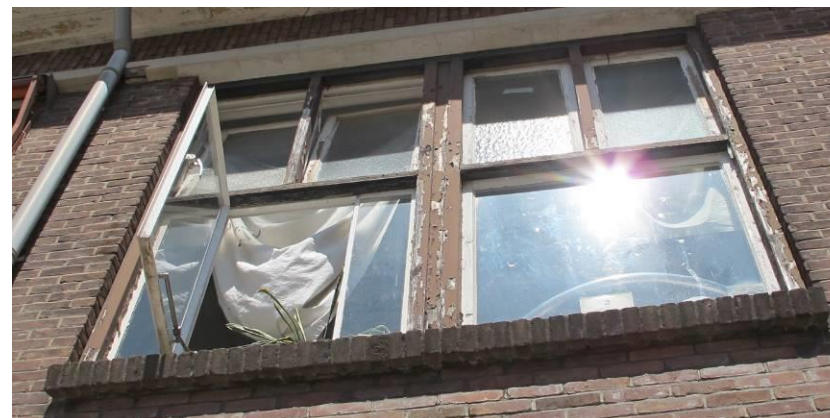
Detail van één van de verdiepingsvensters in de zuidgevel
