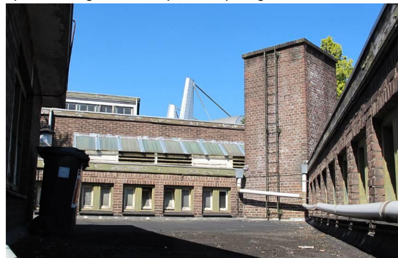
De toiletvensters boven het platdak vormen een symmetrische opzet met de oorspronkelijke schoorsteen aan de oostzijde van het ketelhuis. Het bovenste deel van de schoorsteen is gesloopt
