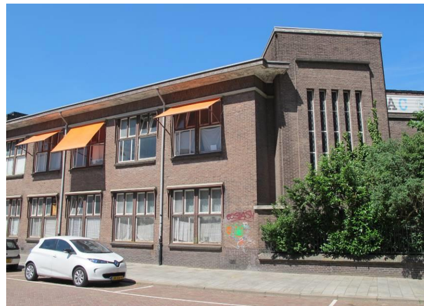
Het hogere trappenhuis op de hoek van de Ventoselaan (rechts) en de Gagelstraat.
