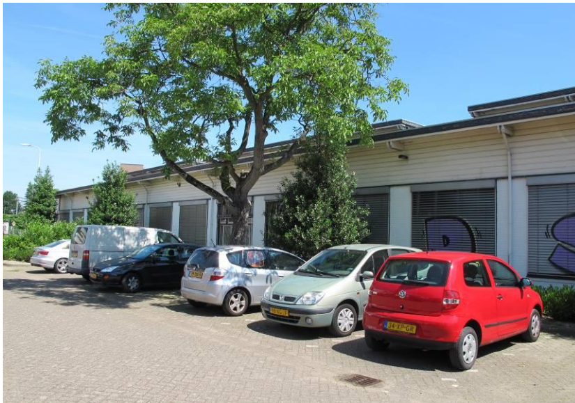
Overzicht gevel langs de Vonderweg
