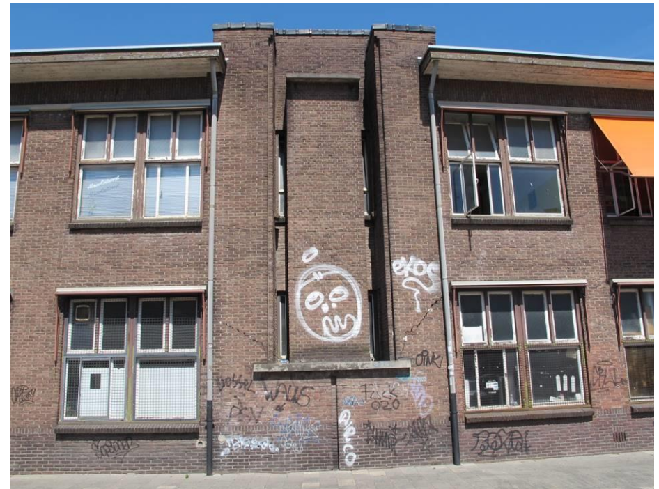
Eén van de in de zuidgevel duidelijk herkenbare toiletgroepen
