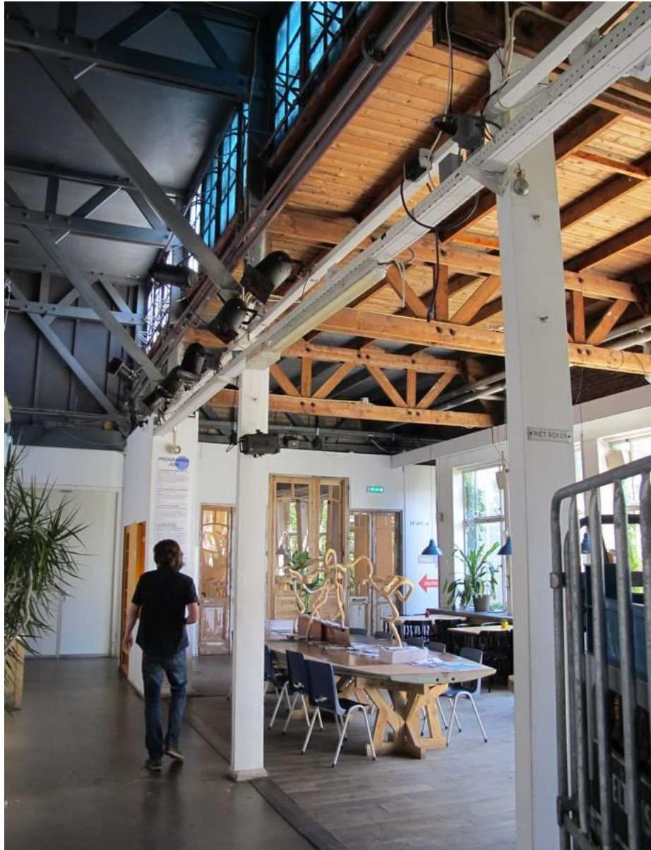
Beeld van de in het zicht liggende constructie in het bouwdeel aan de zijde van de Ventoselaan.
