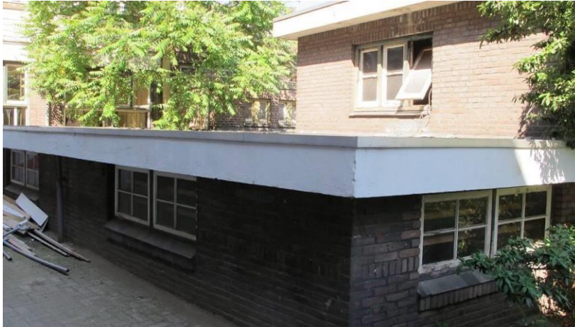
Bij de venster van het ketelhuis werd gekozen voor een roedenverdeling
