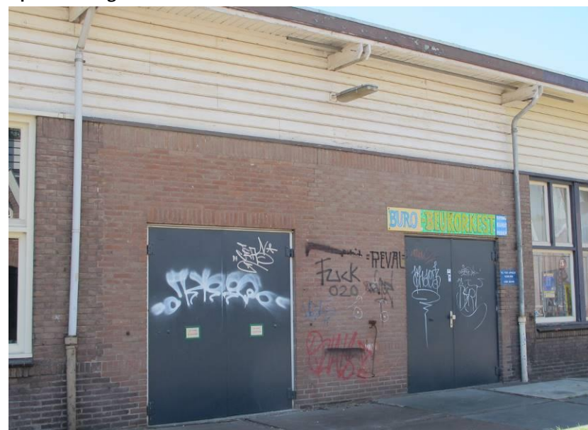
Later ingevoegde dubbele deuropeningen in de gevel aan de Ventoselaan
