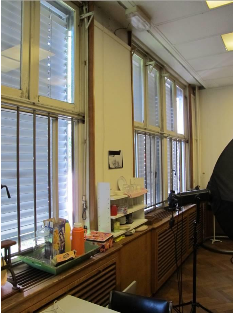
Overzicht van de gevelwand, waar de lambrisering als radiatoromkasting is uitgebouwd
