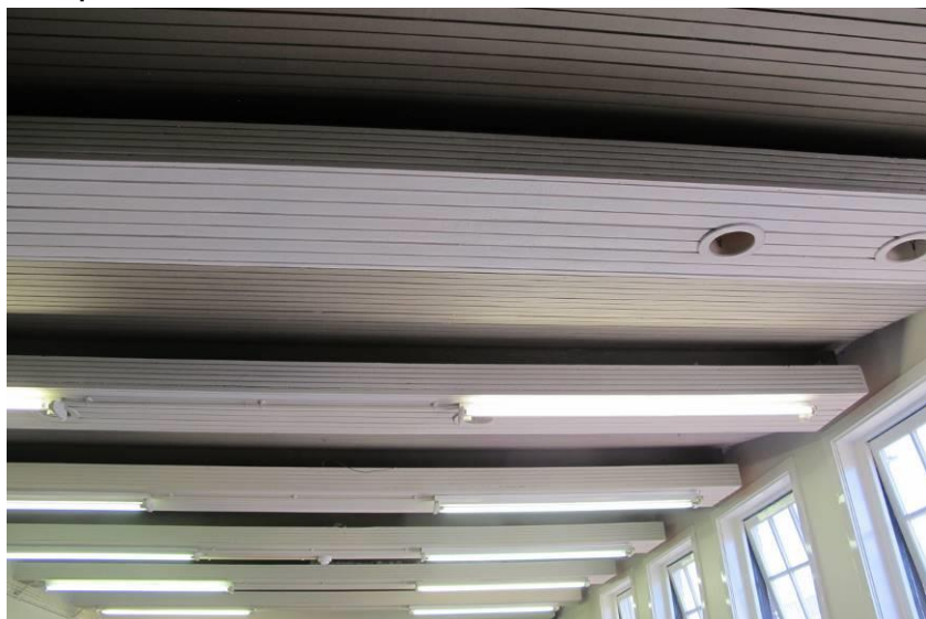
Detail van het schrotenplafond, met waarschijnlijk geïntegreerde armaturen voor indirecte verlichting. De hier zichtbare TL-armaturen zijn later aangebracht
