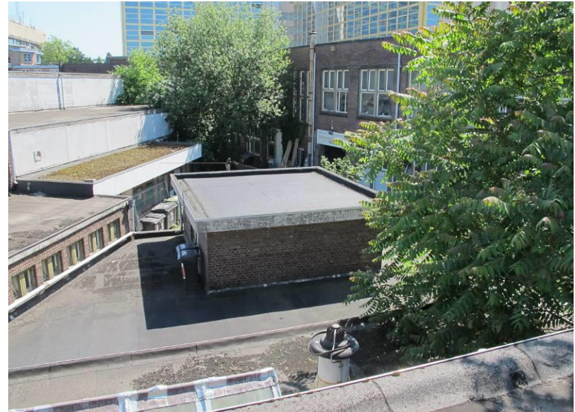
Overzicht van de oorspronkelijke binnenplaats, gezien in noordelijke richting
