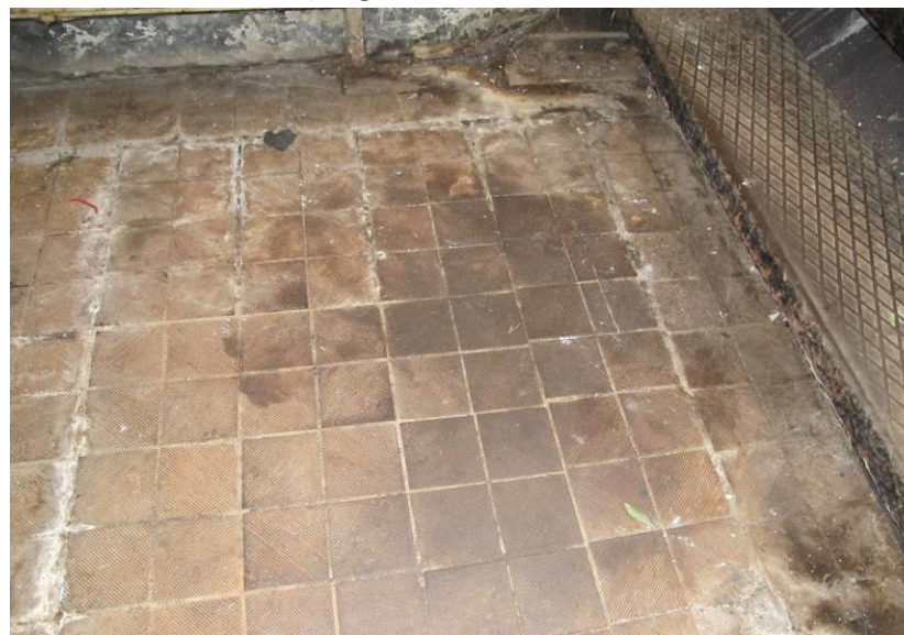
Vloer van gietijzeren tegels in ketelhuis
