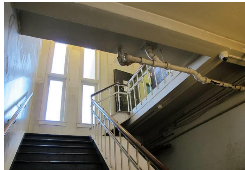
Trapgat in het westelijke trappenhuis binnen het tweelaags bouwdeel
