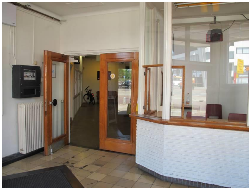
De achterwand (zuidoost) van de vestibule met portiersloge en dubbele glasdeuren naar de achterliggende gang
