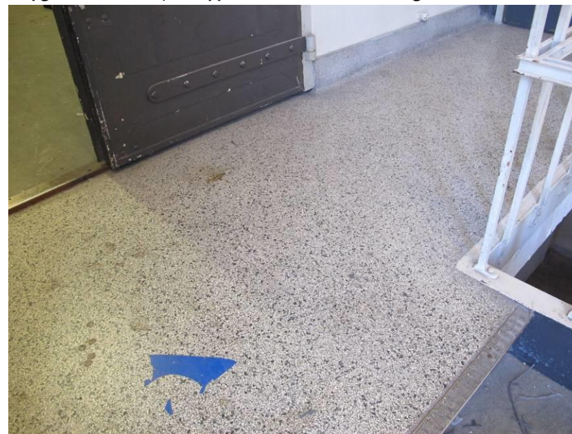
Granitovloer op de verdieping van het westelijke trappenhuis
