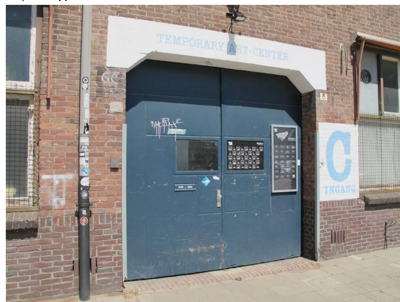
Huidige situatie met dubbele stalen deuren
