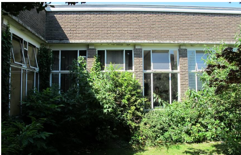
Beeld van één van de binnenplaatsgevels
