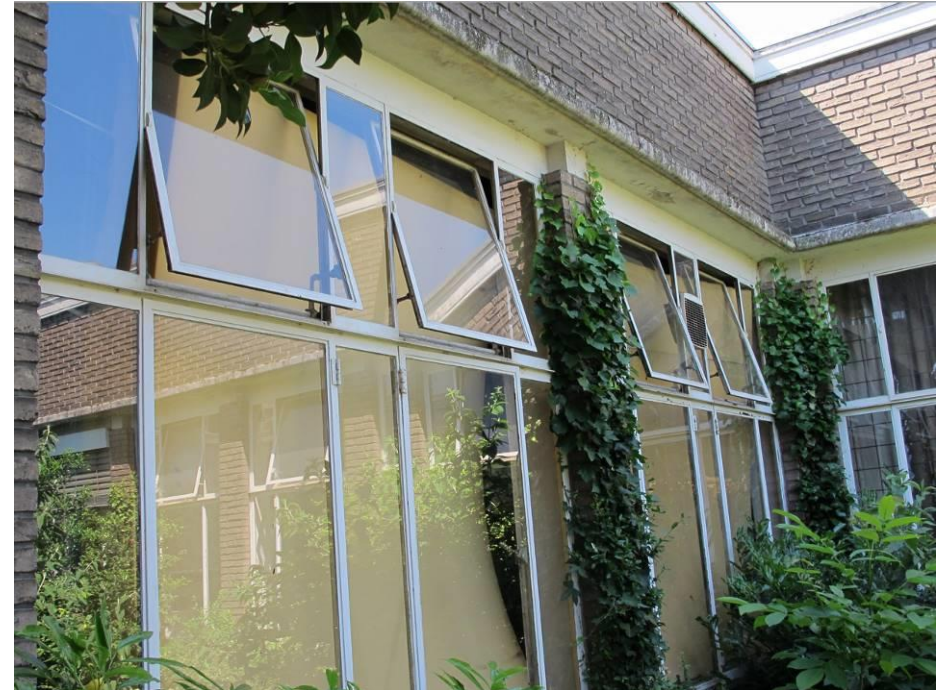
Detail van de stalen vensters in de gevels van de latere westelijke binnentuin
