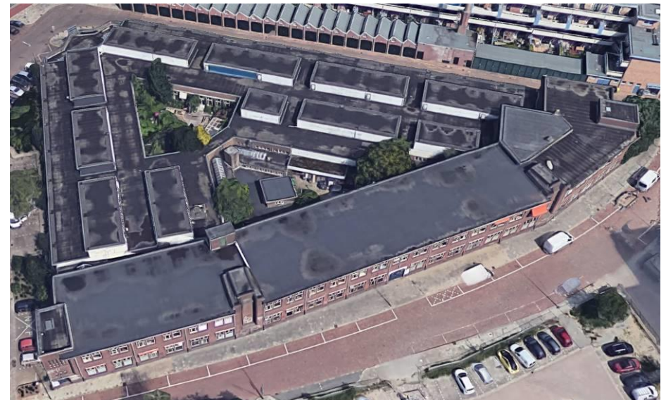
Overzicht van het complex, met op de voorgrond de tweelaags vleugel langs de Gagelstraat, met daarachter de oorspronkelijke binnenplaats. Bron: Google Maps
