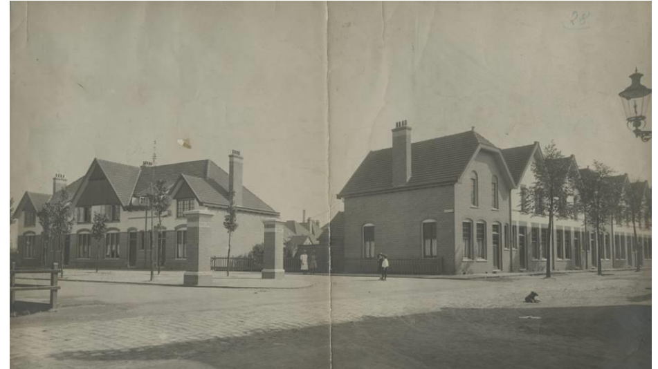
Bij de aansluiting van de Frederiklaan (links) op de Gagelstraat (rechts) markeerden zuilen de toegang tot Philipsdorp. Bron: RHCE, nr. 254040
