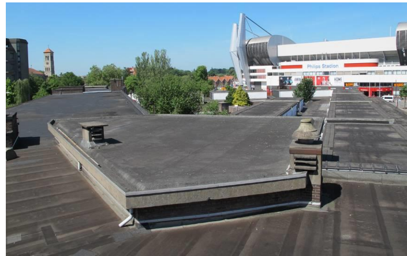
Overzicht van de daken, vanaf het hoofdtrappenhuis in westelijke richting met op de voorgrond het dak met betonnen dakrand van de kluis
