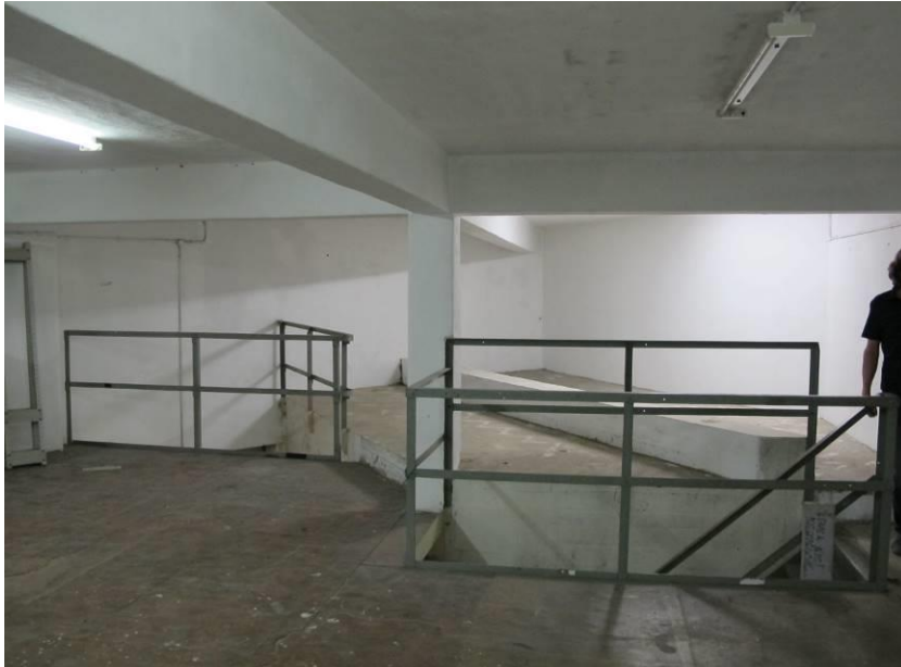
Interieur van de verdieping van de kluis, waar een latere tussenvloer aanwezig is
