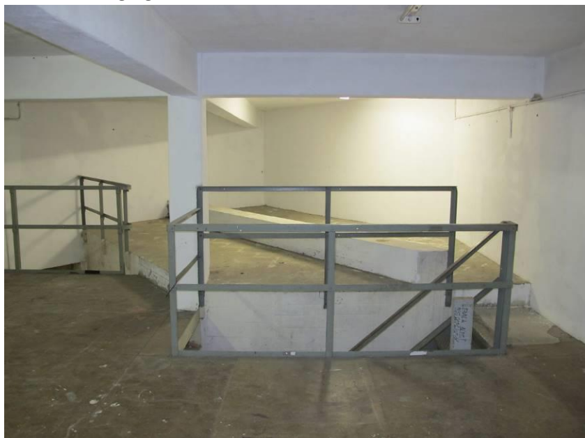
Betonnen draagconstructie van de vroegere kluis
