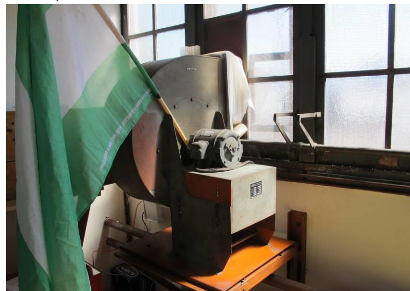
Historische motor van afzuiginstallatie
