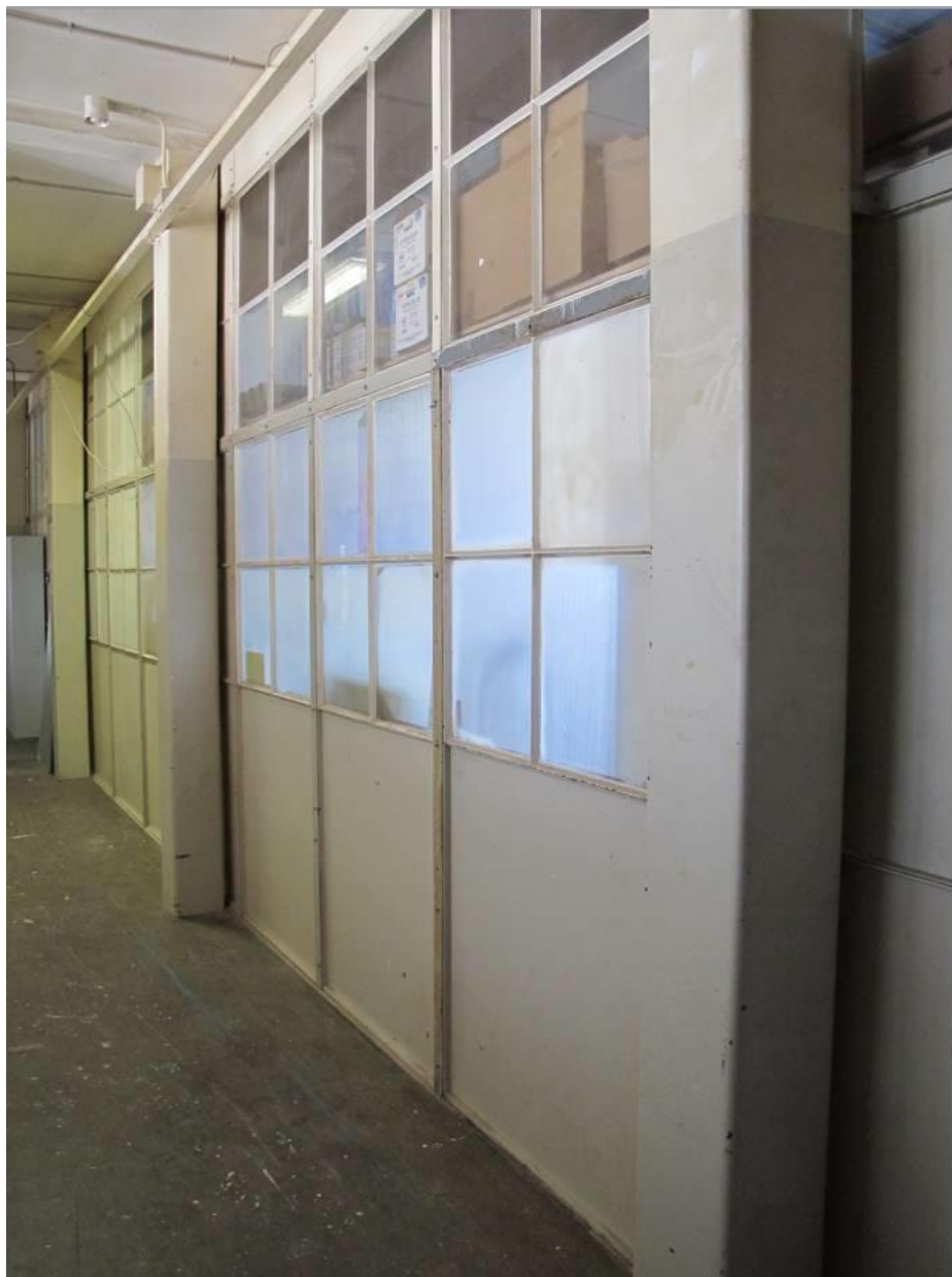
Wat latere, volledig in staal uitgevoerde gangwanden
