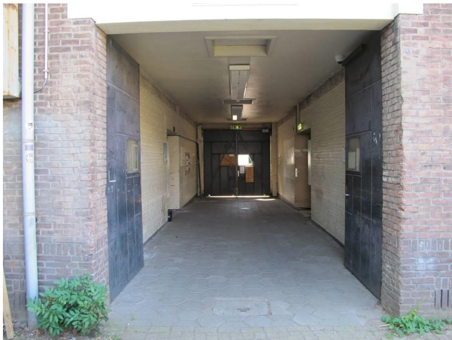
Overzicht onderdoorgang vanaf de binnenplaats
