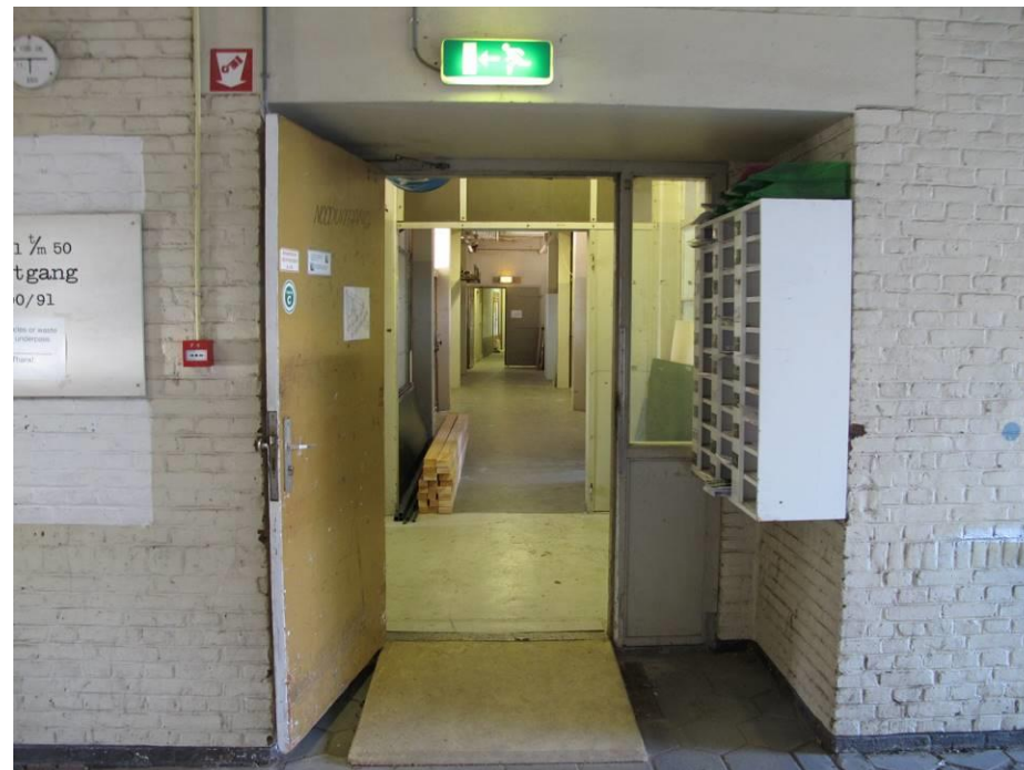
De toegang in de westelijke wand van de onderdoorgang
