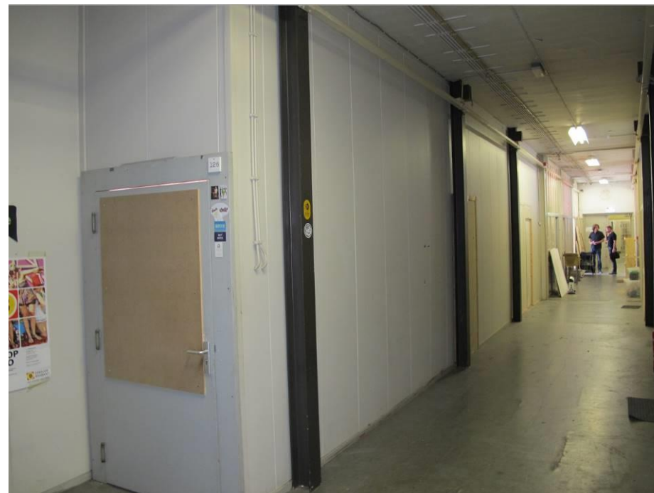
Zone met recente wanden op de verdieping van het tweelaags bouwdeel
