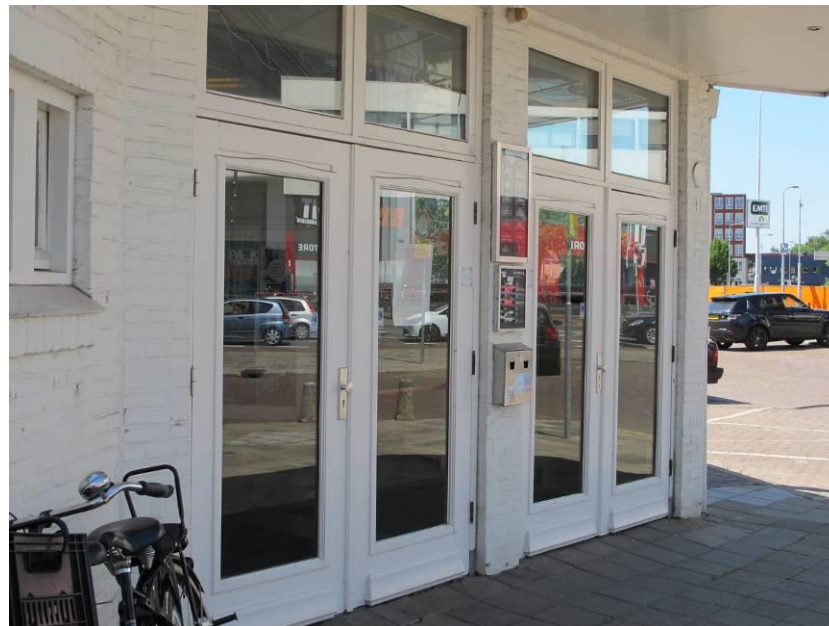
Detail van de in 1941 aangebrachte deuren
