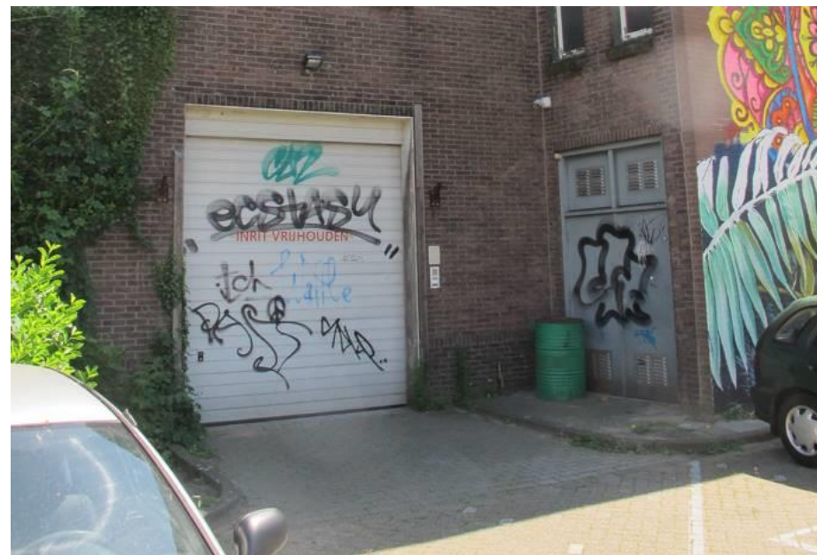
Oorspronkelijke opening, met een vernieuwde roldeur in de westelijke kopgevel van het tweelaags bouwdeel
