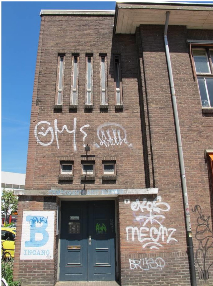
Het westelijke trappenhuis heeft een ten opzichte van de in de gevel geaccentueerde toiletgroepen afwijkende gevelopzet
