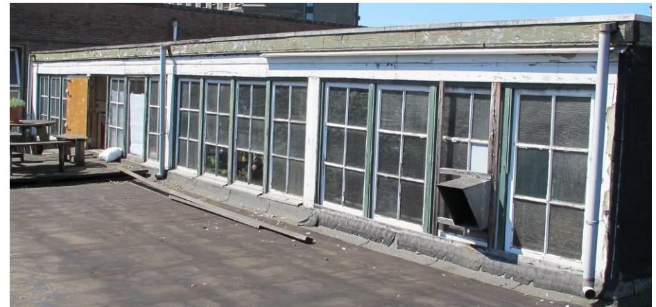
Beeld van één van de dakopbouwen met hierin aanwezige houten tuimelramen
