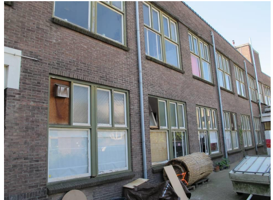
De naar de binnenplaats gerichte achtergevel van het tweelaags bouwdeel
