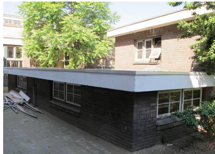
Opbouw van de gevels van het op de binnenplaats gesitueerde ketelhuis
