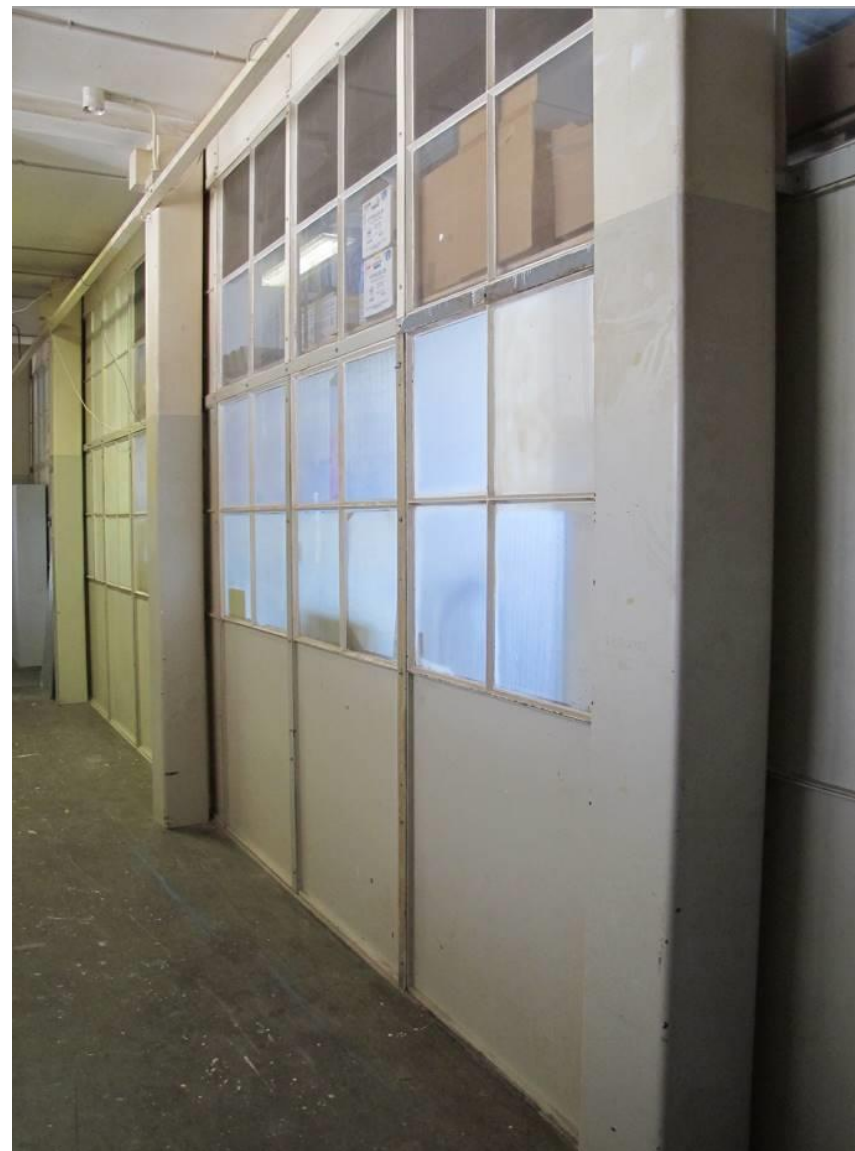
Middengang in het bouwdeel aan de Gagelstraat. Bij dit deel met iets terugliggend geplaatste stalen gangwanden zijn de met beton gevulde stalen kolommen goed zichtbaar. De balklagen en liggers worden door het stucplafond aan het zicht onttrokken.
