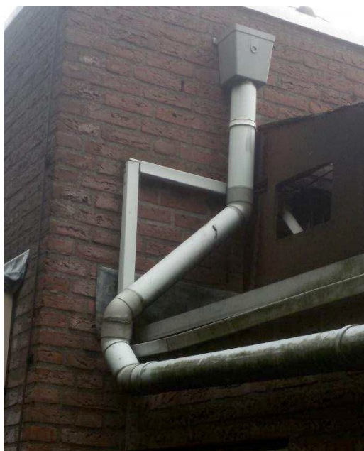
Foto 5: Open stootvoeg in het gebouw Paviljoen. Deze waren ook op meerdere plekken aanwezig en kunnen dienst doen als verblijfplaats voor vleermuizen.
