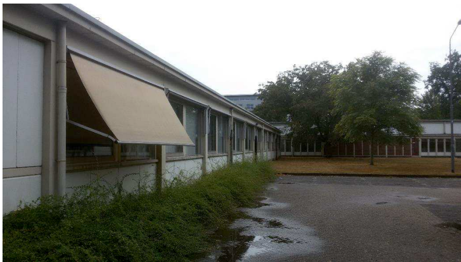
Foto 4: Zonneweringen boven de ramen aan het gebouw Paviljoen die mogelijk dienst doen als verblijfplaats voor vleermuizen.
