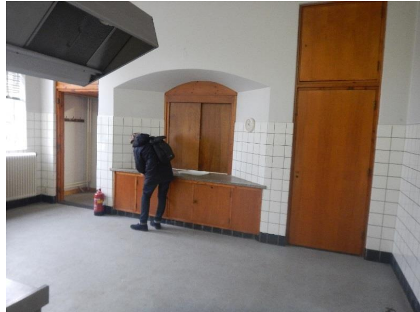
Scheidingswand tussen keuken en refter. Deze wand laat de functionele scheiding tussen beide ruimtes goed zien. Eten moest in alle rust, daarom kon het doorgeefluik worden gesloten. Toen tijdens de 2 e periode minder zusters waren, is op de plek van één van de kasten een doorgang gecreëerd.
