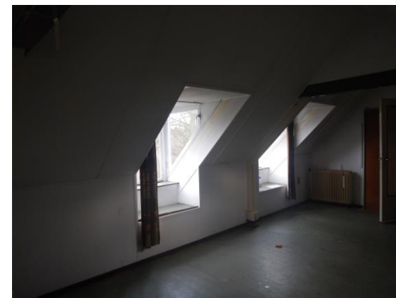
In 1967 werd er een extra werkruimte gecreëerd op zolder (ongeveer boven het Noviciaat). De kapconstructie werd hiervoor aangepast en er werden dakkapellen aangebracht.
