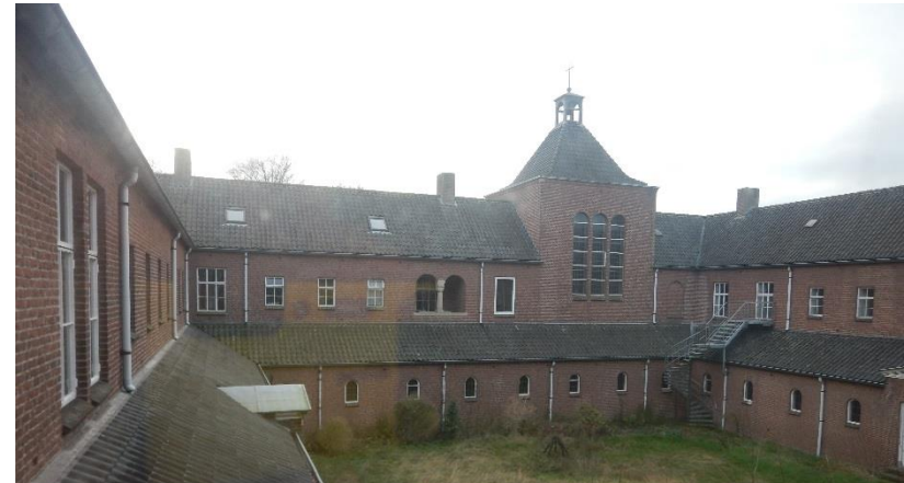
De zuidgevel van het binnenhof.
