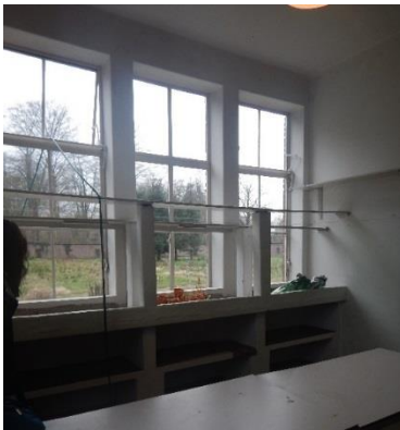
Kweekbakken in de bloemenkamer. Het bovenste deel is een latere toevoeging.
