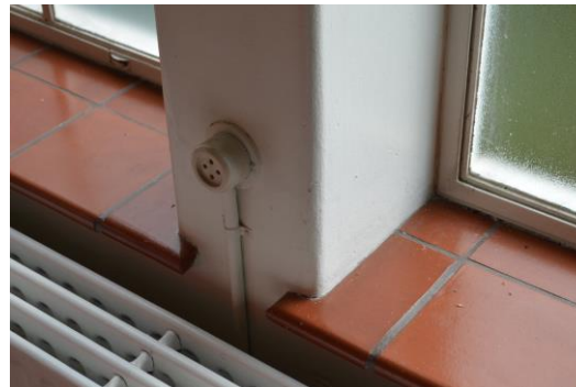
Dit type vensterbank wordt in het gehele gebouw aangetroffen en is oorspronkelijk.
