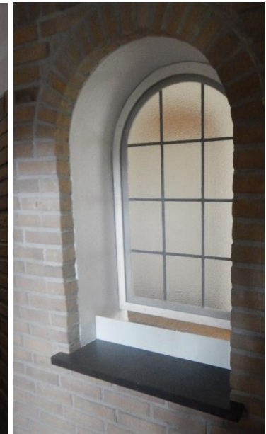
Rondboogvenster met spleet daaronder, tussen de gang van de buitenzusters en de binnengang. Het gaat hier om een latere toevoeging. Dit is te zien aan de verstoring in het metselwerk en het materiaalgebruik.
