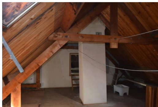
Tussen de zolder van de buitenzusters en de zolder van het Noviciaat is een luik aangebracht. Oorspronkelijk waren deze twee zolders gescheiden.
