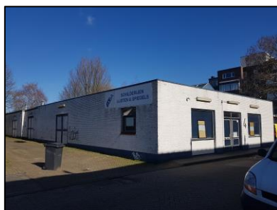
Figuur 7. Zuidoostzijde en zuidwestzijde van pand aan de Zoutstraat 4.
