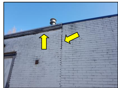
Figuur 12. Ruimte onder daklijst en in dilatatievoeg waar vleermuizen gebruik van kunnen maken.
