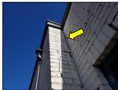
Figuur 11. Spleet tussen muren waar vleermuizen gebruik van kunnen maken.
