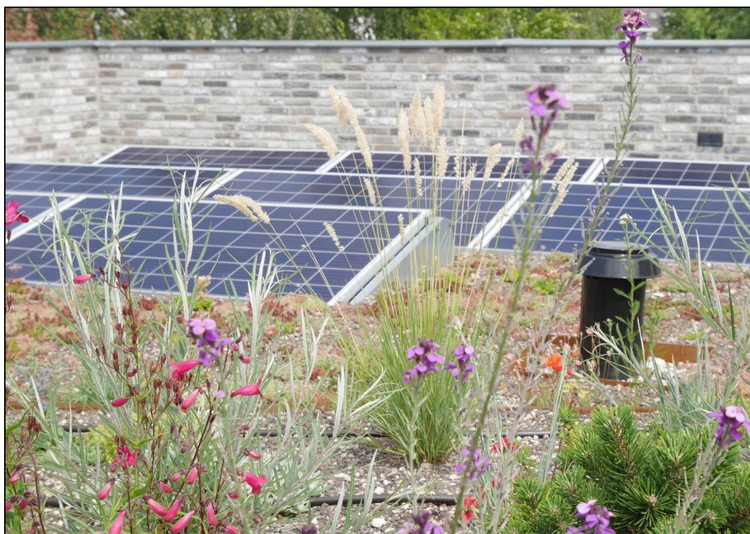
Foto 11: 'Natuurdak'-dakbegroeiingssysteem i.c.m. PV-panelen
