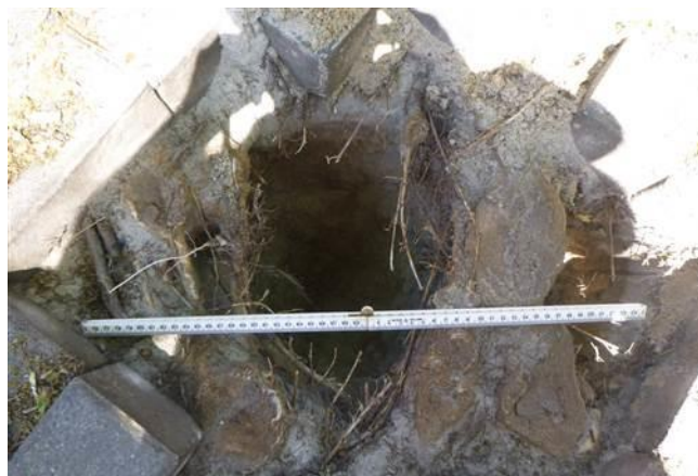
Afbeelding 8: detail beworteling onder verharding
