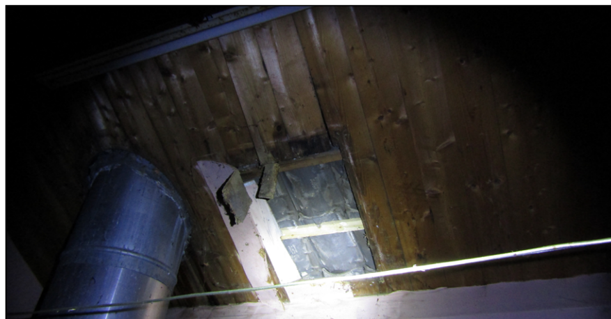
Figuur: het dak van binnenuit gezien: er is ruimte tussen de verschillende daklagen (pannen en hout).
