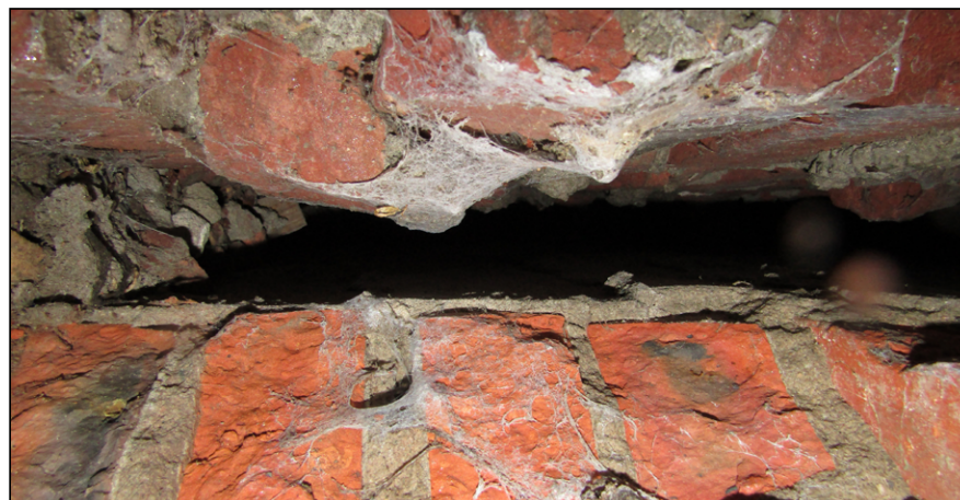
Figuur: de luchtspouw vanuit het gat in de muur gezien.
