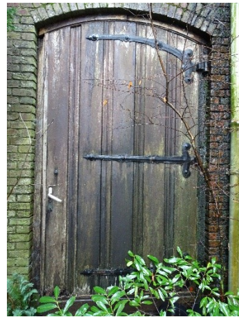
Afb. 46, Noordgevel, toegangsdeur naar altaarkapel
