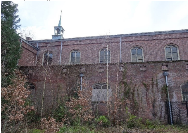
Afb. 43, Noordgevel, middenbeuk en gang
