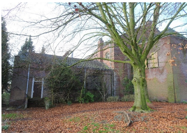
Afb. 37, Oostgevel, uitbouw sacristie
