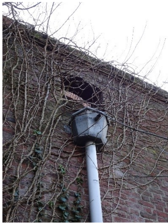
Afb. 45, Noordgevel, hemelwaterafvoer
