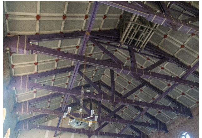
Afb. 48, Middenbeuk, spantconstructie
