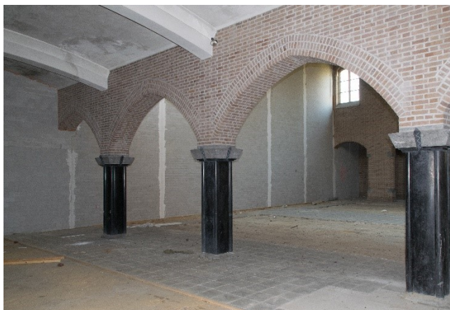
Afb. 59, Zijbeuk, zicht naar scheidingsmuur
