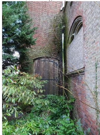
Afb. 44, Noordgevel, toegangsdeur naar altaarkapel
