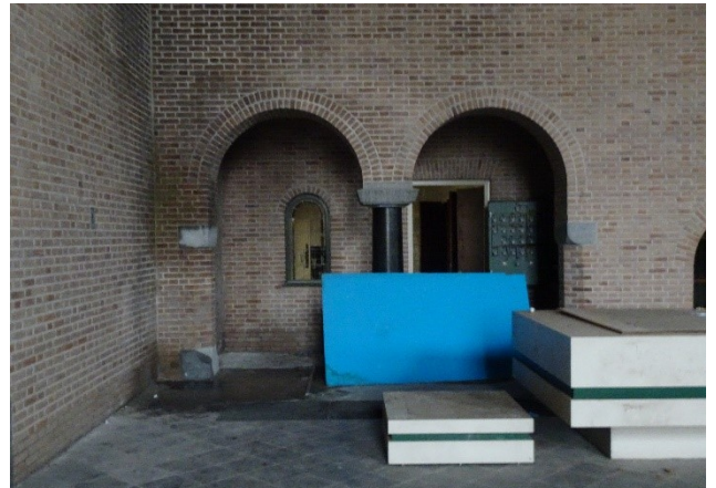
Afb. 52, Priesterkoor, toegang naar sacristie
