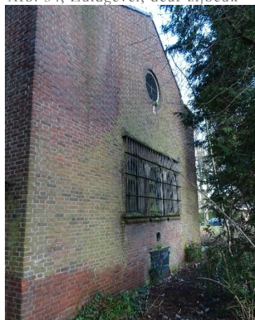
Afb. 36, Zuidgevel, topgevel hulpsacristie
