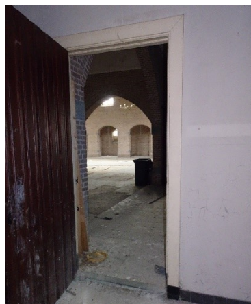
Afb. 62, Zijaltaar, zicht vanuit portaal
