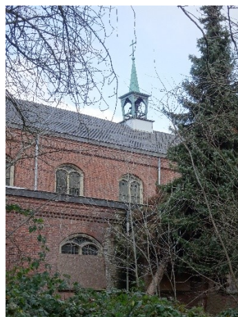
Afb. 32, Zuidgevel met dakruiter
