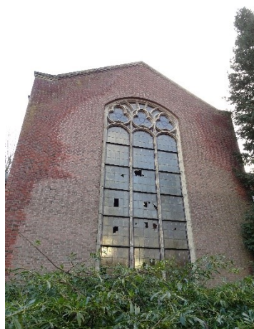
Afb. 42, Noordgevel, uitbouw altaarkapel
