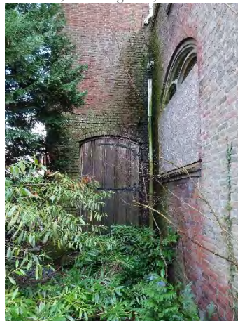
Afb. 44, Noordgevel, toegangsdeur naar altaarkapel
