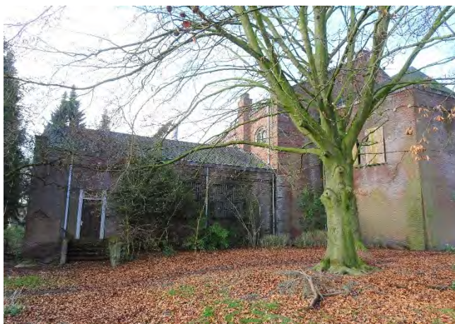
Afb. 37, Oostgevel, uitbouw sacristie
