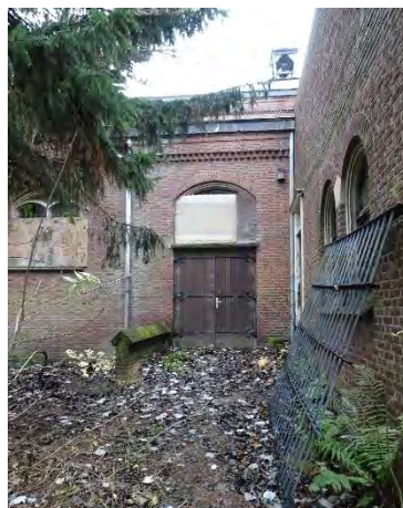
Afb. 34, Zuidgevel, deur zijbeuk
