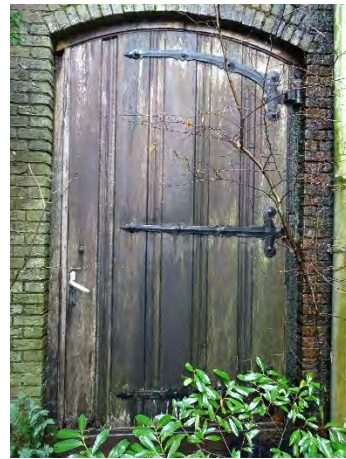
Afb. 46, Noordgevel, toegangsdeur naar altaarkapel
