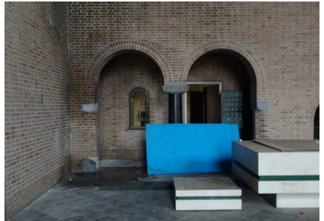
Afb. 52, Priesterkoor, toegang naar sacristie
