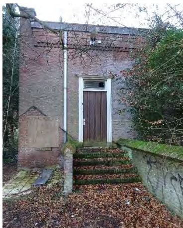
Afb. 39, Oostgevel, toegang hulpsacristie
