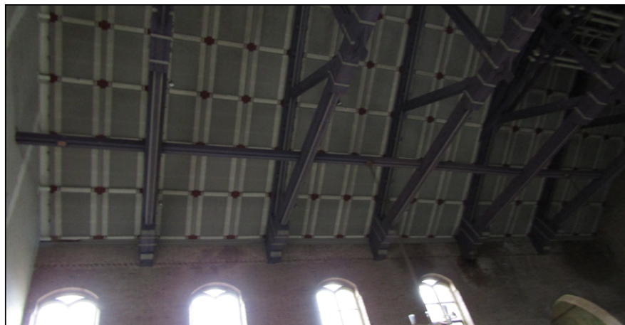
Figuur: de binnenzijde van de kerk was volledig inspecteerbaar en er zijn geen vogelnesten aangetroffen.
