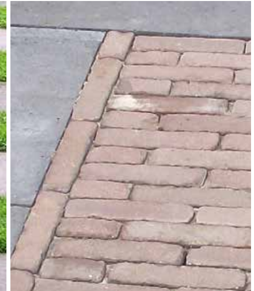
Bestratingspatroon dek klinkervak afgesloten met betonstenen
