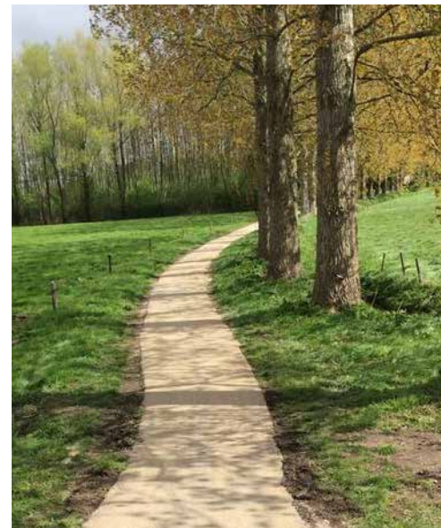
Paden langs de speelplek in halfverharding: type KOERS KoMex
