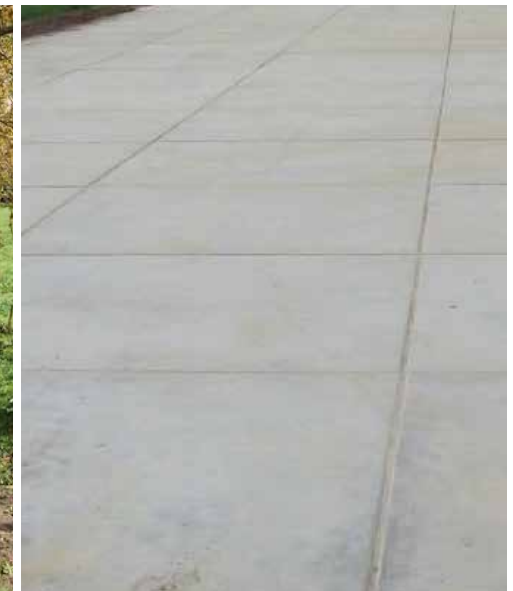
Sportvelden op stelconplaten 2x2m, hergebruik.
