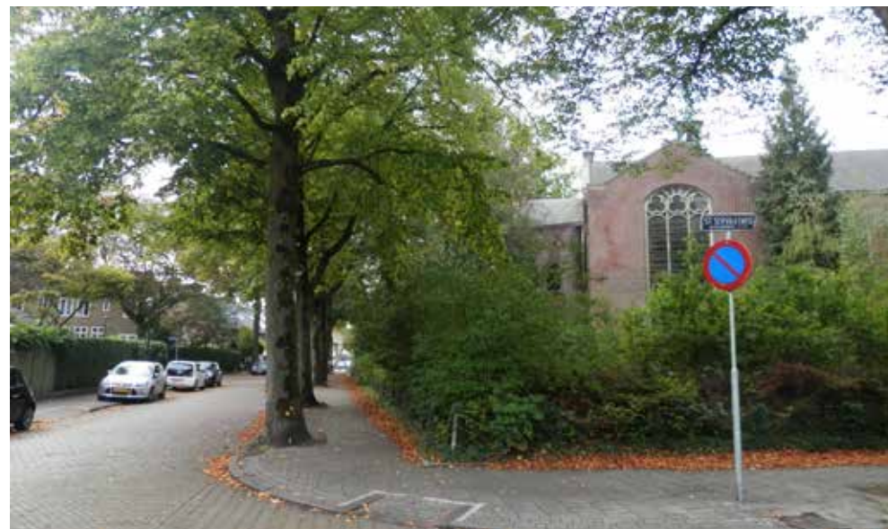
Zicht vanaf de kruising van de Sint Adrianusstraat en de Sint Servaasweg op de zijgevel van de Fatimakerk
