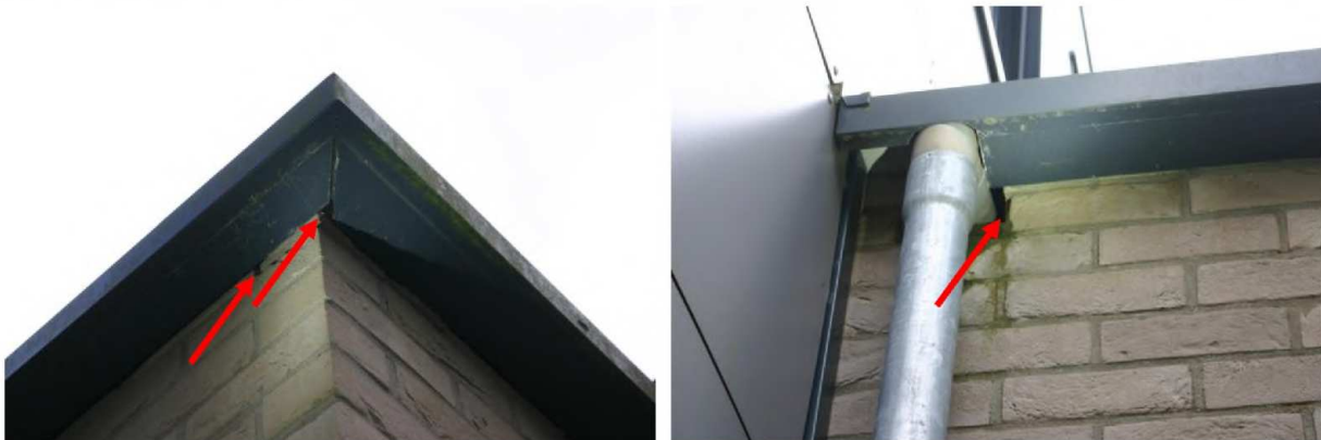
Figuur 4.4.2. Het schoolgebouw met het platte dak (5 in figuur 4.1.1) heeft diverse openingen waar vleermuizendoor naar binnen kunnen (aangeduid met rode pijlen).
