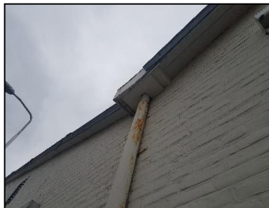
Figuur 6. Ruimte tussen regenpijp en houten ombouw dakgoot.
