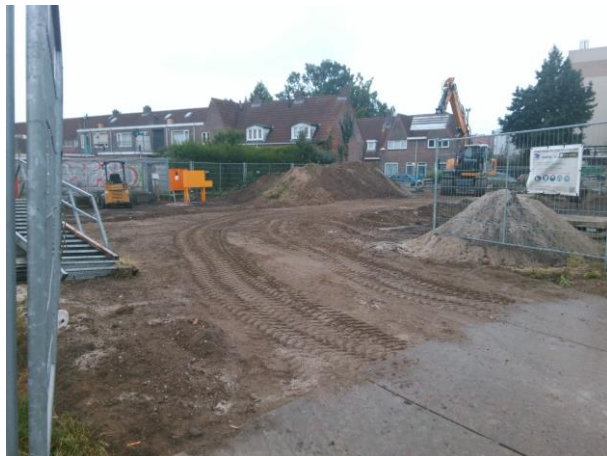
Fotonummer: 8 Omschrijving: Foto-opnamepunt 01
