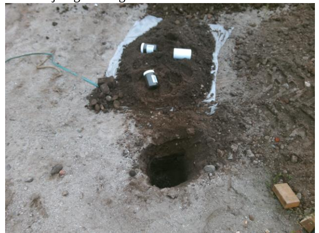
Fotonummer: 4 Omschrijving: Boring 104
