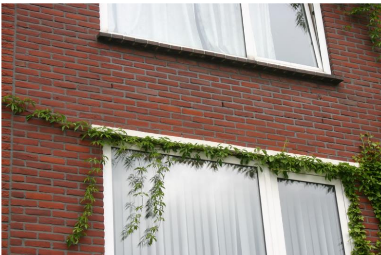
Figuur 4.5.4. De woningen aan de Kronehoefstraat bevatten op en stootvoegen op zo'n 4 meter hoogte.
