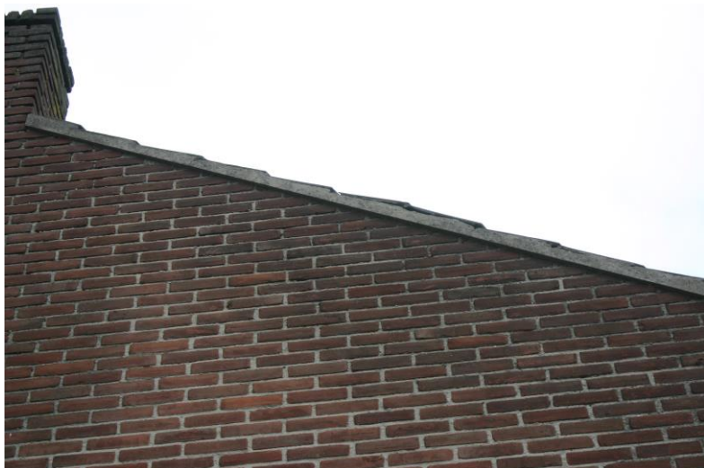
Figuur 4.5.1. De gevelpannen op de woningen aan de Van Brakelstraat liggen in de specie.
