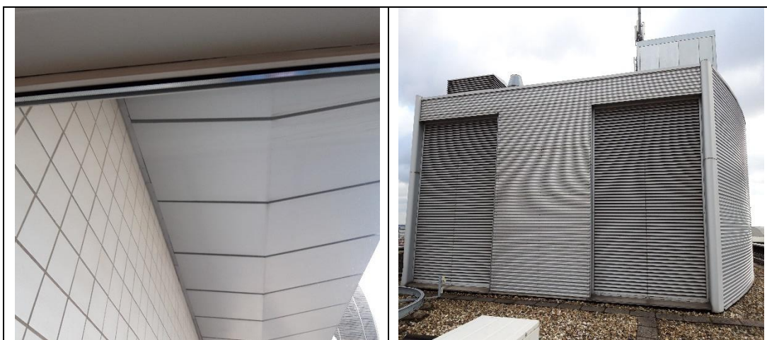
Afbeelding 5: Kenmerkende strakke afwerking aan zijkant en op dak gebouw (Aveco de Bondt, 2019).
