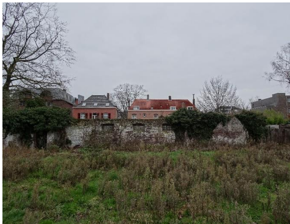
Afb. 47. Restmuur van de noordgevel van de sigarenfabriek, rechts
