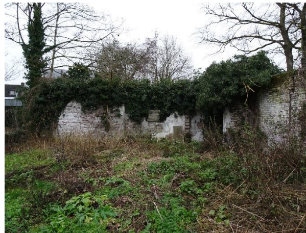
Afb. 48. Restmuur westgevel, midden
