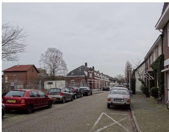
Afb. 42. Zicht op Stuiwerstraatnr. 82-88
