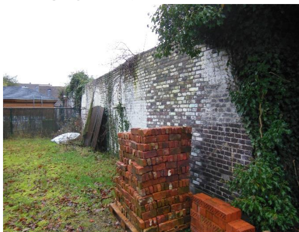
Afb. 58. Muur vanaf villatuin (foto Bauke Hüsken d.d. 3-1-2020)
