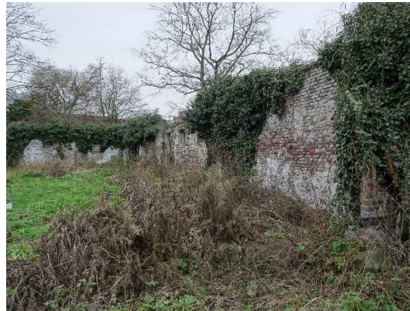
Afb. 50. Fabrieksmuren noord- en westzijde
