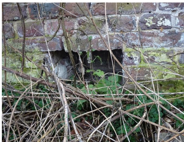
Afb. 56. Opening aan onderzijde van de muur
